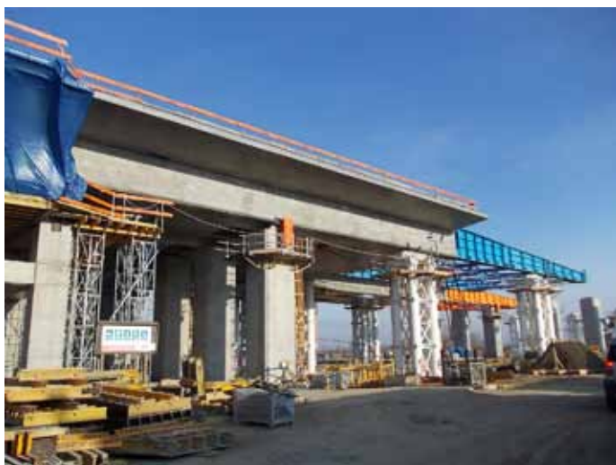
Stanowisko nasuwania podłużnego
