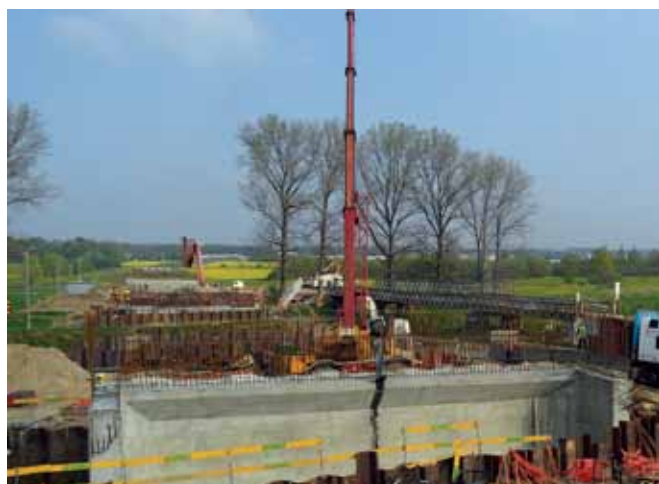
Rys. 7 i 7a. Widok budowy od polskiej strony
