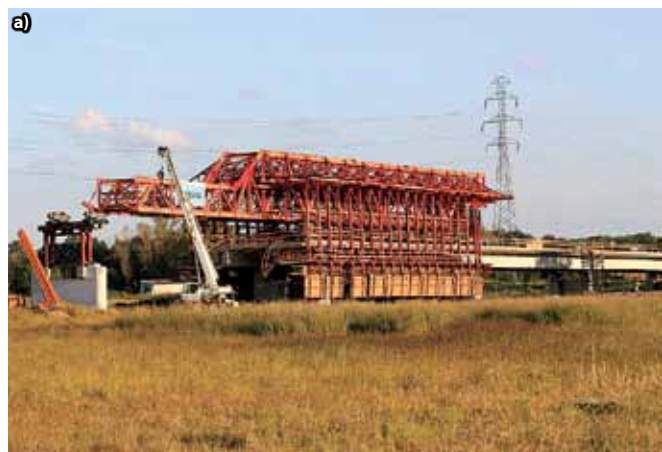
Rys.7. Przejazd rusztowania krocącego – 2 dzień cyklu: a) wózek z otwartymi panelami przygotowany do przejazdu, b) przejazd rusztowania na kolejny segment.
