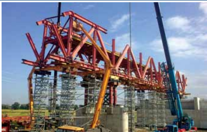
Rys.6. Montaż wózka rusztowań kroczących
