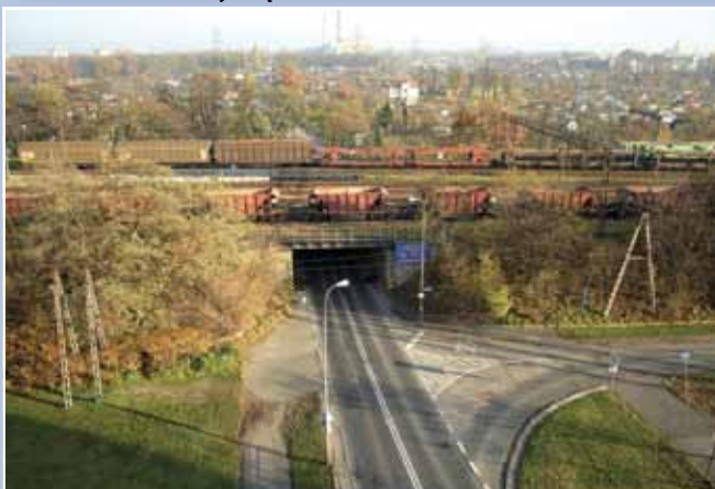
Wiadukt nad ul. Popowicką
