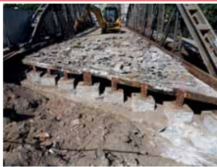
Fot. 1,2 Most północny w trakcie rozbiórki istniejącej płyty pomostowej (po lewej) i po jej zakończeniu (po prawej)
