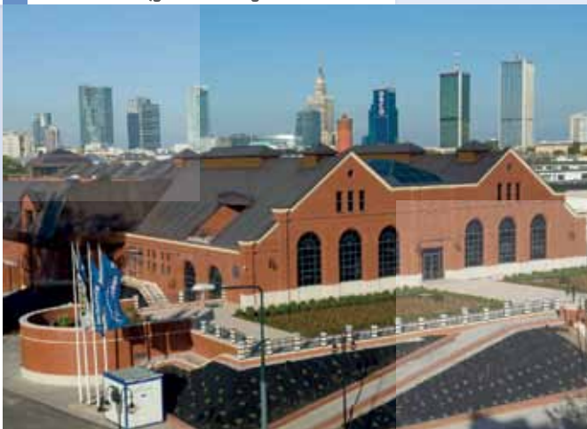
3 Zakład Wodociągu Centralnego w Warszawie
