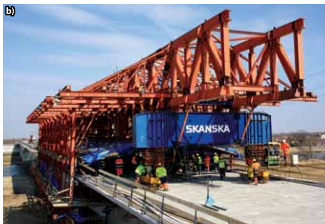
Rys.7. Przejazd rusztowania krocącego – 2 dzień cyklu: a) wózek z otwartymi panelami przygotowany do przejazdu, b) przejazd rusztowania na kolejny segment.
