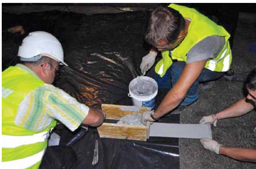
Rys. 2. Nakładanie kleju Adesilex PG1 na taśmę z włókien węglowych Carboplate – przejście podziemne pod drogą krajową nr 1 we Włocławku
