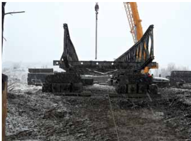
Rys. 1. Nasuwanie mostu tymczasowego
