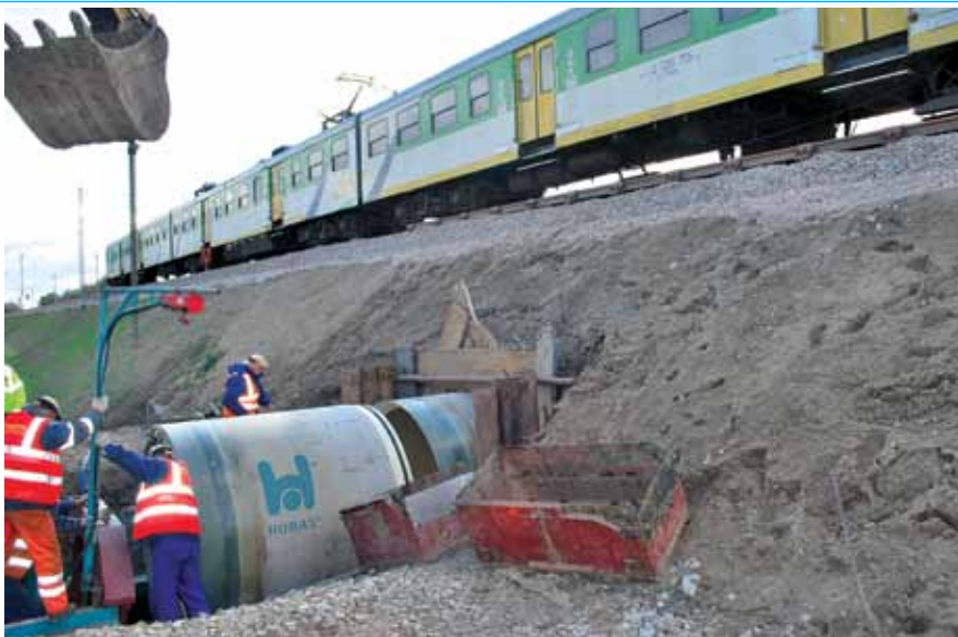
Rys. 3. Przepust OD2047, E65 LCS Ciechanów, odcinek Gąsocin - Ciechanów
