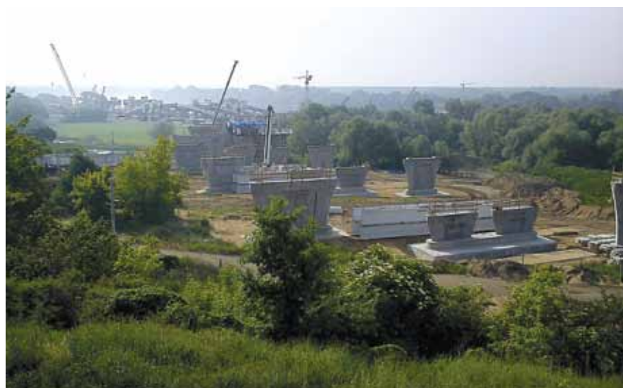
Fot. 1. Widok ze skarpy wiślanej prawego brzegu na układ podpór estakad E-1, E-2 dojazdu do mostu. Fot. Małgorzata Tandejko
