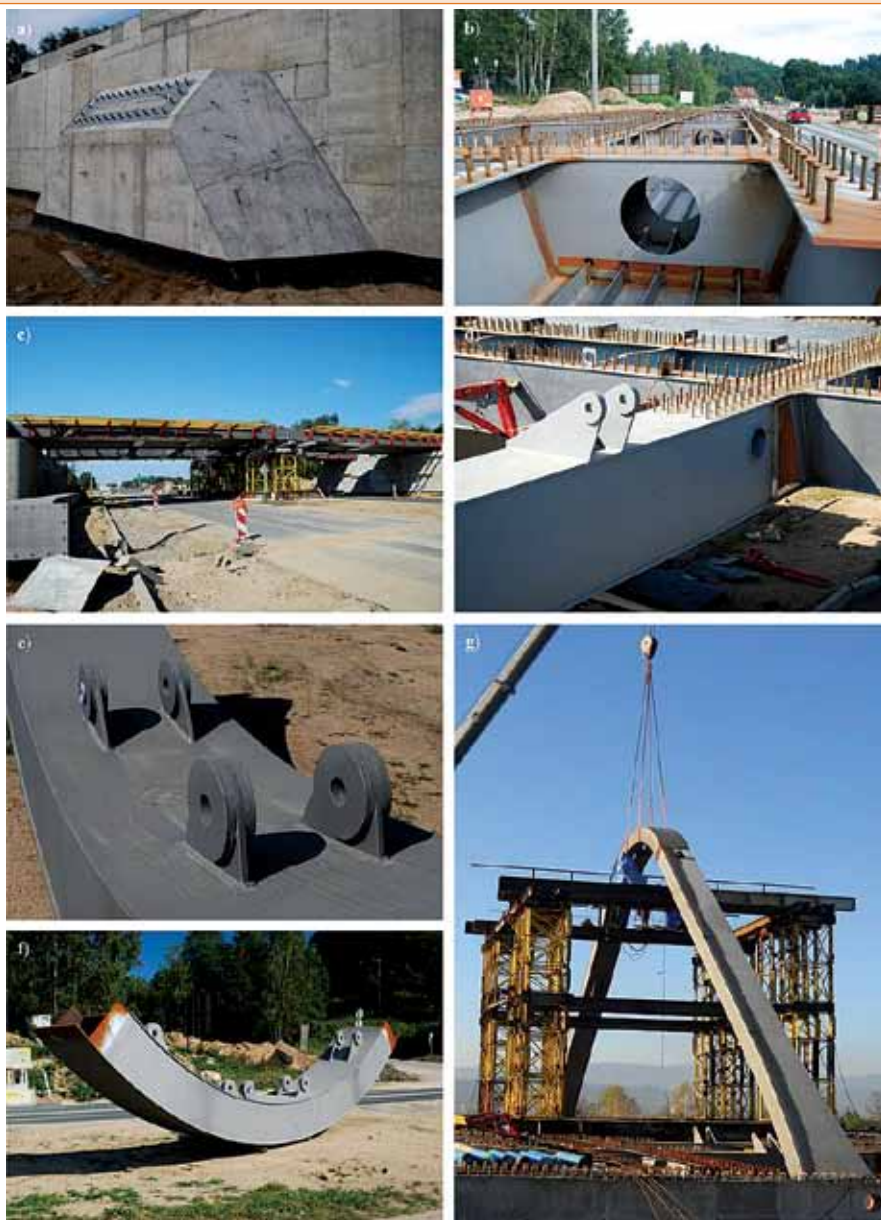
Rys. 3. Budowa wiaduktu nad ulicą Konstytucji 3 Maja w Jeleniej Górze (realizacja w 2011 roku): a) widok przyczółka, b) montaż konstrukcji ustroju nośnego, c) zmontowane stalowe elementy prześel, d)÷f) detale konstrukcyjne, segmenty przywiezione z wytwórni w Bydgoszczy, g) zmontowany łuk.
