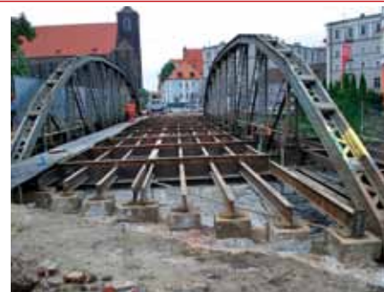
Fot. 1,2 Most północny w trakcie rozbiórki istniejącej płyty pomostowej (po lewej) i po jej zakończeniu (po prawej)
