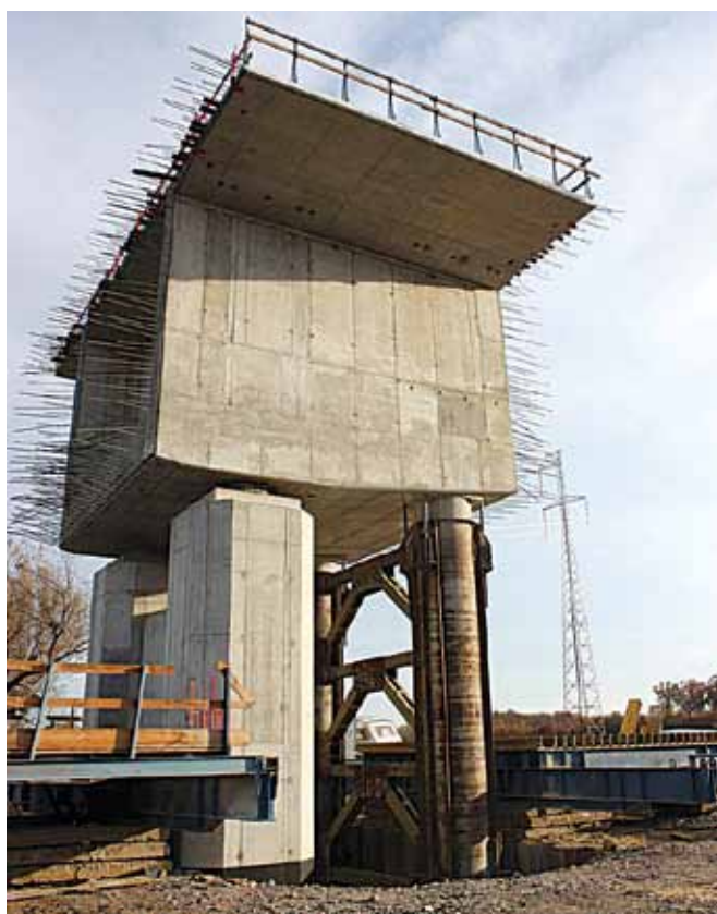
Rys.9. Podpora tymczasowa i segment startowy
