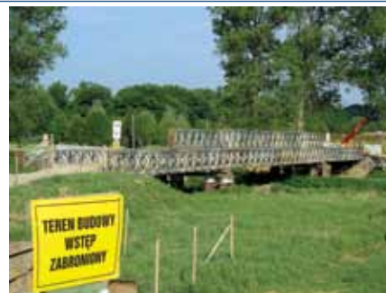
Rys. 3. Widok mostu tymczasowego z polskiego brzegu
