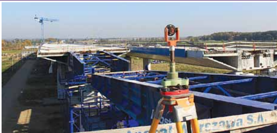
Rys. 3. Lustro w trakcie nasuwania ustroju nośnego
