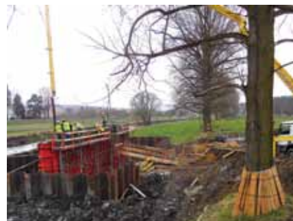
Rys. 6. Betonowanie korpusu podpory P4
