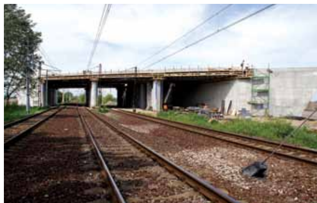
Rys. 10. Wiadukt nad PKP - Widok od strony stacji Siechnice
