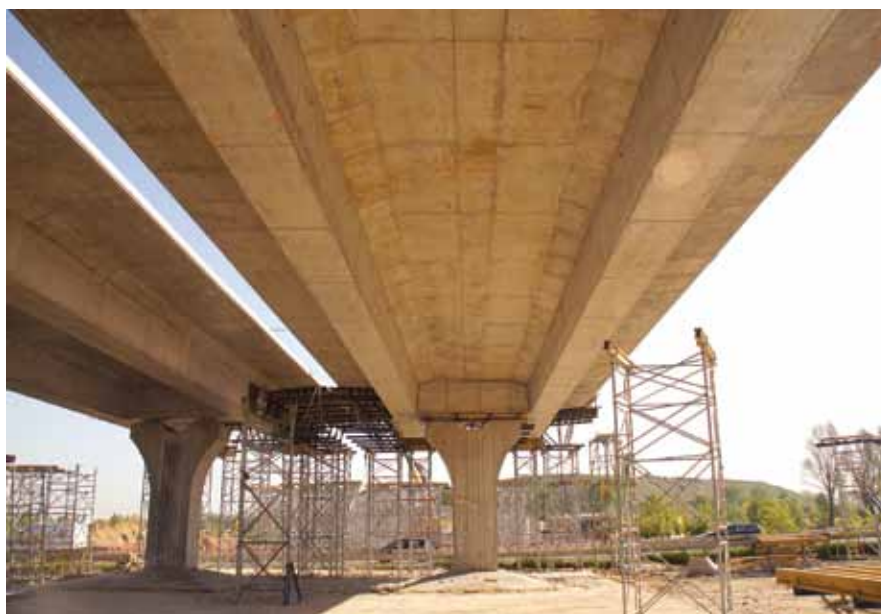
Rys. 6. WD-1 Ustrój nośny Etap I, po rozszalowaniu
