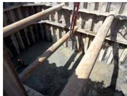
Rys. 4. Wykop pod podporę P5 z widocznym rozparciem w dwóch poziomach
