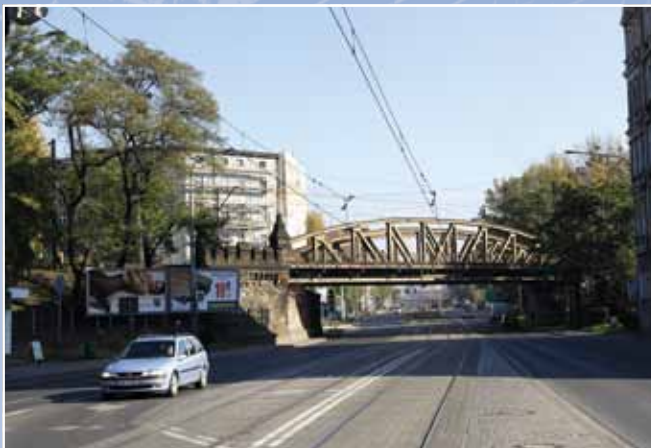
Wiadukt nad ul. Grabiszyńską
