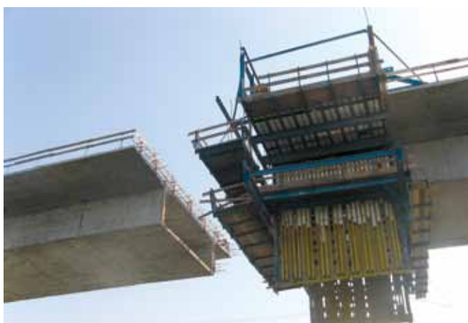
Rys.11. Budowa zwornika mostu nawisowego
