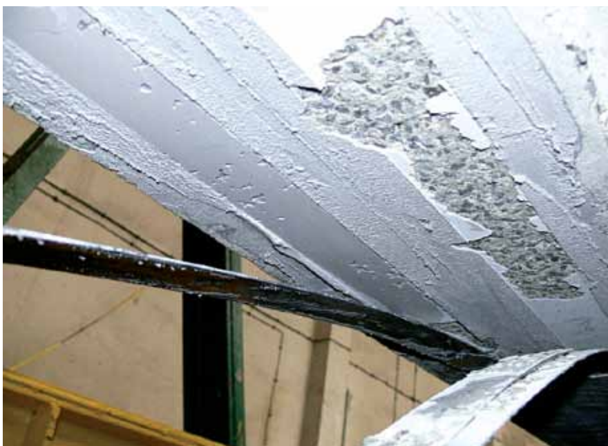
Rys. 4. Widoczne odspojenie taśmy od powierzchni kleju
