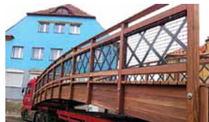
Fot. 5. Przyjazd kładki z naszej Fabryki z Lathen w Niemczech oddalonej o prawie 900 km od miejsca budowy.
