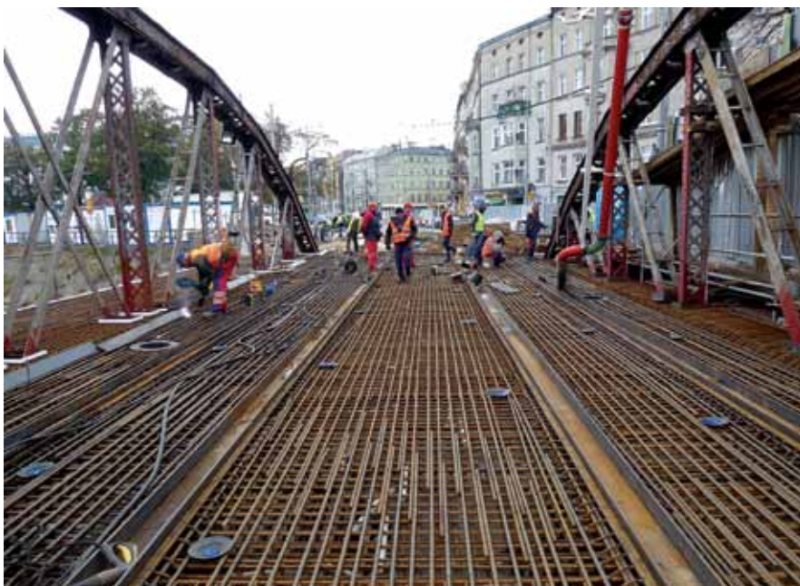
Fot. 9 Zbrojenie płyty pomostowej przed ułożeniem mieszanki betonowej
