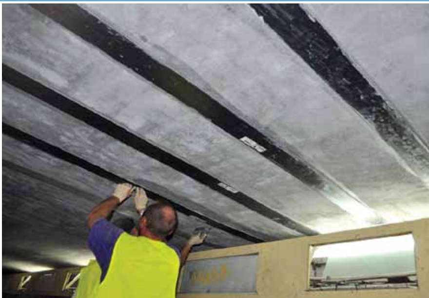
Rys. 3. Wklejanie taśm z włókien węglowych CarboPlate – przejście podziemne pod drogą krajową nr 1 we Włocławku
