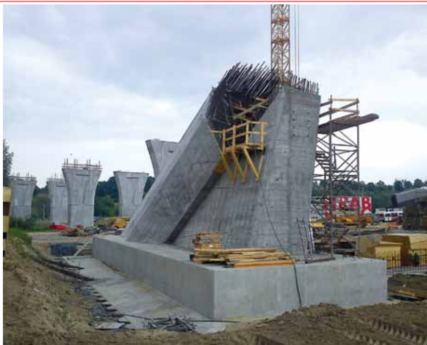
Fot. 3. Rys. wykonanych elementów betonowych węzłowi w Fazie I. Foto. Małgorzata Tandajko
