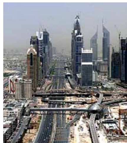
Rys. 1. Kładki nad drogą Sheikh Zayed w Dubaju, [1].
