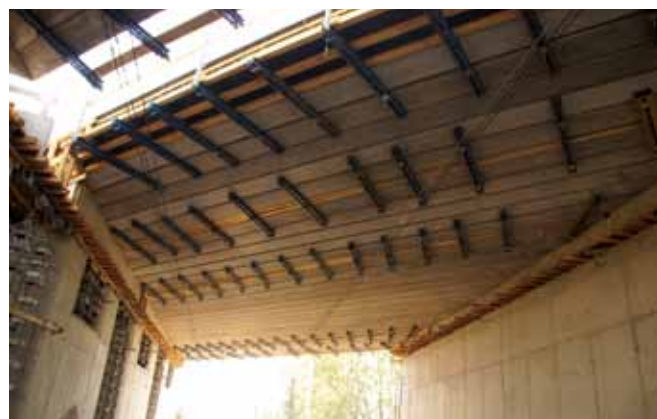
Rys. 8. Wiadukt nad PKP - szalowanie ustroju
