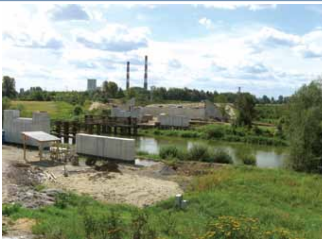
Rys.4. Montaż podparć i szalunków na moście MD-2
