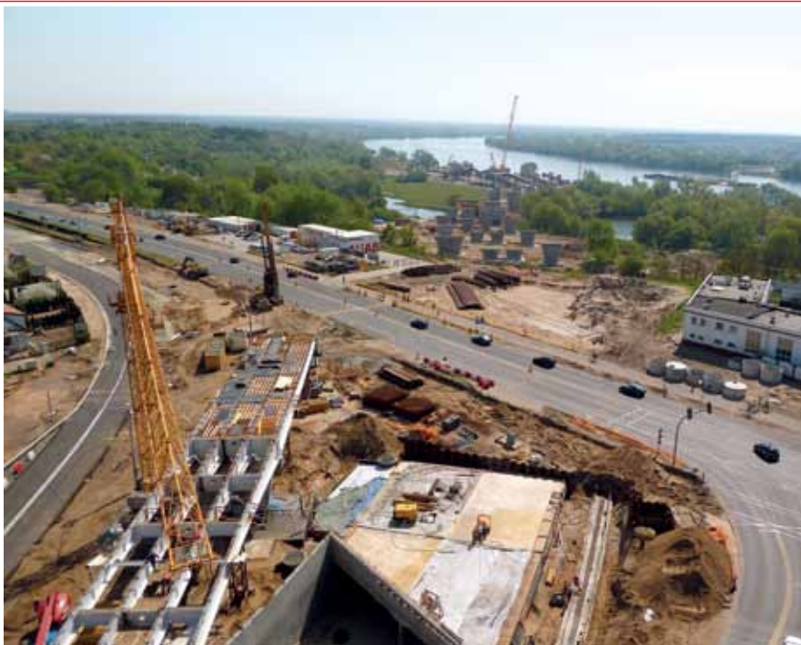
Fot. 6. Plac Daszyńskiego z widoczną zmontowaną w etapie I stalową konstrukcją prześel wiaduktu podwieszonego - estakady Żółkiewskiego, przerzuconej nad wykonanym tunelem T-1 i T-2. Foto. Małgorzata Tandajko.
