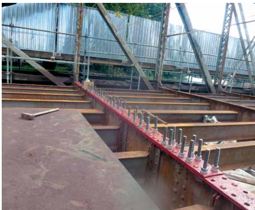
Fot. 4 Układ łączników zespalających na poprzeczni (jeszcze przed montażem łączników na części skrajnej i nakrętek spełniających funkcję główek)
