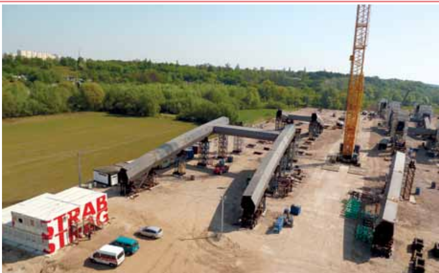
Fot. 4. Plac montażowy na którym wykonuje się scalanie elementów stalowych łuków Foto. Małgorzata Tandejko
