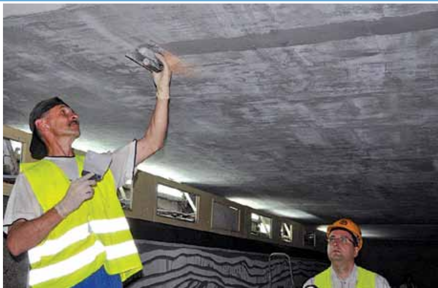
Rys. 1. Nakładanie kleju epoksydowego Adesilex PG1 na przygotowane podłoże, naprawione wcześniej zaprawą Mapegrout 430 – przejście podziemne pod drogą krajową nr 1 we Włocławku
