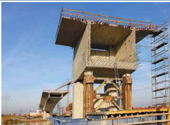
Rys.10. Budowa drugiego wahadła mostu
