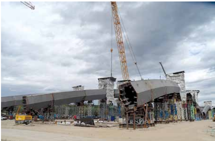
Fot. 5. Konstrukcja podpór to zestawy rusztowań prefabrykowanych klatek z rur stalowych. Montaż łuku odbywa się w pozycji docelowej z właściwym pochyleniem w kierunku poprzecznym równym 10°. Foto. Małgorzata Tandejko
