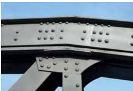
Fot. 7 Nity poprawnie wykonane (Most Młyński Południowy)
