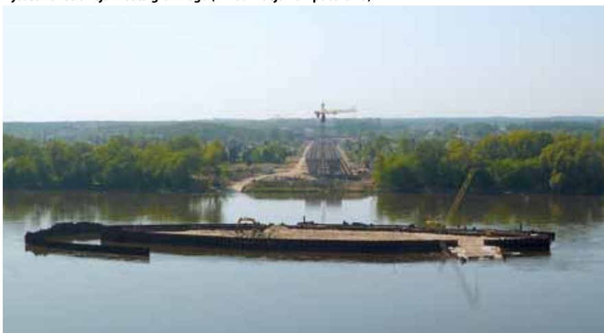
Fot. 2. Budowa sztucznej wyspy dla posadowienia podpory środkowej z widokiem na wykonane konstrukcje stalowe dla zespolonych estakad lewobrzeżnych E-3 i E-4. Foto. Małgorzata Tandajko.
