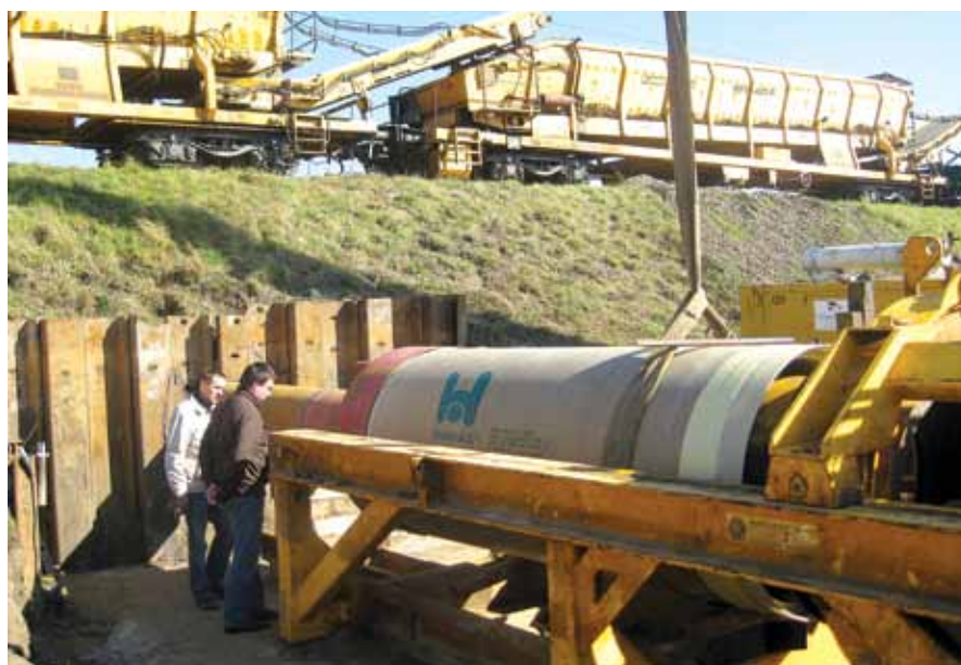
Rys. 2. Przepust OD1280, E65 LCS Działdowo odcinek Gralewo - Rybnio
