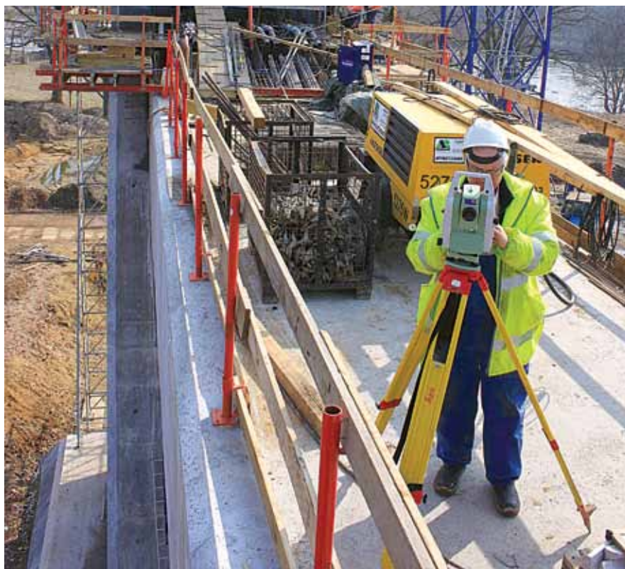
Rys. 2. J.Frask w trakcie pomiaru na ryglu dolnym pylonu
