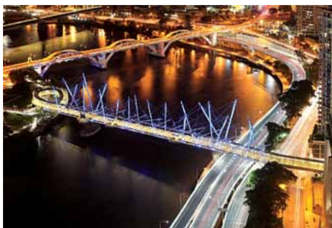
Rys. 13. Kładka typu tensegrity w Brisbane, Australia, [1].
