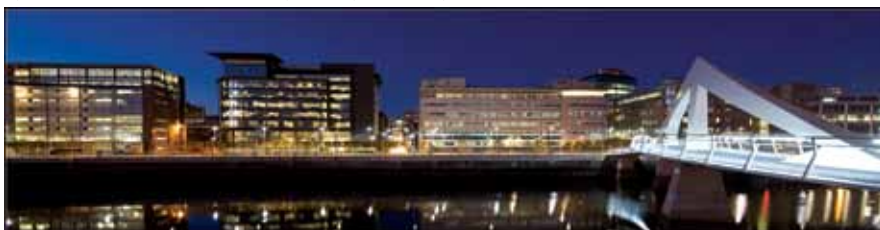
Rys. 6. Kładka Tradestone w Glasgow w Szkocji, [1].
