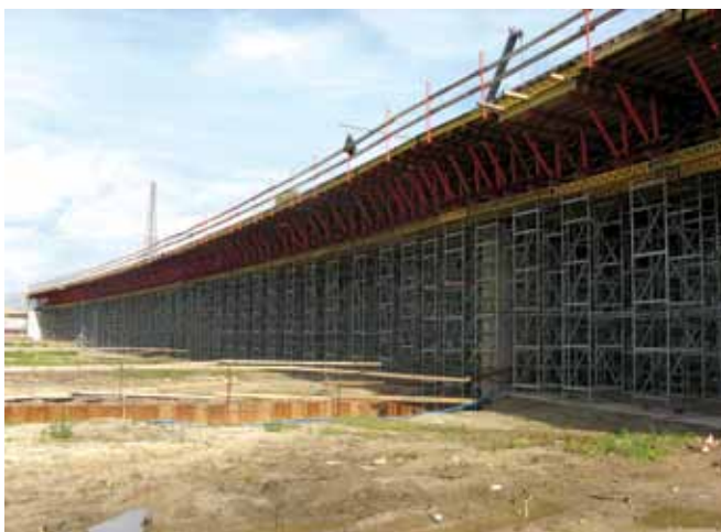
Rys.5. Rusztowanie podporowe i deskowanie ustroju nośnego mostu MD-3
