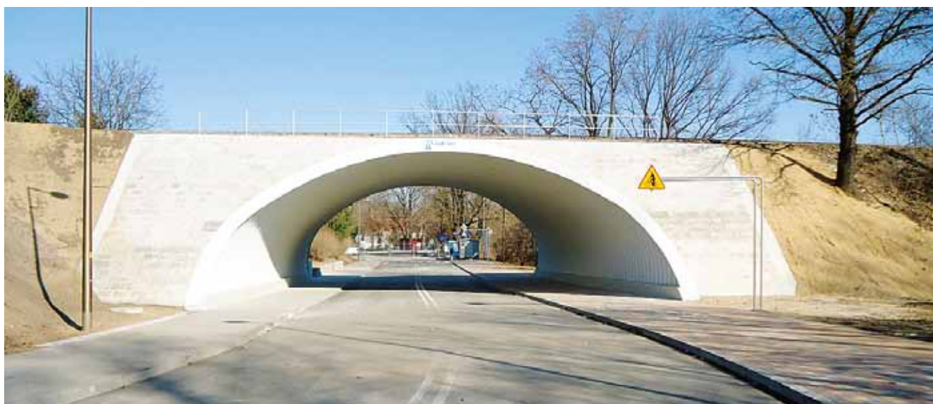
Fot.6. Wykonany obiekt przy ul. Sprzymierzeńców i Polna Droga.
