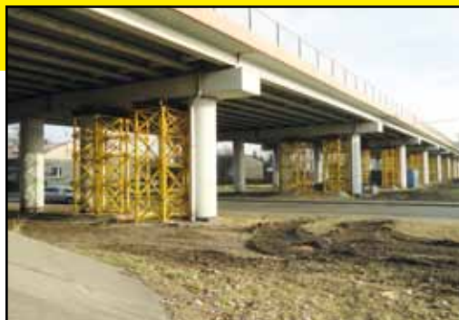
Przebudowa wiaduktów w ciągu DK-94 Inwestor: Gmina Dąbrowa Górnicza
