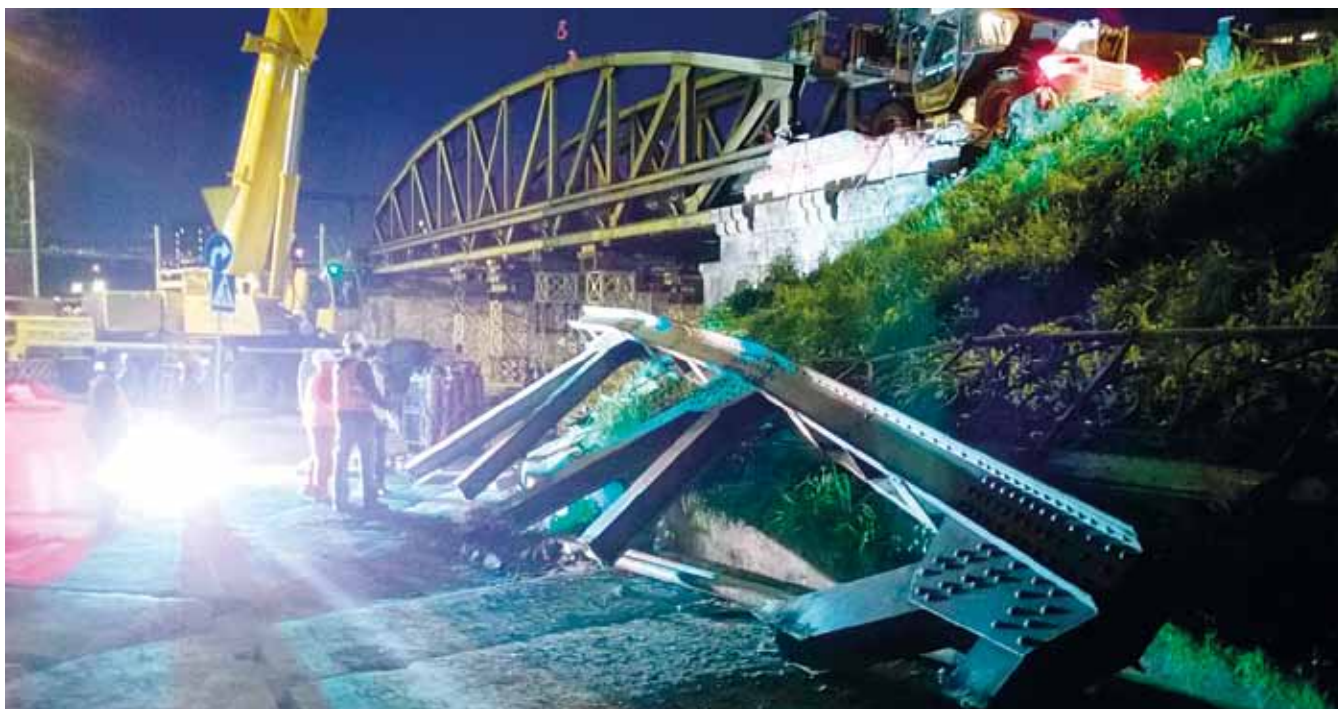
Ryc. 4. Usunięty element dźwigara głównego przed podziałem do dalszego transportu. Widok od strony ul. Wysokiej.
