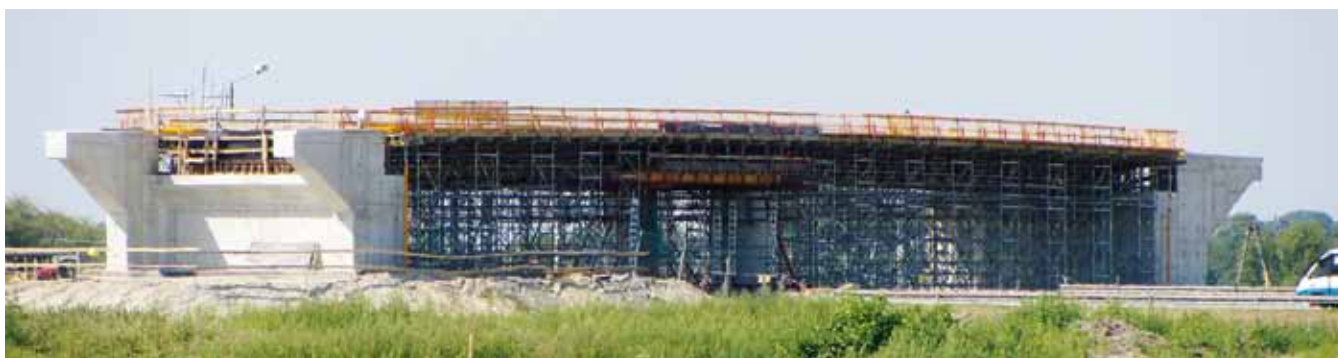
Rys. 6. Budowa ustroju nośnego wiaduktu drogowego (sierpień 2013r.)
