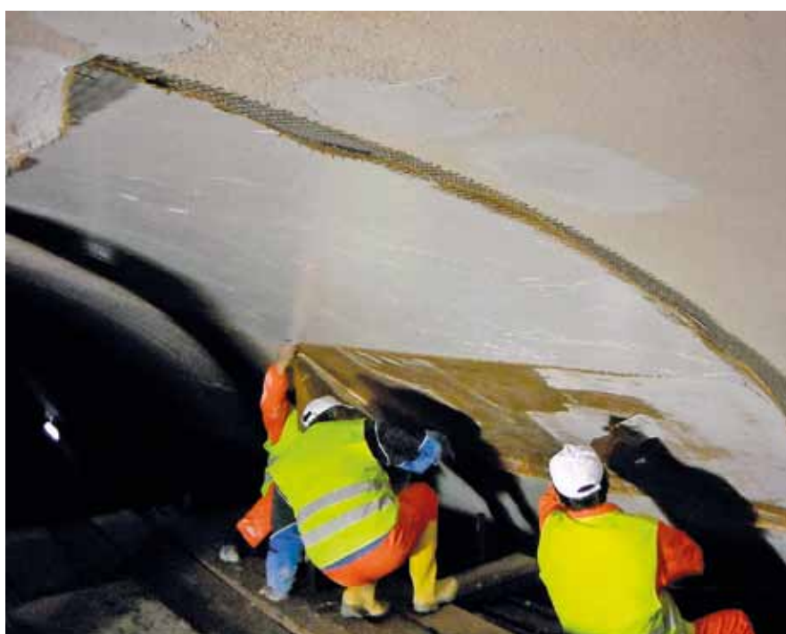
Fot. 4. Wzmocnienie tunelu w ciągu autostrady Egnatia – Odos w Grecji
