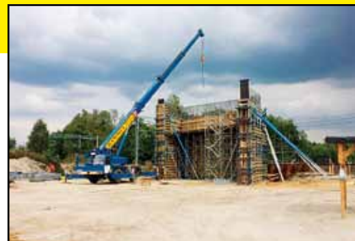
Budowa Zachodniej Obwodnicy Radomska Inwestor: Miasto Radomsko
