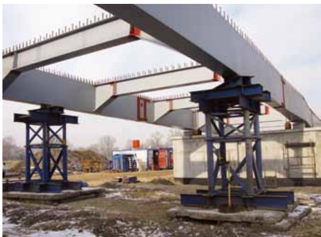
Fot. 3 Widok z poziomu terenu zalewowego na ruszt stalowy pomostu i podpory tymczasowe usytuowane – styczeń 2014 r.
