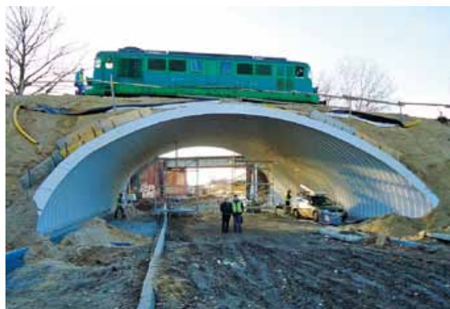
Fot.5. Próbné obciążenie konstrukcji
