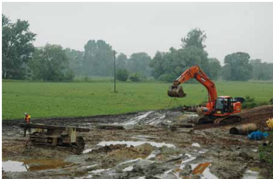
Fot. 1 Nielatwe warunki terenowe przed rozpoczęciem prac przy palowaniu – czerwiec 2013 r.
