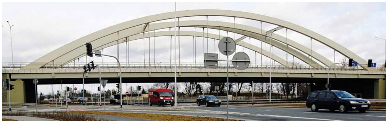
Rys. 10. Wiadukt drogowy WD3 nad ul. Żmigrodzką - widok od strony południowej (fot. M. Jagiełło)
