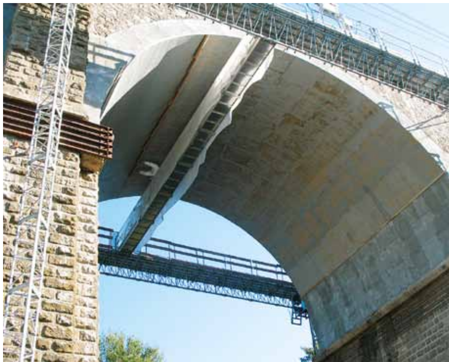
Fot. 1. Wzmocnienie łuków mostu kolejowego na linii Rzym – Formia – Neapol za pomocą technologii Ruredil X Mesh Gold.
