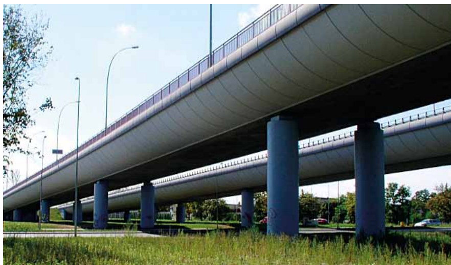
Rys. 3. Estakada Gądowska widok w kierunku południowym (fot. M. Jagiełło)
