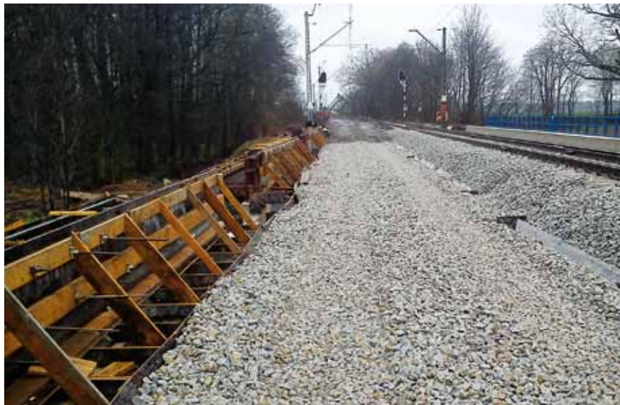
Zdj. nr 2. Obiekt nad teren zalewowy rzeki Bystrzycy – Suchodół w km 17+365, przebudowa w torze nr 2
