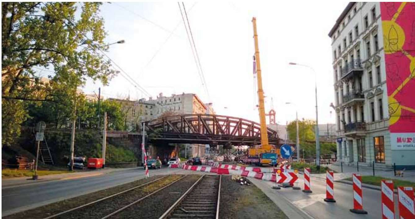
Ryc. 2. Zdjęcie z realizacji demontażu przęsła nr 1 z wykorzystaniem żurawia samobieżnego o udźwigu 200 Mg. Stan przed rozpoczęciem cięcia segmentów.
