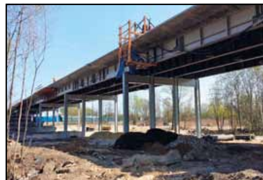
Przebudowa wiaduktu drogowego nad linią kolejową PKP w ciągu DK-88 w Gliwicach Inwestor: Zarząd Dróg Miejskich w Gliwicach
