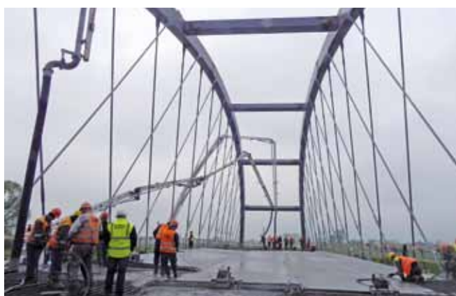
Fot. 12 Betonowanie ustroju nośnego w części łukowej – kwiecień 2014 r.
