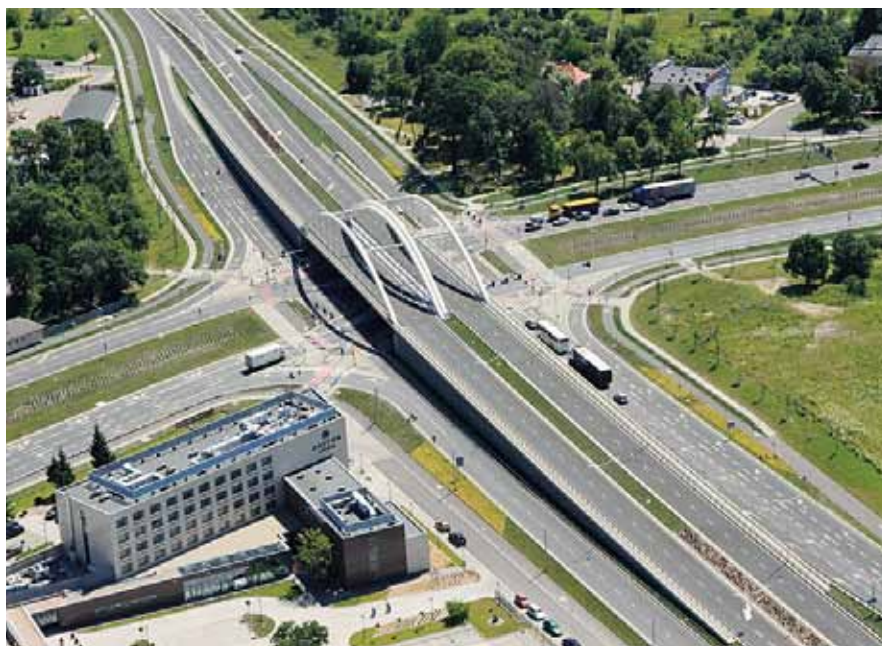
Rys. 9. Obwodnica Śródmiejska – widok węzła z ul. Żmigrodzką (fot. G. Kilian)
