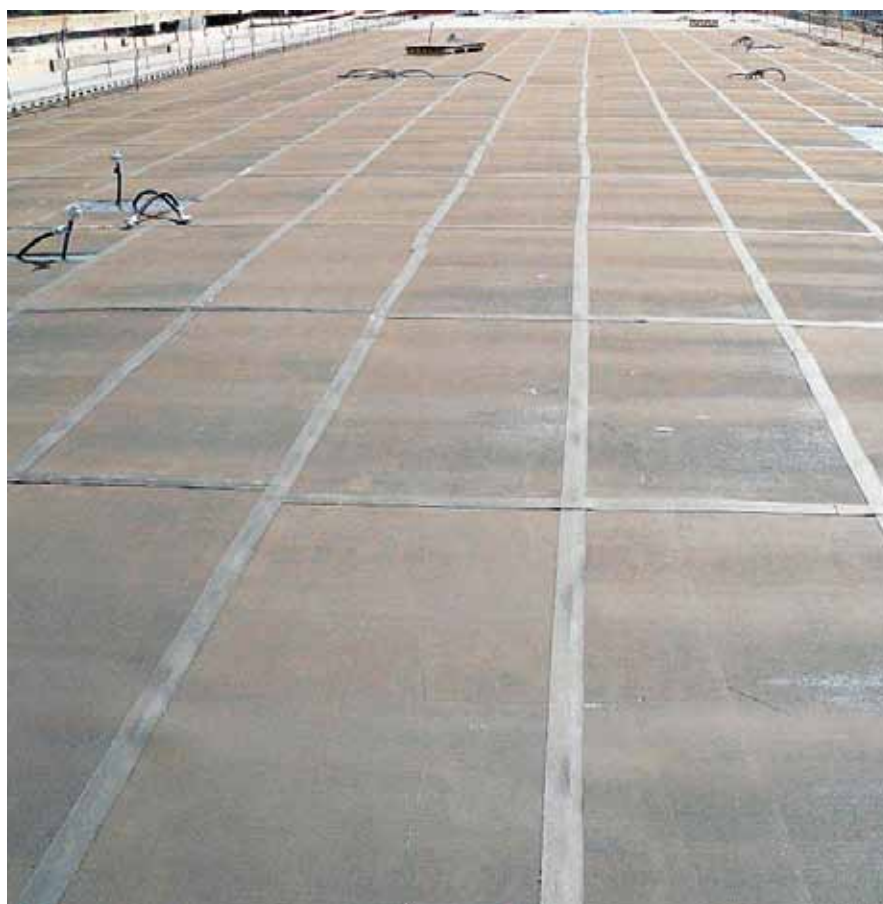
Fot. 2. Izolacja na wiadukcie Południowej Obwodnicy Gdańska
