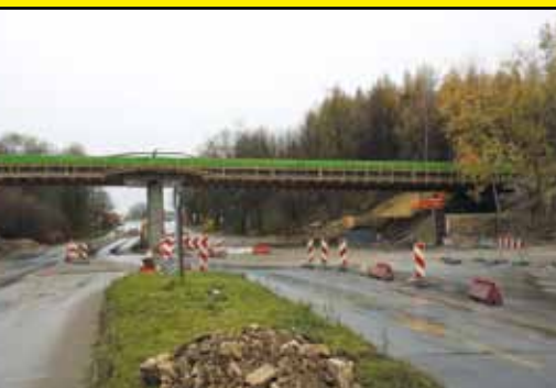
Przebudowa drogi krajowej nr 94 Inwestor: Gmina Dąbrowa Górnicza
