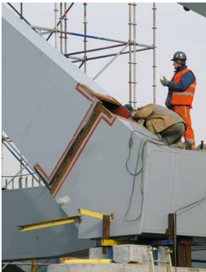
Fot. 8 Segment konstrukcji łuku po osadzeniu w węzłowie (w trakcie scalania) – styczeń 2014 r.
