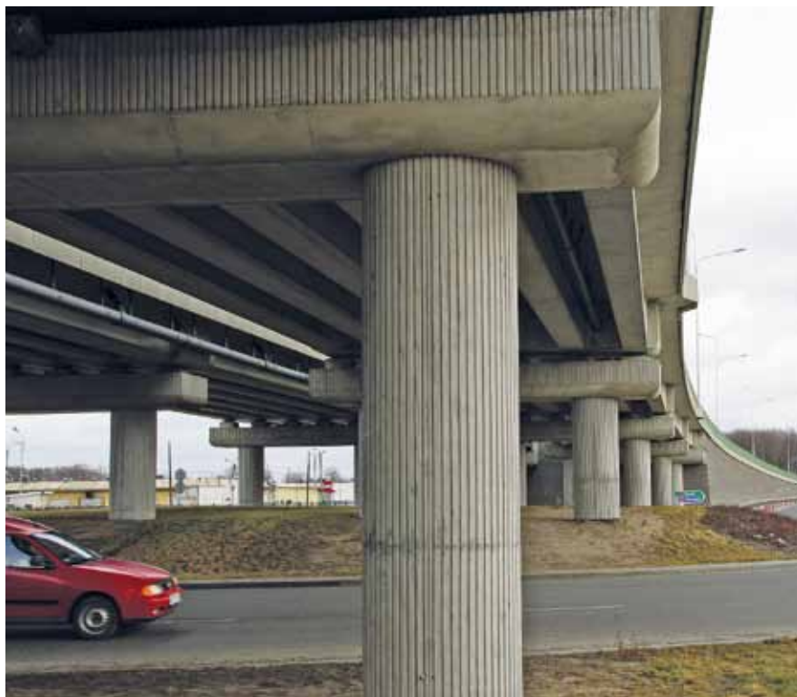
Rys.8. Wiadukt drogowy WD-2 - widok detalu architektonicznego (fot. M. Jagiełło)
