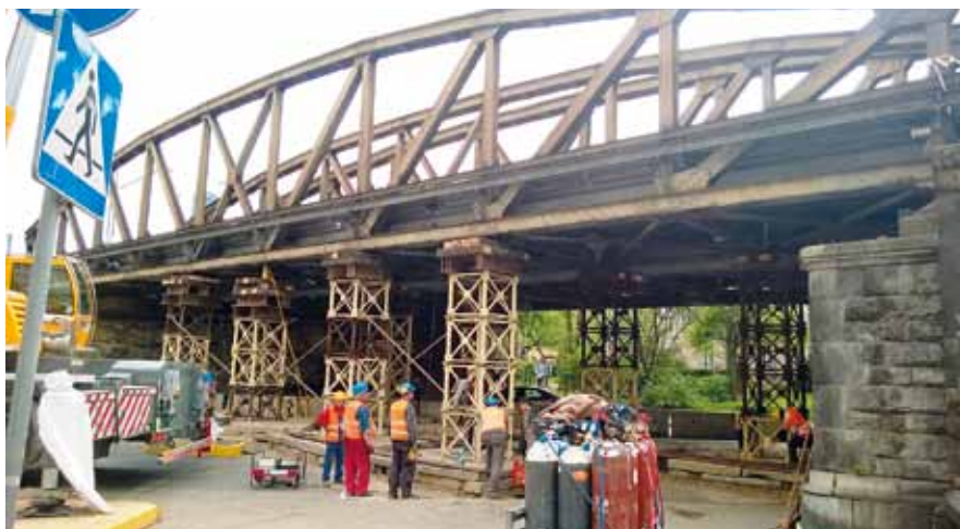
Ryc. 3. Zabudowa podpór technologicznych dla etapu nr 1. Widok od strony ul. Wysokiej.
