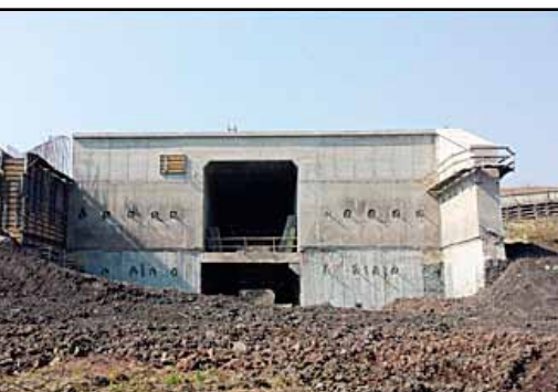
Budowa mostu kolejowego nad rzeką Bierawką Inwestor: Kompania Węglowa S.A. KWK Knurów Szczygłowie
