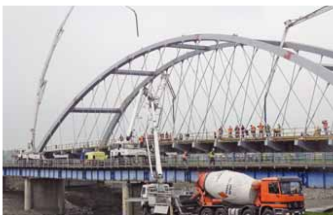
Fot. 11 Betonowanie ustroju nośnego – kwiecień 2014 r.
