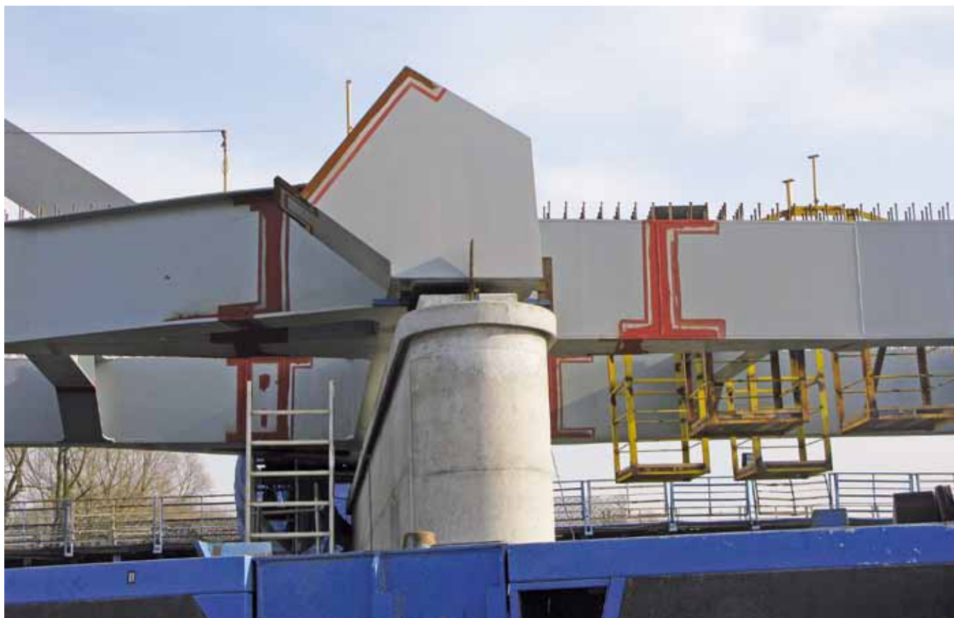
Fot. 5 Króciec w wezgielciu łuku, przed osadzeniem elementu montażowego konstrukcji łuku – styczeń 2014 r.
