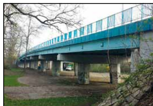
Modernizacja estakady w ciągu ul. Staszica w Siemianowicach Śląskich Inwestor: Gmina Siemianowice Śląskie
