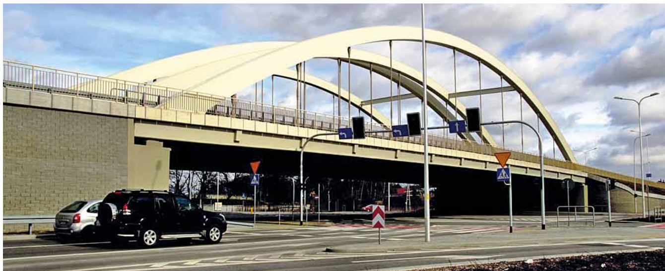
Rys. 12. Wiadukt łukowy WD-3 nad ul. Żmigrodzką. (fot. M. Jagiełło)
