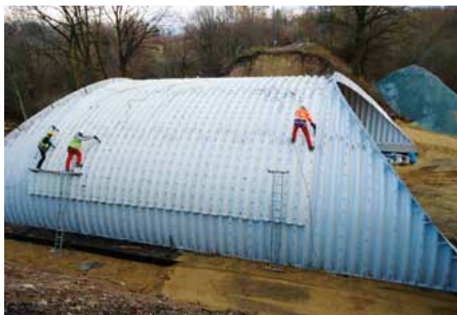
Fot. 2. Montaż konstrukcji (widoczne żebra wzmacniające)
