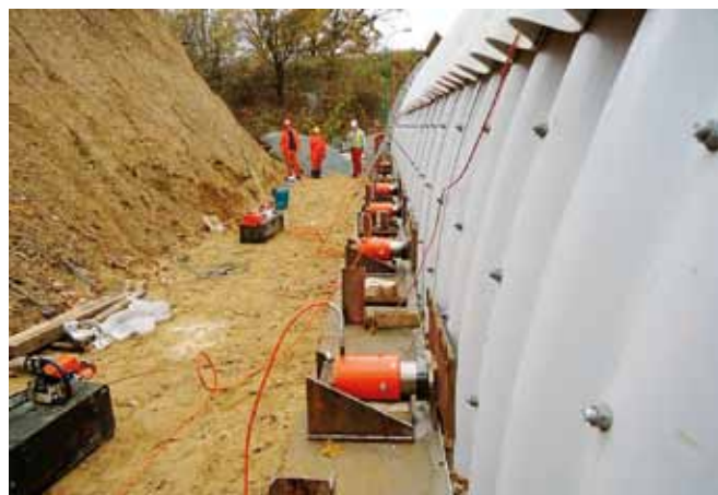
Fot.3. Sprężanie wstępne konstrukcji
