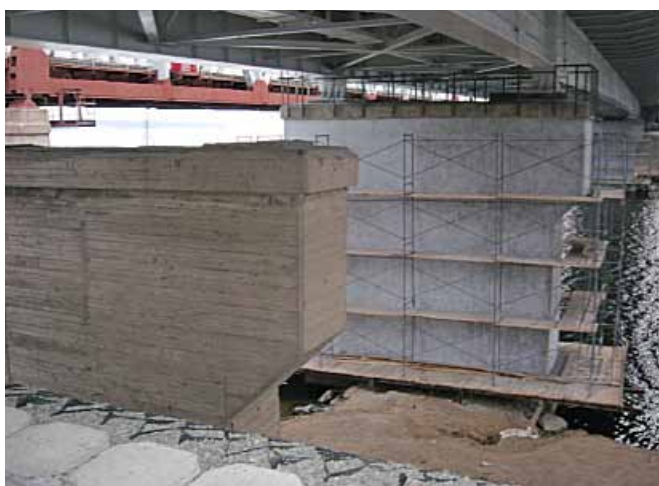
Fot. 2. Wzmocnienie filarów mostu w Nowosybirsku w Rosji.
