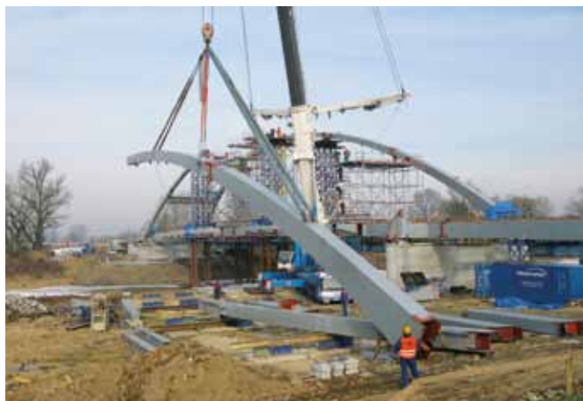
Fot. 6,7 Segment konstrukcji łuku w trakcie prac montażowych – styczeń 2014 r.
