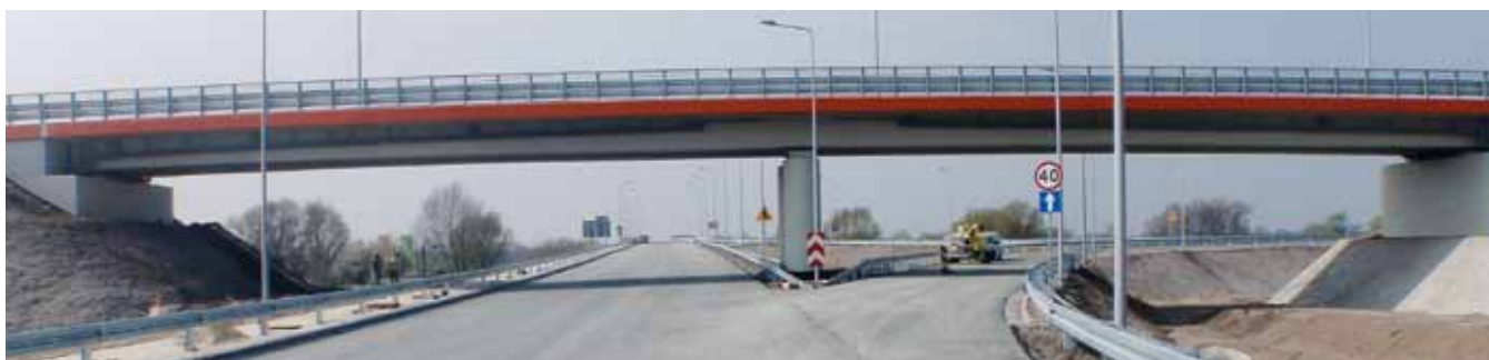
Rys. 7. Wiadukt drogowy po zrealizowaniu zasadniczych prac (marzec 2014r.)
