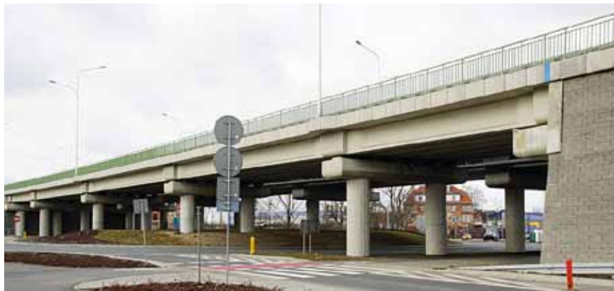
Rys.7. Wiadukt drogowy WD-2 nad rondem w ciągu ul. Obornickiej (fot. M. Jagiełło)
