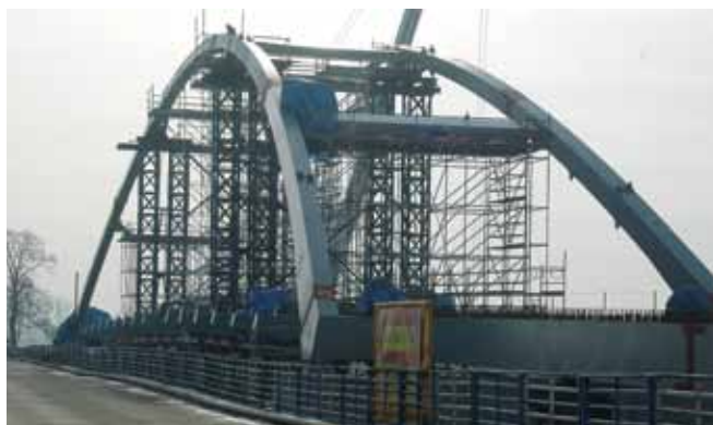
Fot. 9 Widok na konstrukcję przęsła łukowego z poziomu jezdni istniejącego mostu tymczasowego – styczeń 2014 r.
