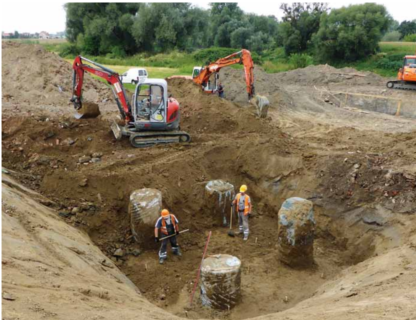
Fot. 2 Prace przy ociepie fundamentowym przyczółka od strony Ciska – sierpień 2013 r.
