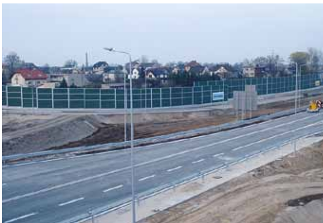
Rys. 9. Wykonane ekrany akustyczne na węźle w Opolu (kwiecień 2014r.)
