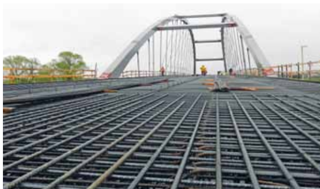
Fot. 10 Widok na konstrukcję przęsła łukowego z poziomu zbrojenia płyty pomostowej – kwiecień 2014 r.
