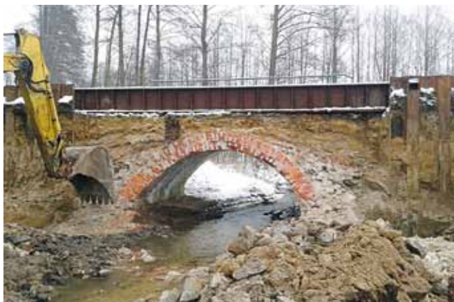
Ryc. 9. Zdjęcie z realizacji pokazujące istniejące sklepienie (w trakcie rozbioru) oraz wbudowaną konstrukcję odciażającą
