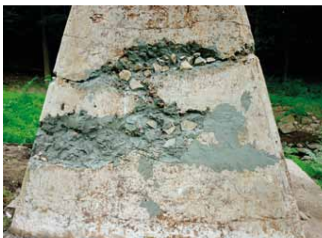
Fot. 3. Naprawa postumentów estakady na Północnej Linii Metra w Nowym Jorku.
