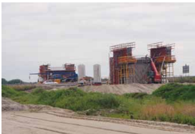
Rys. 5. Budowa podpór wiaduktu drogowego (lipiec 2013r.)
