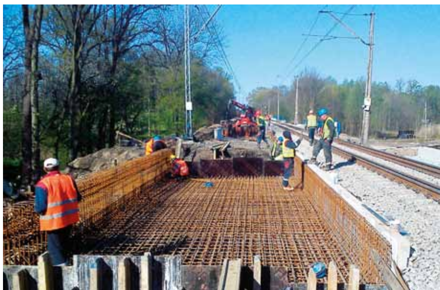
Zdj. nr 3. Obiekt nad cieką Młynówka w km 17+217, przebudowa w torze nr 2
