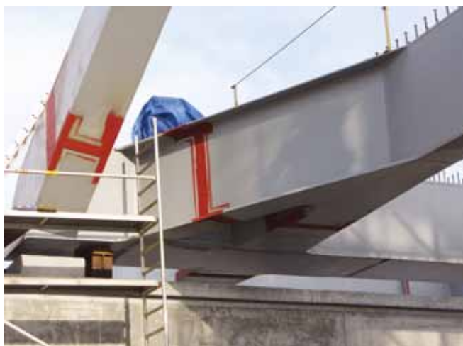
Fot. 4 Widok na wezłowie łuku oraz ściąg i zastrzał przęsła nurtowego – styczeń 2014 r.
