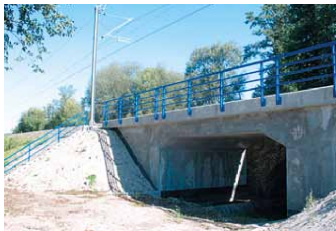
Ryc. 10. Zdjęcie z realizacji pokazujące nowo wykonany obiekt w torze nr2.
