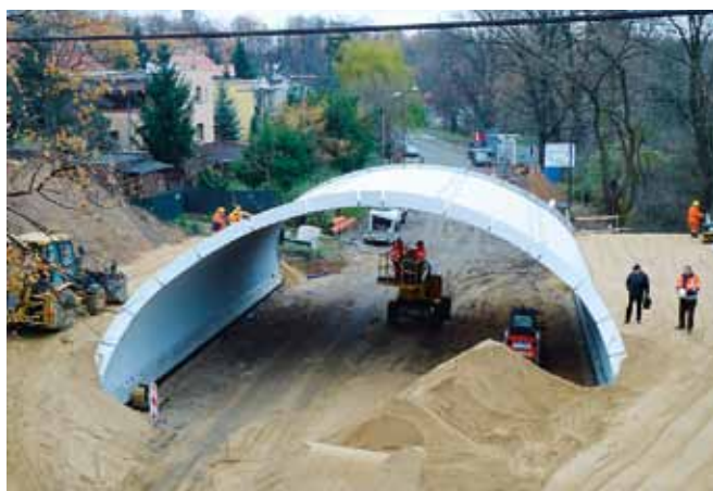
Fot.4. Wykonanie zasypki obiektu wraz z zagęszczeniem
