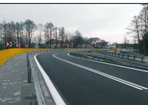
Budowa mostu objazdowego i budowa nowego mostu nad rzeką Kakonianką w ciągu DK-74 w Woli Jachowej Inwestor: GDDKiA w Kielcach
