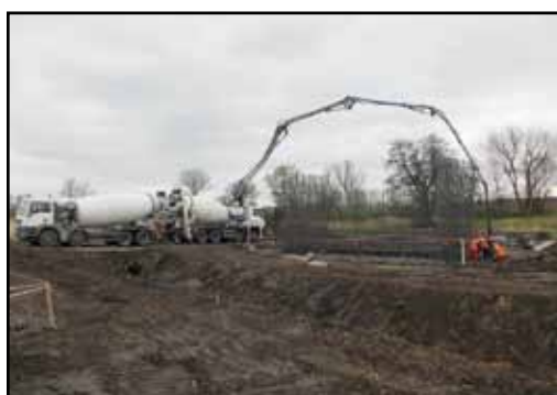
Budowa obwodnicy Głubczyc w ciągu drogi wojewódzkiej nr 416 Inwestor: Zarząd Dróg Wojewódzkich w Opolu
