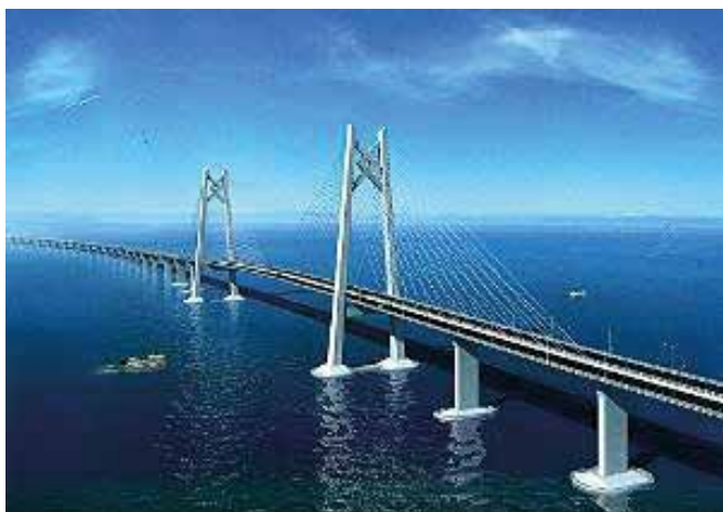
Hongkong-Zhuhai-Macao Bridge, China (najdłuższy stalowy most na świecie – 2,6 mln m 2 pomalowane)
