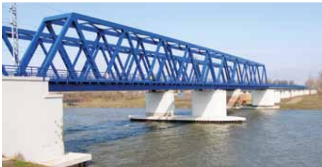
Most nad Odrą we Wrocławiu. Widok na przęsła nurtowe – tor nr1 (po przebudowie).
