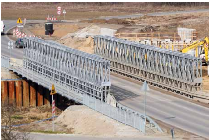
fot. 2. Most tymczasowy, jednoprzęsłowy, dwudźwigarowy – Acrow 700XS, przy moście Pęgowskim na Widawie
