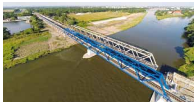
Fot. 15. Operacja wspornikowego nasuwu podłużnego przęsła wschodniego – faza końcowa.
