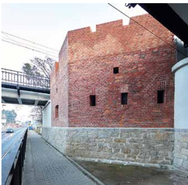
Fot. 11. Obiekt po przebudowie. Blokhauz II.
