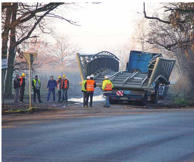
Fot. 9. Konstrukcja kładki na samochodzie przed montażem. Zdjęcie wykonane 19 grudnia 2015 roku.
