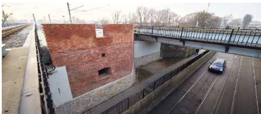
Fot. 10. Obiekt po przebudowie. Widok na strefę przyczółka nr1 / blokhauz II.
