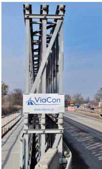
fot. 2. Most tymczasowy, trzyprzęsłowy, dwudźwigarowy – Acrow 700XS, na kanale Odra-Widawa
