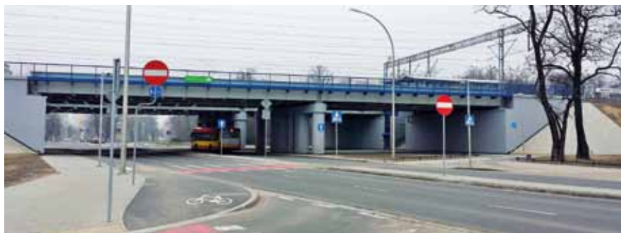
Wiadukt kolejowy w km 5+052 nad ul. Starogrobłą we Wrocławiu (fot. M. Michalak)
