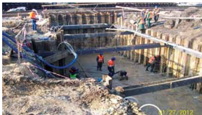
Fot. 17. Widok na komorę zamkniętą w obudowanie ze ścian szczelnych, zabezpieczonych rozporami
