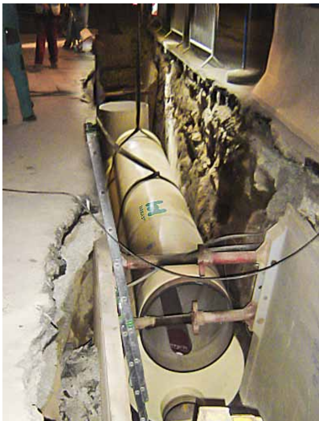
Montaż zbiornika – Děčín, Republika Czeska (DN1400/DN1000), czas instalacji 4 godziny.
