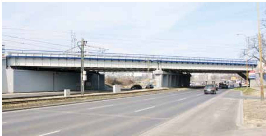
Fot. 8. Wiadukt kolejowy w km 4+141 nad ulicą Legnicką we Wrocławiu. Kompleksowy remont obiektu istniejącego.
