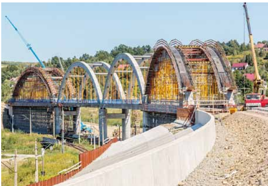
Rysunek 14. Widok rusztowania podporowego PERI Multiprop pod łukami żelbetonowymi obiektu
