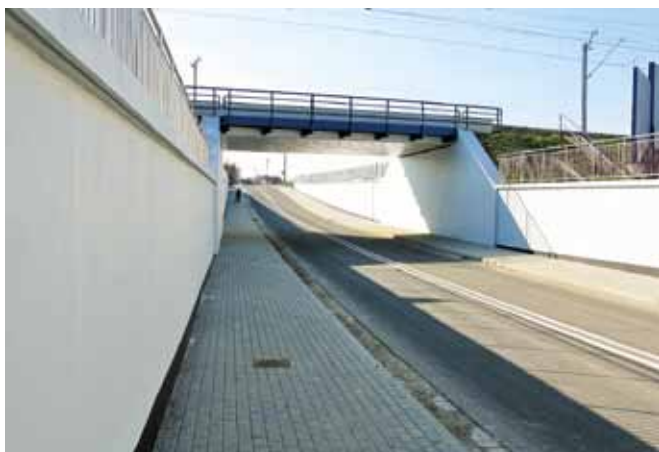
Fot. 12. Wiadukt kolejowy w km 31+815. Budowa nowego obiektu – skrzyżowanie bezkolizyjne z drogą powiatową 1357D Osolin – Morzęcin Mały Osolin.
