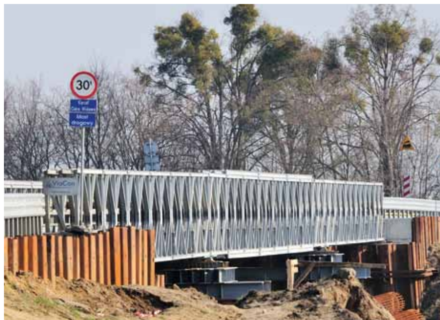
fot. 2. Most tymczasowy, trzyprzęsłowy, dwudźwigarowy – Acrow 700XS, na kanale Odra-Widawa
