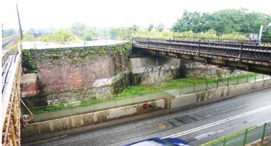
Fot. 4. Widok od strony północnej (blokhaus II) stan po przebudowie ulicy Osobowickiej
