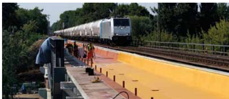
Układanie izolacji MMA.
