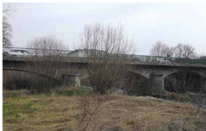
Fot. 6 – Widok mostu Św. Jana, ul. Mostowa w Jeleniej Górze z 2016 roku [oprac. własne]
