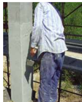
Fot. 2. Realizacja wzmocnienia mostu żelbetowego, łukowego z pomostem dolnym.
