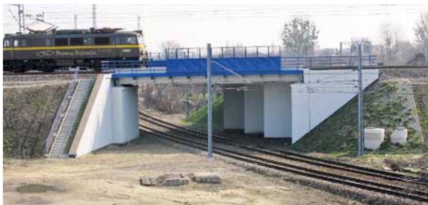
Fot. 9. Wiadukt kolejowy w km 4+629. Rozbiórka obiektu istniejącego i budowa nowego.
