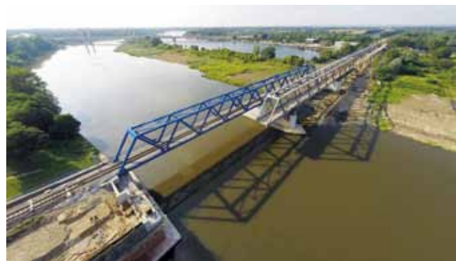
Fot. 13. Operacja wspornikowego nasuwu podłużnego przęsła wschodniego – przekroczenie filara nurtowego.
