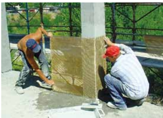
Fot. 2. Realizacja wzmocnienia mostu żelbetowego, łukowego z pomostem dolnym.
