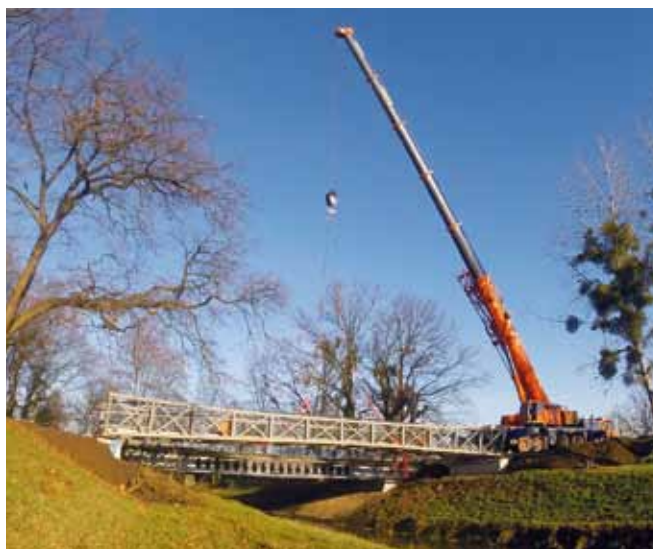
Fot. 10. Montaż konstrukcji stalowej kładki pieszo-rowerowej za pomocą dźwigu.
