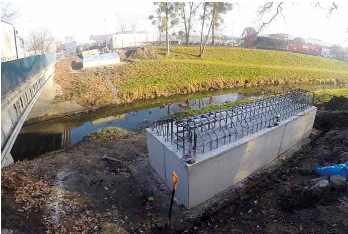
Fot. 8. Zabetonowane oczepy podporowe kładki Muchoborskiej. Widok od strony Muchoboru. Zdjęcie z grudnia 2015 roku
