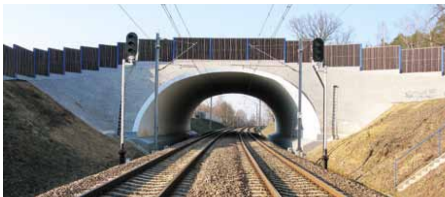
Fot. 10. Ekodukt w km 21+012. Budowa nowego obiektu ekologicznego.
