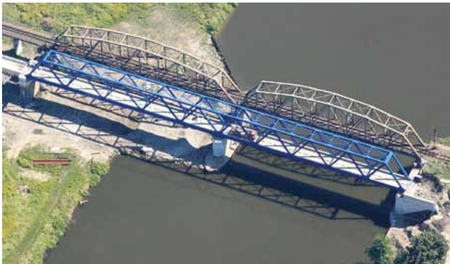
Fot. 10. Zdjęcie lotnicze mostu nad rz. Odrą w trakcie realizacji.
