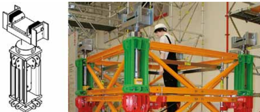
Rysunek 8. Głowica z siłownikami umożliwiającą podnoszenie i opuszczanie ciężarów na poziomie 280t/wieżę.
