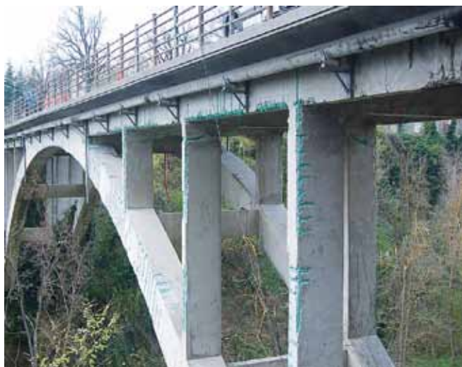
Fot. 1. Realizacja wzmocnienia mostu żelbetowego, łukowego z pomostem górnym.
