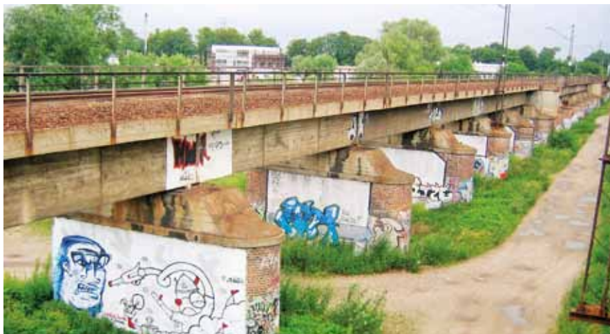
Most nad Odrą we Wrocławiu. Widok konstrukcji nad terenem zalewowym – tor nr2 (przed przebudową)
