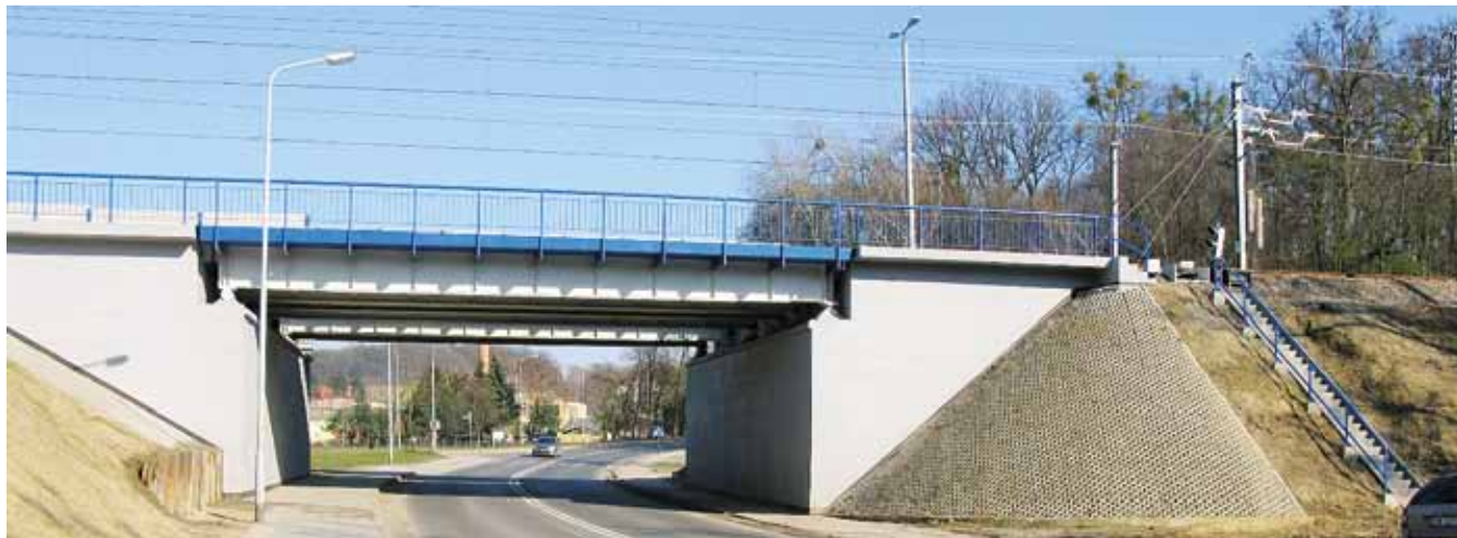
Fot. 7. Wiadukt kolejowy w km 26+323 nad ul. Piłsudskiego w Obornikach Śl. Remont i nadbudowa podpór. Modernizacja i wzmocnienie istniejących przęseł blachownicowych.
