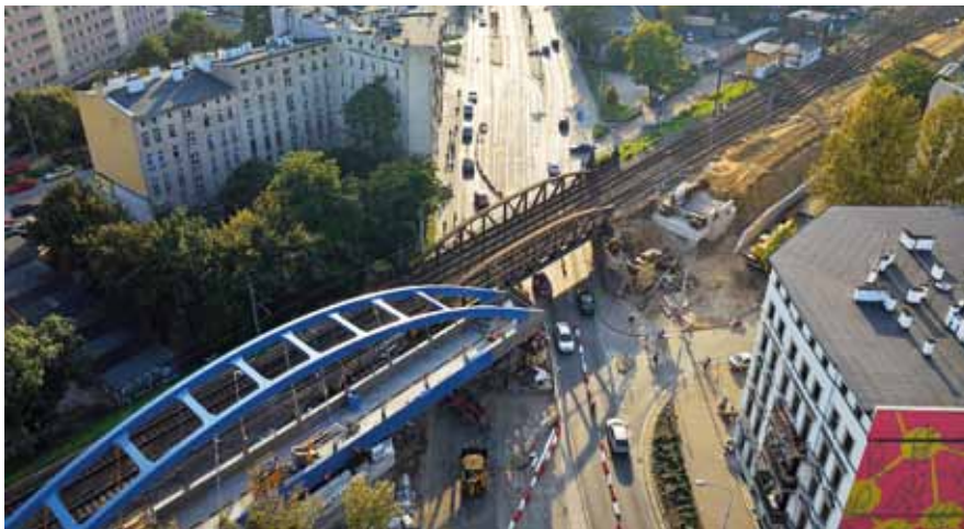
Fot. 4. Przęsło nr1 w trakcie procedury nasuwania nad jezdnią ul. Grabiszyńskiej. źródło: fotopolska.eu
