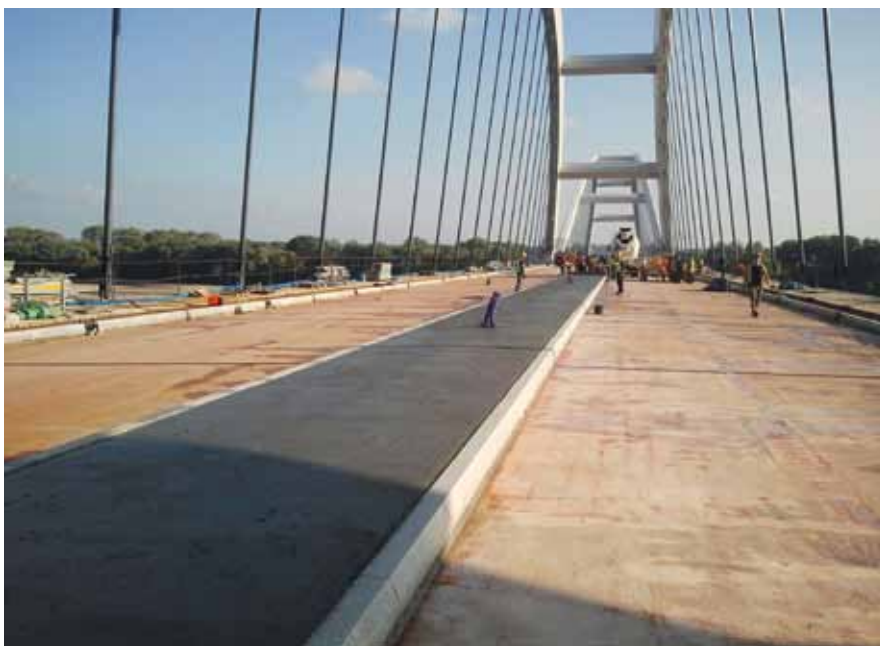
Fot. 3. Wykonana kapa chodnikowa z betonu lekkiego [fot.M.Konopska-Piechurska]
