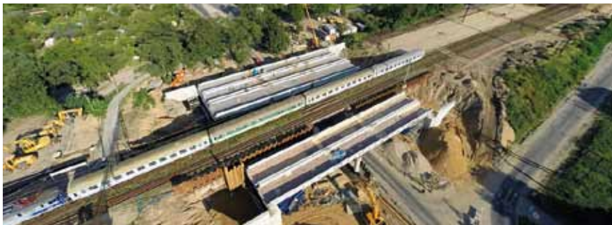
Fot. 7. Wiadukt nad ul. Starogrobłową. Stan przed montażem dwóch wewnętrznych przęseł
