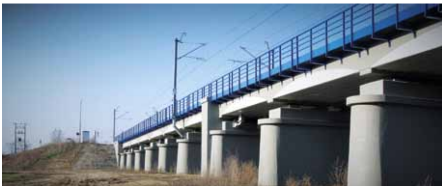
Fot. 5. Most kolejowy w km 14+671 nad rzeką Widawą. Przebudowa i naprawa podpór, wymiana przęseł na nowe, płytowe z dźwigarów obetonowanych.
