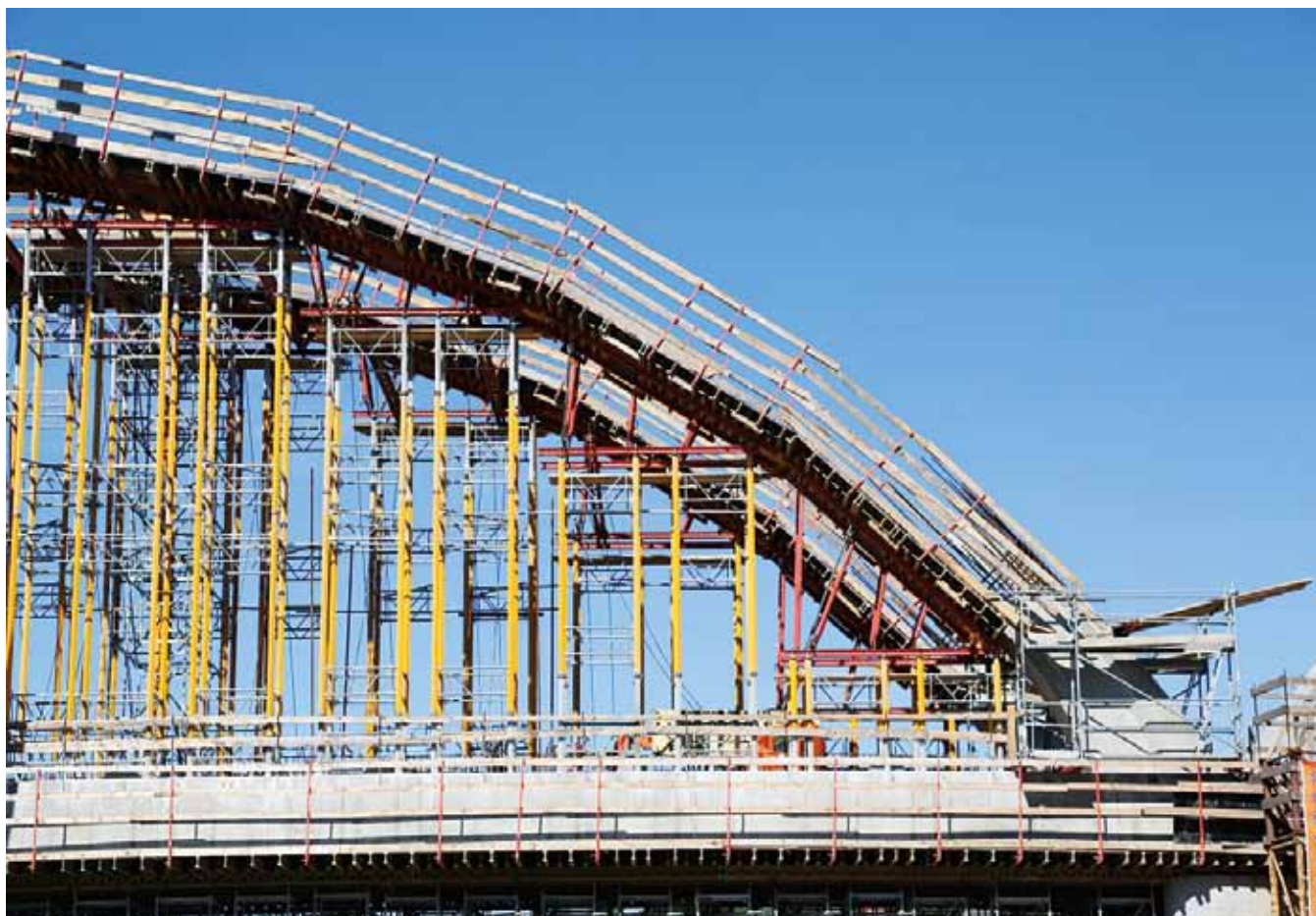
Rysunek 13. Widok deskowania i rusztowania PERI Multiprop dla łuku.
