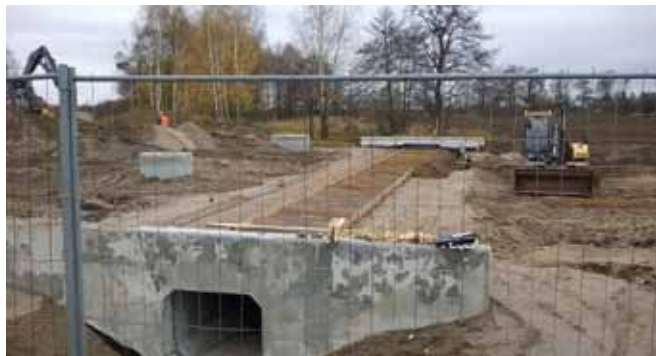
Rys. 12. Budowa dwóch przejść dla zwierząt
