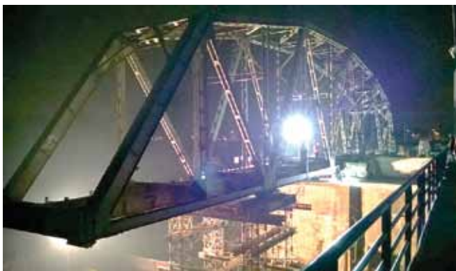
Fot. 12. Operacja zsuwania wschodniego przęsła. Widok na podporę pływającą
