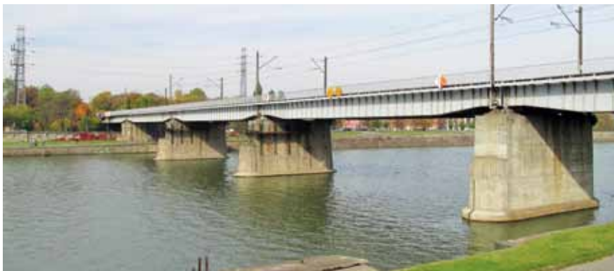
Most nad Wisłą w Krakowie. Widok na konstrukcję (stan istniejący).
