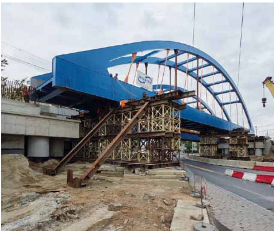
Fot. 6. Przęsło nr 2 w trakcie dosunięcia poprzecznego na pozycję docelową
