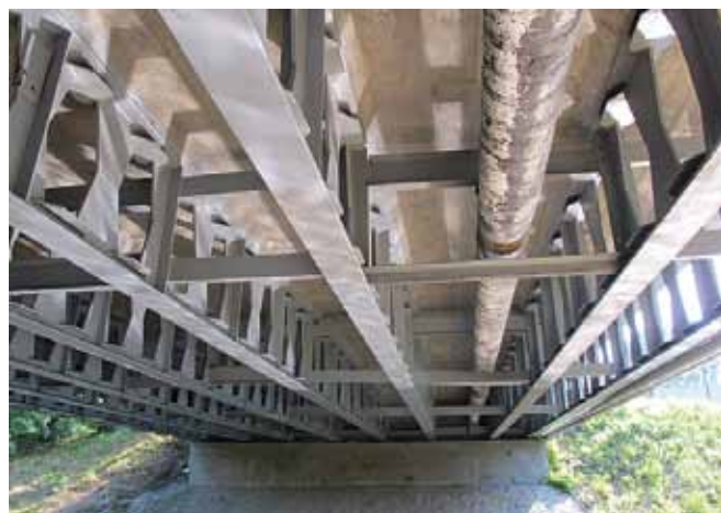
Fot. 2. Spód konstrukcji mostu Muchoborskiego widziany z lewego brzegu. Zdjęcie z lipca 2014 roku
