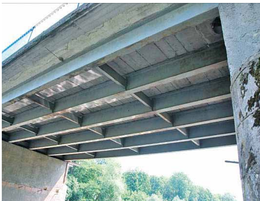
Rys. 3 Widok na przęsło od spodu
