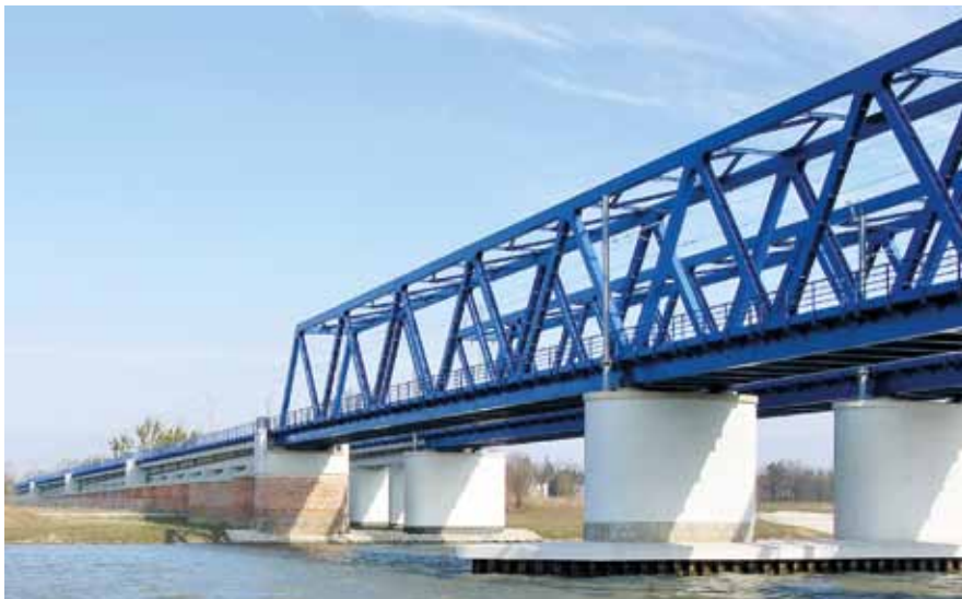
Fot. 3. Most kolejowy w km 5+845 nad rzeką Odra.
