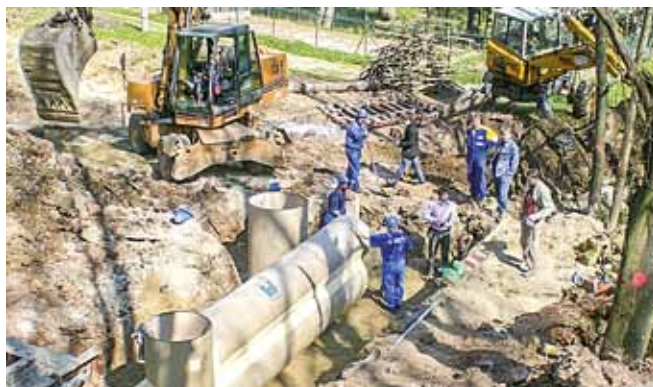
Montaż zbiornika – Moravský Krumlov, Republika Czeska (DN 1100/DN800), czas instalacji 2 godziny.
