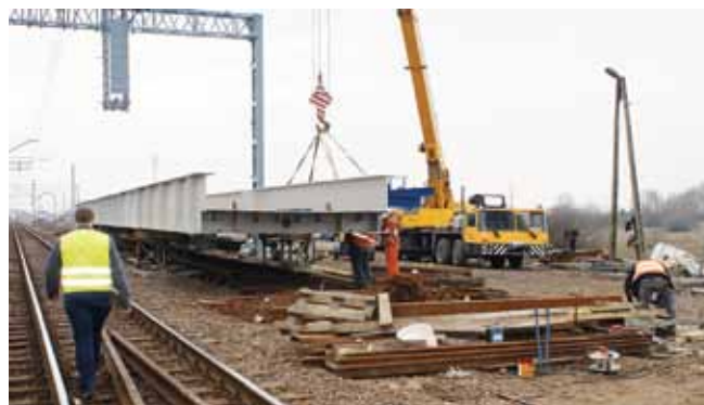
Fot. 19. Wstępne scalenie konstrukcji mostu nad rz. Sowińą przed transportem żurawiem na podwoziu samochodowym do docelowego miejsca wbudowania.
