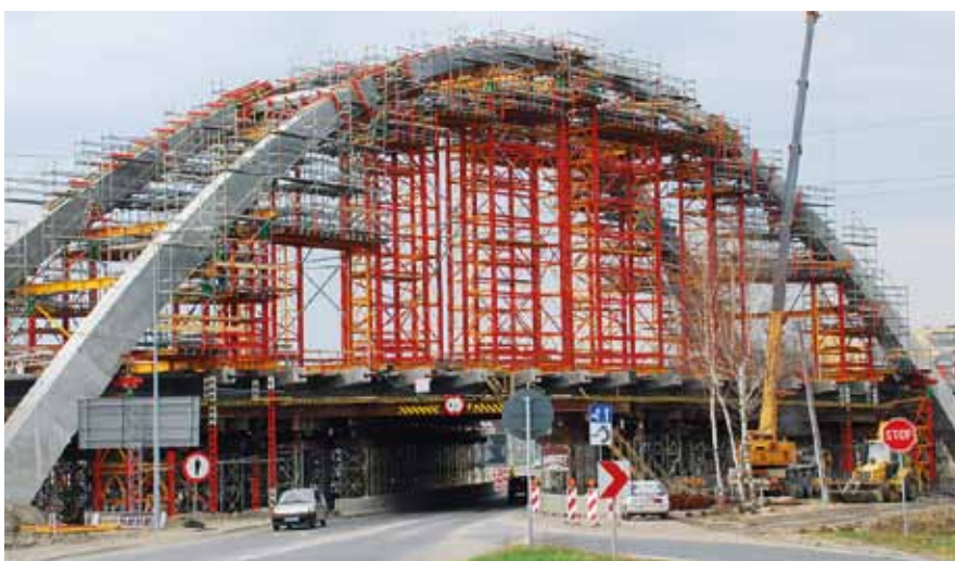
Rysunek 18. Rusztowanie podporowe łuku z wież PERI VST.
