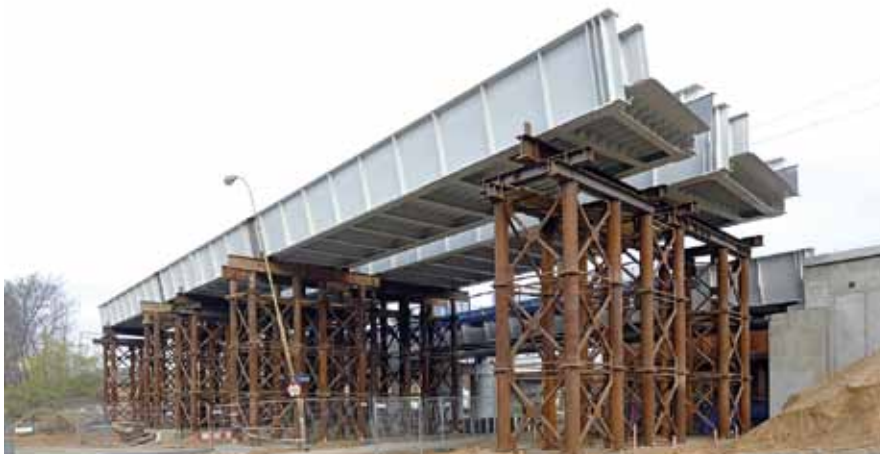
Fot. 8. Przęsła wiaduktu nad ul. Starogrobłową we Wrocławiu przed nasunięciem poprzecznym na miejsce docelowe. Źródło: fotopolska.eu
