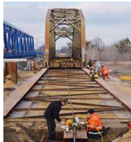
Fot. 11. Operacja zsuwania wschodniego przęsła mostu kolejowego nad rz. Odrą. Widok na tor ślizgowy
