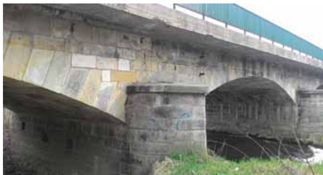
Fot. 7 – Widok mostu Św. Jana, ul. Mostowa w Jeleniej Górze z 2016 roku [oprac. własne]
