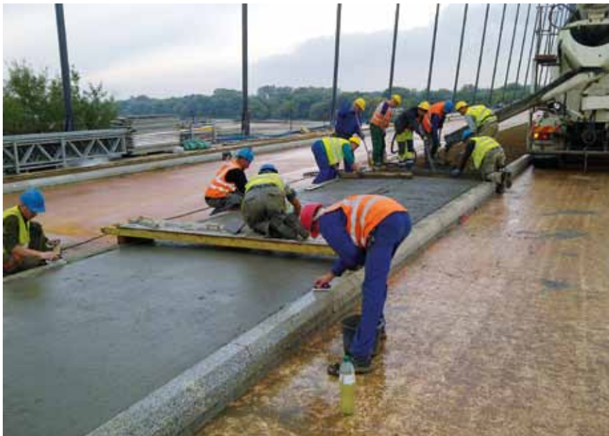
Fot.2. Formowanie kap chodnikowych jako ciąg zabiegów: rozładunek, zagęszczenie, wyrównanie i zacieranie powierzchni mieszanki betonu lekkiego [archiwum R. Walkowiak]
