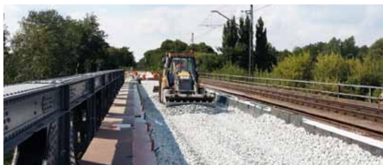
Rozkładanie podsypki tłuczniowej pod nawierzchnię kolejową.
