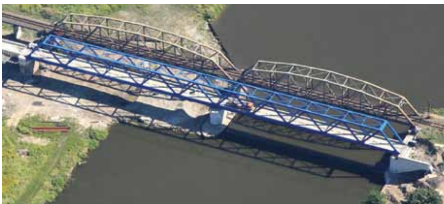
Most nad Odrą we Wrocławiu. Nowa konstrukcja w torze nr2 po nasuwie w położeniu docelowym / istniejąca konstrukcja w torze nr1 - przed przebudową (fot. G. Kilian)
