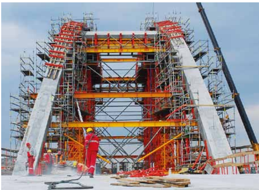
Rysunek 17. Bezpieczeństwo realizacji dzięki kompatybilności rusztowań PERI UP i wież PERI VST.
