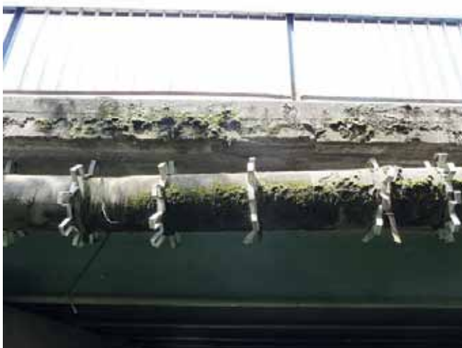
Rys. 4 Widok na przęsło od boku – widoczna korozja biologiczna betonu i sieci obcych (po lewej) oraz widoczne gołym okiem ugięcia dźwigarów stalowych (po prawej)
