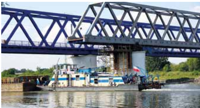
Fot. 14. Operacja wspornikowego nasuwu podłużnego przęsła wschodniego.
