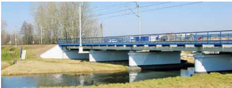
Fot. 6. Most kolejowy w km 54+810 nad rzeką Orlą. Remont podpór, wymiana przęseł na nowe, stalowe, ciągłe, blachownicowe.
