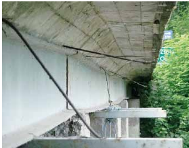
Rys. 4 Widok na przęsło od boku – widoczna korozja biologiczna betonu i sieci obcych (po lewej) oraz widoczne gołym okiem ugięcia dźwigarów stalowych (po prawej)
