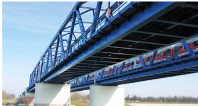
Most nad Odrą we Wrocławiu. Widok na przęsła nurtowe (po przebudowie).
