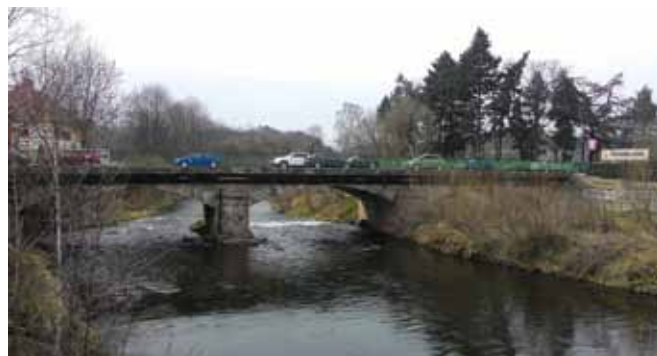
Fot. 8 – Widok mostu Św. Jana, ul. Mostowa w Jeleniej Górze z 2016 roku [oprac. własne]
