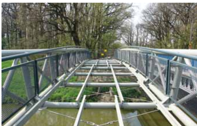
Fot. 11. Konstrukcja kładki bez pomostu osadzona na miejscu docelowym. Widok w kierunku Muchoboru
