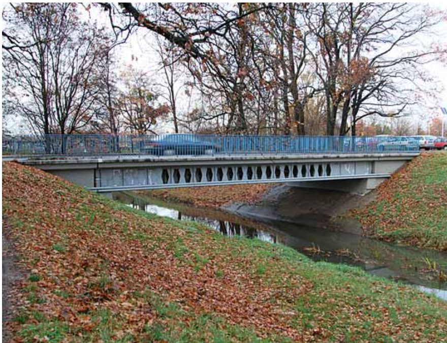
Fot. 3. Most Muchoborski widziany od strony wału lewobrzeżnego / górnej wody. Widoczne jest wypełnienie pięciu pól dźwigarów ażurowych przy każdej podporze. Zdjęcie z grudnia 2015 roku
