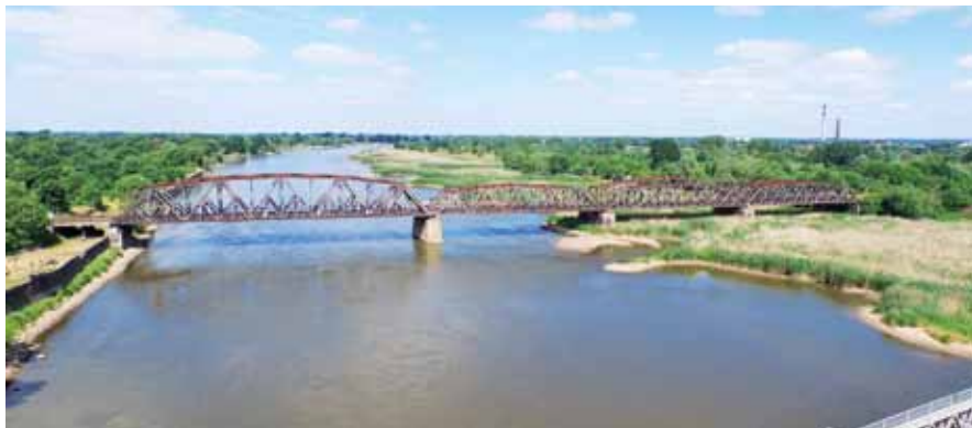
Most nad Odrą w Kostrzynie. Widok na konstrukcję (stan istniejący).
