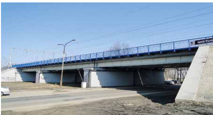
Fot. 4. Wiadukt kolejowy w km 3+528 nad ul. Robotniczą we Wrocławiu. Przebudowa i naprawa podpór, wymiana przęseł na nowe.
