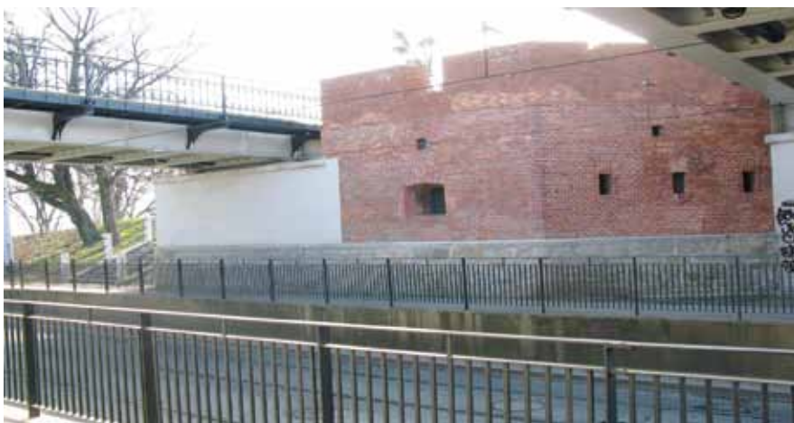
Fot. 8. Widok na przyczółek nr1 (oraz na będącą jego częścią elewację blokhauzu II) wraz z nadbudowaną balustradą ceglana z powtórzonym układem rozglifionym strzelnic.
