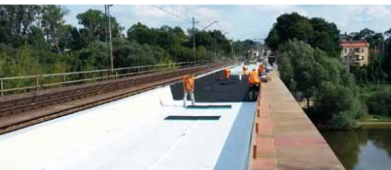
Montaż mat filtracyjnych i wibroizolacyjnych.
