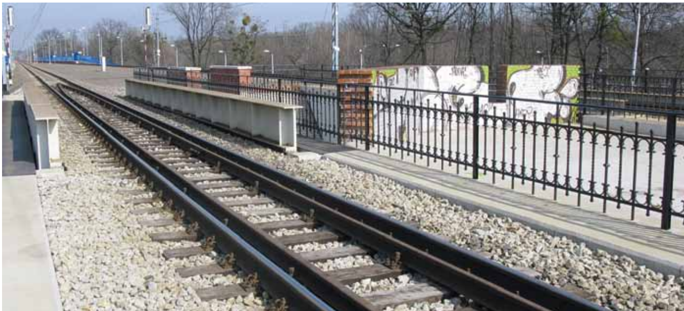
Fot. 6. Widok na balustradę zamontowaną na wannie żelbetowej, wykonanej pod torem nr2
