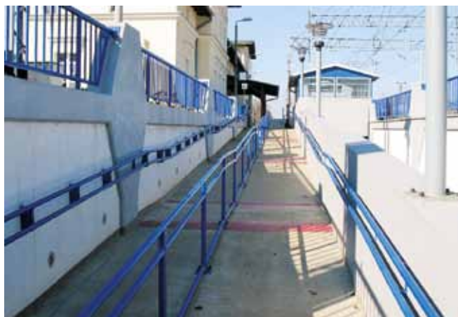
Fot. 13. Przejście pod torami dla pieszych km 36+810. Nowoprojektowane przejście pod torami na stacji Skokowa z pochylnią dla osób o ograniczonej możliwości poruszania się.
