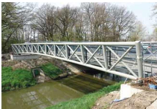
Fot. 12. Konstrukcja kładki widziana jest od strony górnej wody
