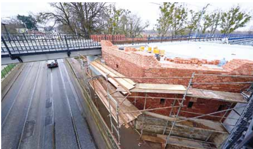
Fot. 7. Widok na przyczółek nr1 / blokhauz II w trakcie realizacji robót.
