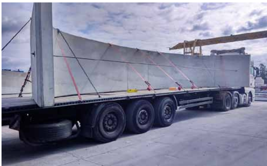
Fot. 1. Transport prefabrykatów
