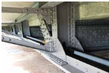
Wzmocnienie dolnych pasów dźwigarów kratowych przez ich sprężenie
