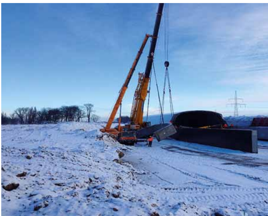
Fot.2 Montaż prefabrykatów
