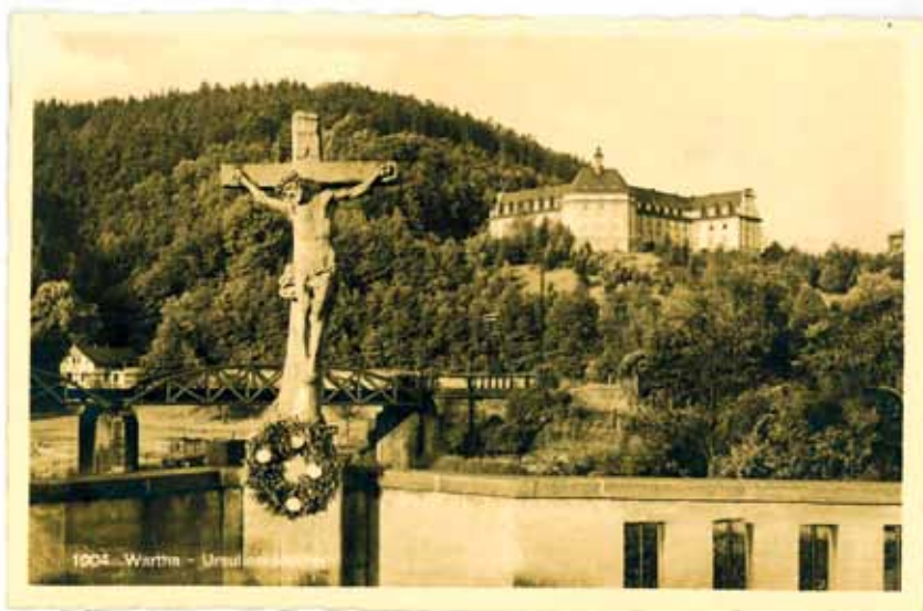
Rys. 10. Figur ukrzyżowanego Chrystusa na barierze mostu po przebudowie w 1908 roku.
