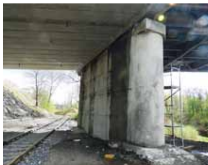
Wzmocnienie stateczności przyczółka za pomocą mikropali kotwiących i podpory pośredniej przez wykonanie tarczy pomiędzy pierwotnymi słupami
