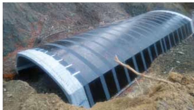
Fot. 6. Połączeniu prefabrykatu skrajnego z przedskrajnym oraz kotwy do połączenia ze ścianą czołową.
