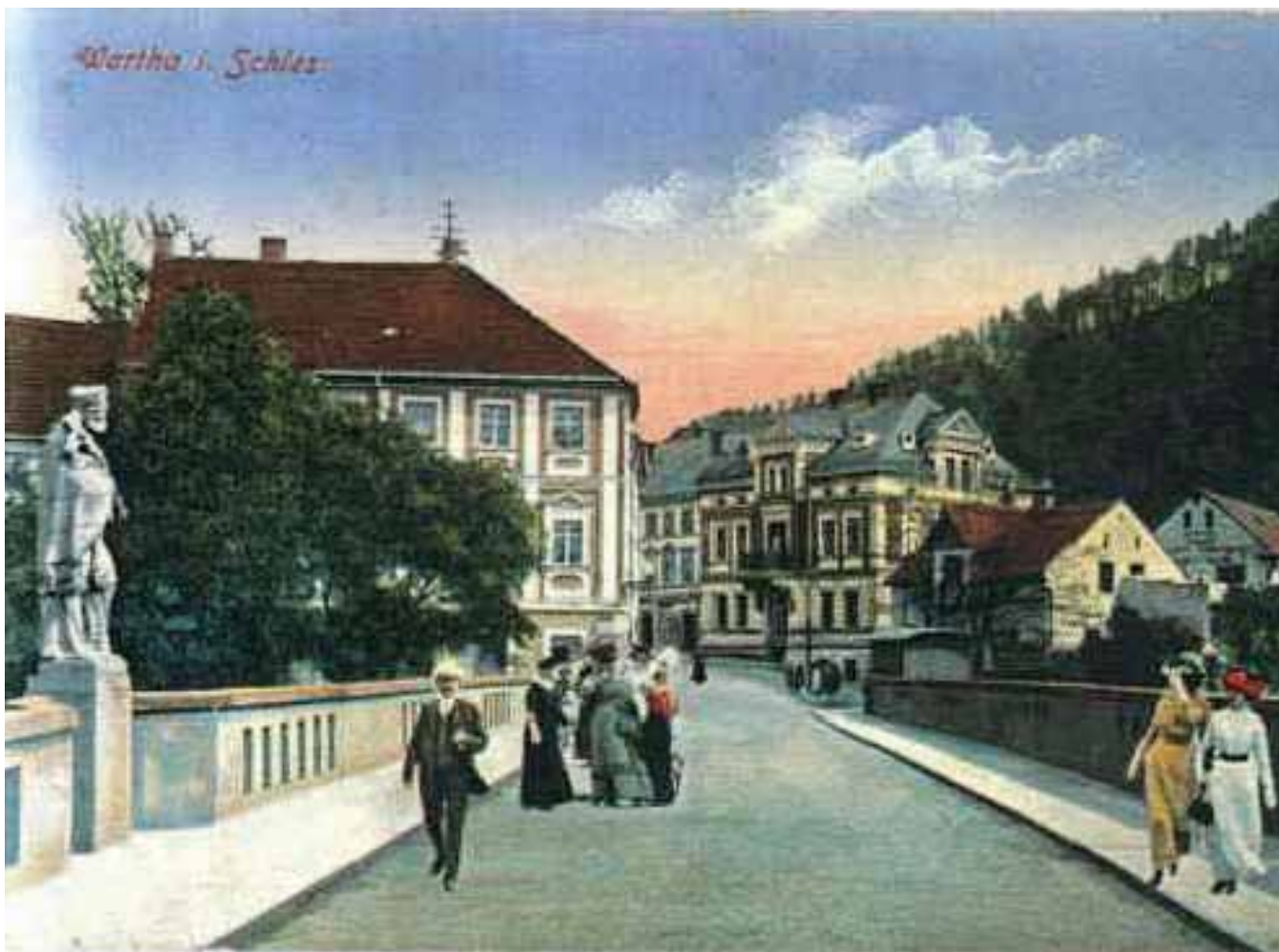
Rys. 9. Widok figur ukrzyżowanego Chrystusa i św. Jana Nepomucena na moście po przebudowie w 1908 roku.
