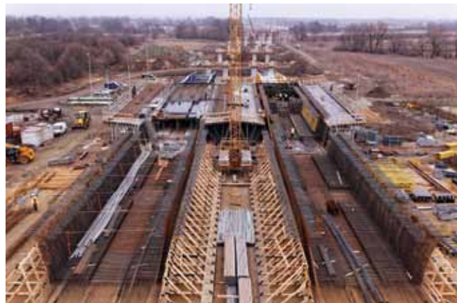
Fot. 5 - Obiekt MS41 - Wytwórnia wraz ze stanowiskami wstępnego montażu zbrojenia
