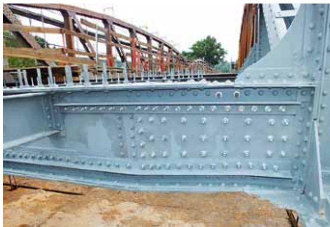
Wzmocnienie skrajnego fragmentu poprzecznic pośrednich
