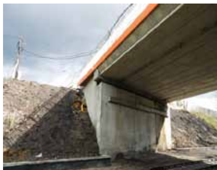
Wzmocnienie stateczności przyczółka za pomocą mikropali kotwiących i podpory pośredniej przez wykonanie tarczy pomiędzy pierwotnymi słupami
