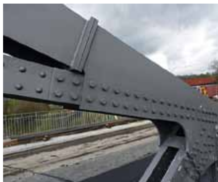
Skrajny węzeł dźwigara kratowego po wzmocnieniu
