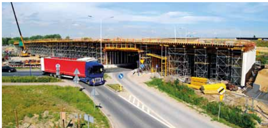
Fot. 2 - Obiekt WD43 - Rusztowania ustroju nośnego
