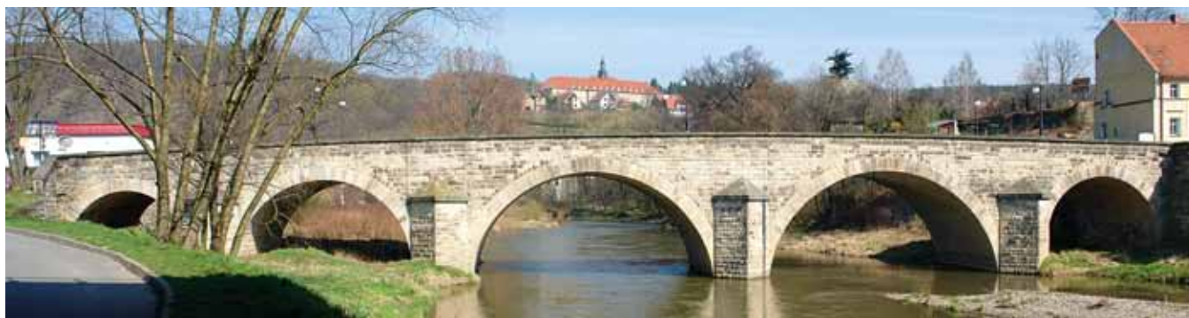
Rys. 11. Widok mostu od strony dolnej wody. Stan po odbudowie w 1950 roku.
