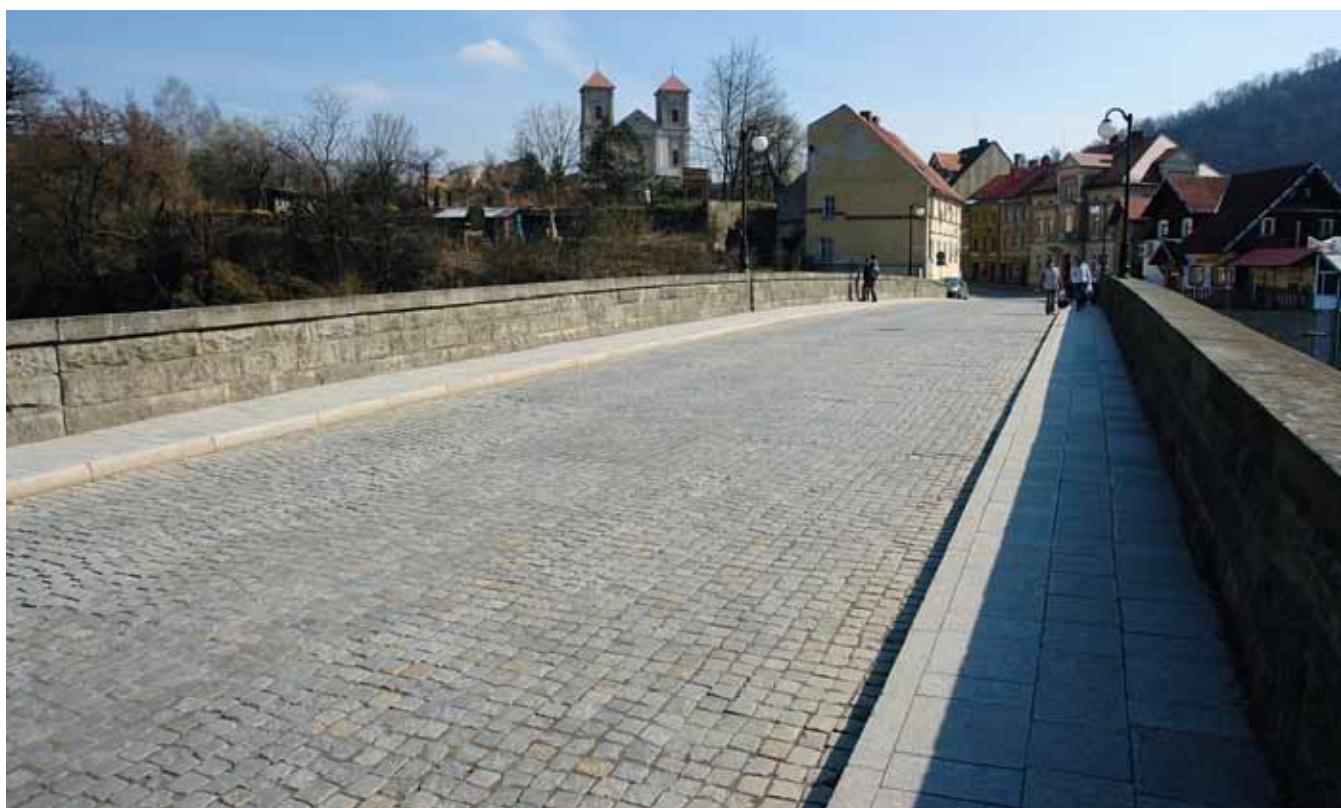
Rys. 12. Nawierzchnia z kostki granitowej i bariery bez figur ukrzyżowanego Chrystusa i św. Jana Nepomucena Stan po odbudowie w 1950 roku.
