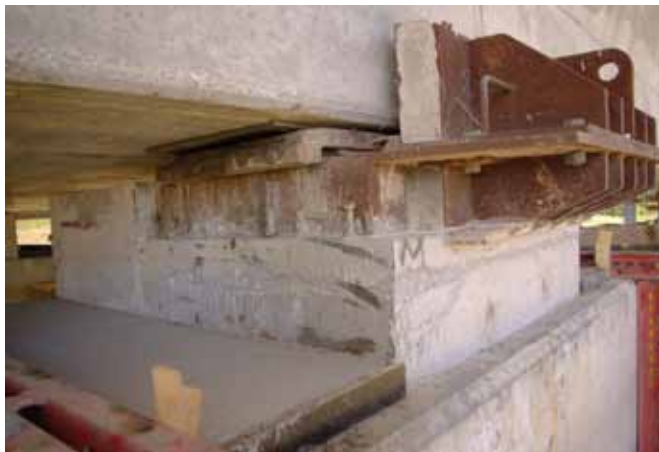
Fot. 8 - Widok na łożyska tymczasowe
