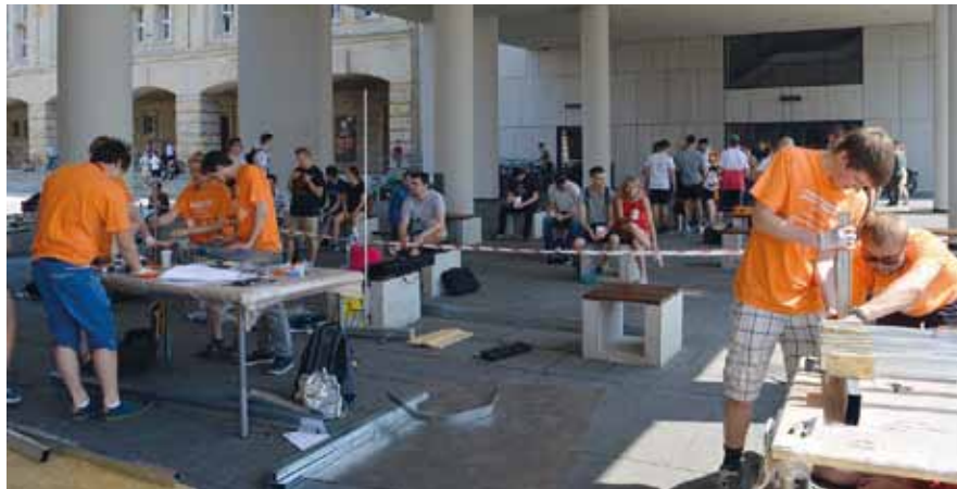
Fot. 3. Plac budowy – stanowiska montażowe
