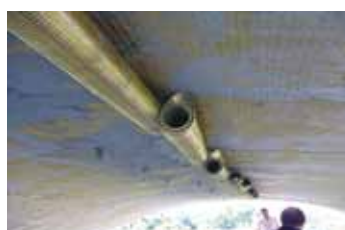
Fot. 3. Realizacja wzmocnienia wieloprzęsłowego, murowanego, mostu kolejowego o przęsłach łukowych.
