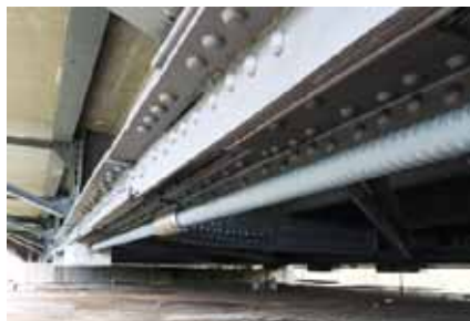
Wzmocnienie dolnych pasów dźwigarów kratowych przez ich sprężenie
