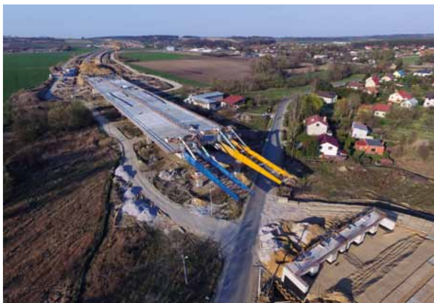
Fot. 10 - Obiekt MS36 - Nasuwanie ostatnich segmentów ustroju nośnego
