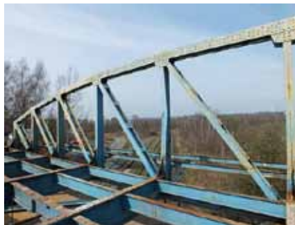
Dźwigar główny kratowy przed i po wzmocnieniu
