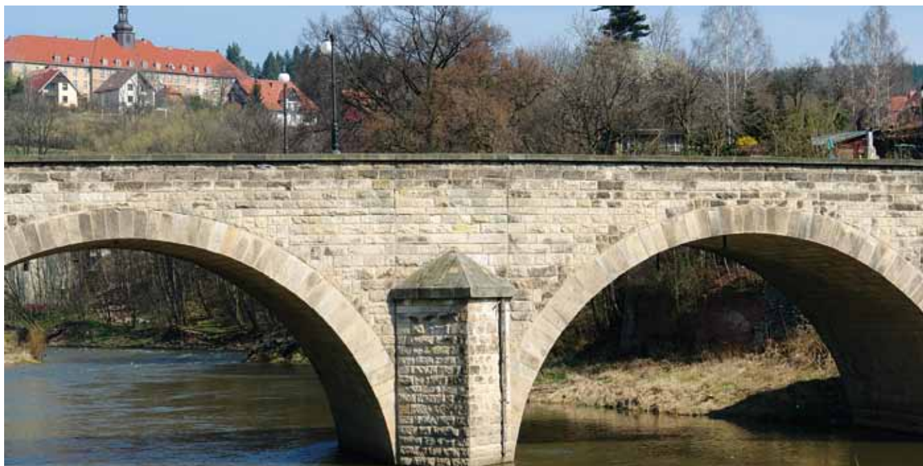
Rys. 11. Filar i przęsła środkowe mostu od strony dolnej wody. Stan po odbudowie w 1950 roku.
