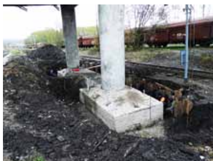
Wzmocnienie podpór pośrednich i ich posadowienia
