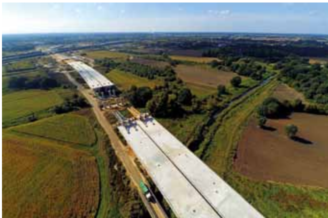
Fot. 4 - Obiekt MS41 - Nasuwanie prostoliniowego odcinka ustroju, po wcześniejszym wykonaniu odcinak w łuku
