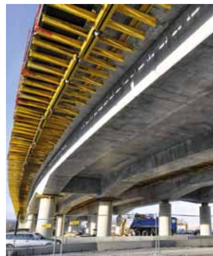
Fot. 3 - Obiekt WD43 - Zmienna wysokość konstrukcji
