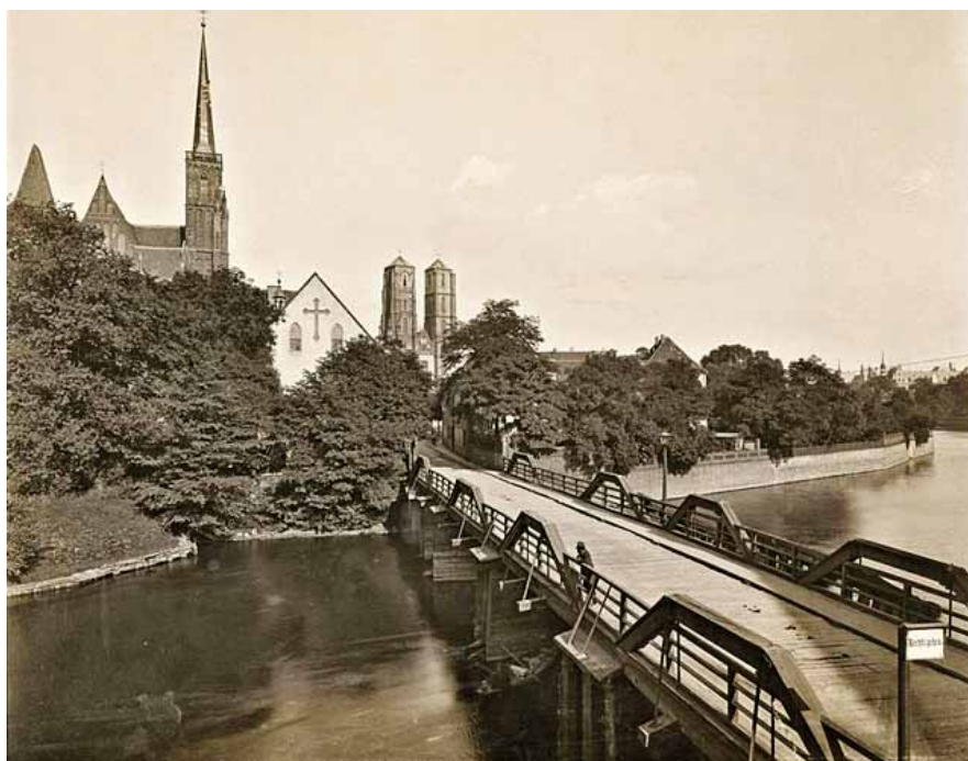
Rys. 2 Konstrukcja trapezowo wieszarowa funkcjonująca w miejscu dzisiejszego mostu Tumskiego przed 1888 rokiem
