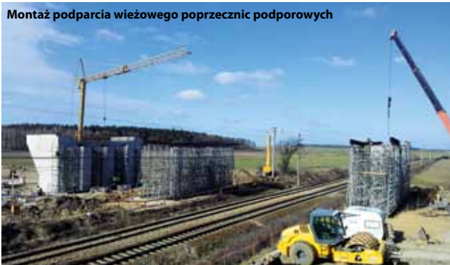
Podparcie wysokoności belek prefabrykowanych typu T na podporze B
