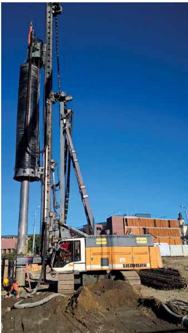
Fot. 5 Wykonywanie pali VDW Ø610 mm
