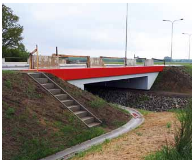
Rys.7. Obiekty MD-1 i MD-2 w trakcie budowy.
