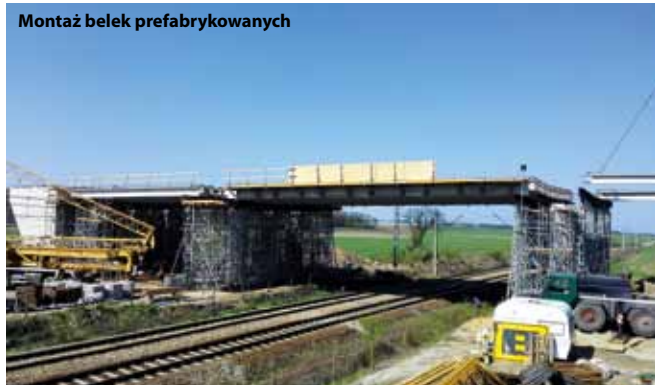
Montaż belek prefabrykowanych
