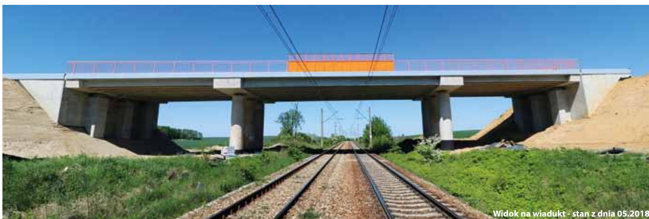
Widok na wiadukt - stan z dnia 05.2018
