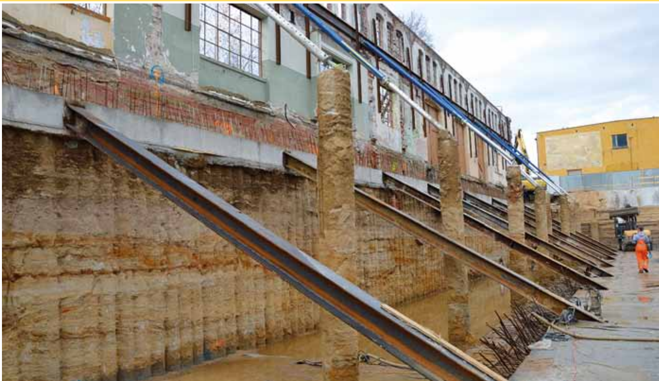
Fot. 4 Palisada zabezpieczająca wykop przy hali nr 19
