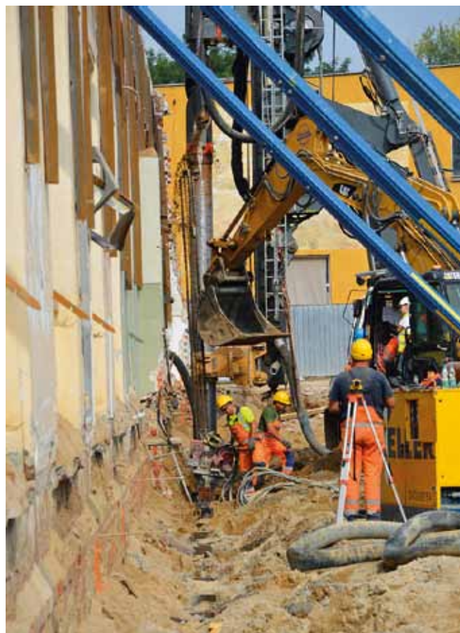
Fot. 2 Wykonywanie pali przy istniejącej ścianie hali nr 19
