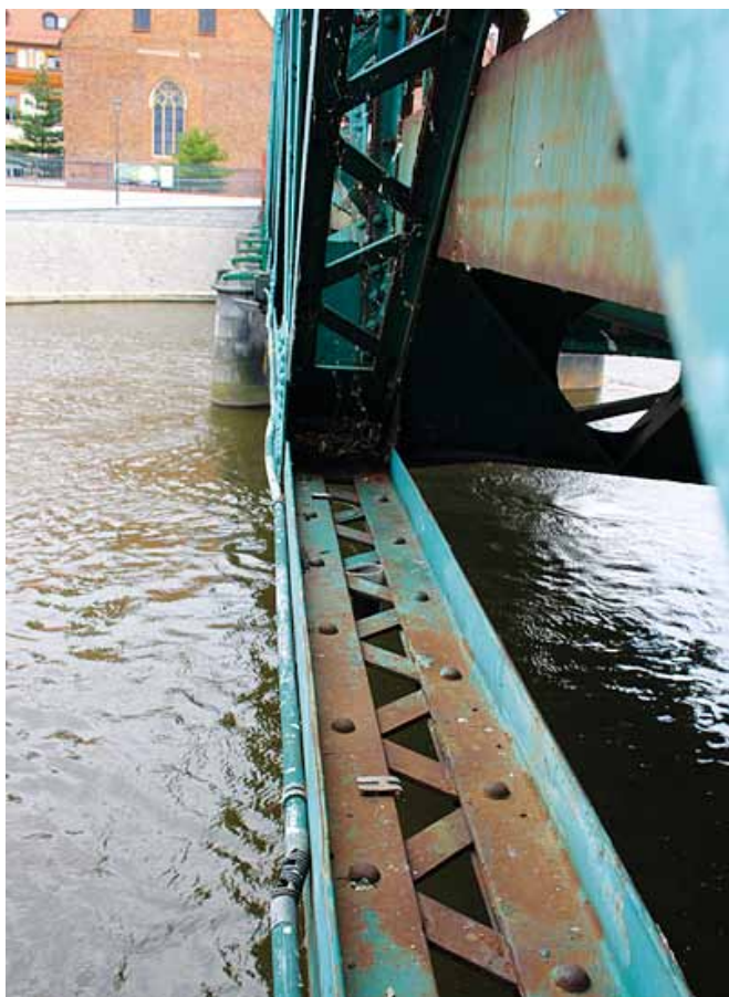
Rys. 5. Korozja powierzchniowa dotyczy przede wszystkim spodu konstrukcji
