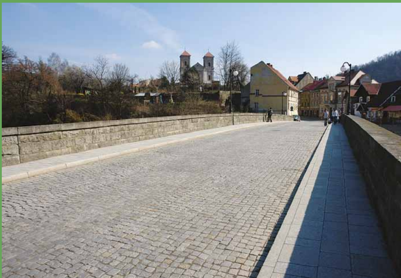
Rys. 13. Nawierzchnia z kostki granitowej i bariery bez figur ukrzyżowanego Chrystusa i św. Jana Nepomucena Stan po odbudowie w 1950 roku.
