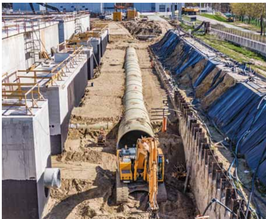
27.04.2019 r. – Zdjęcie zbiorników retencyjnych OŚ Czajka oraz rurociągu doprowadzającego z rur Flowtite DN2800, PN 6, SN10 000.
