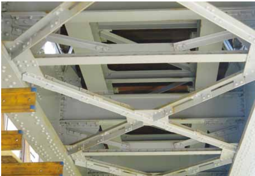
Rys 10. Widok na wyremontowane przęsła w torze nr 2.
