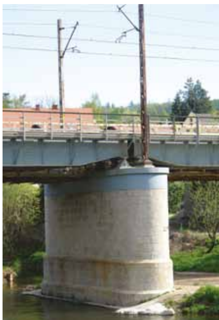
Rys. 6. Widok na wyremontowany filar od strony Wrocławia.
