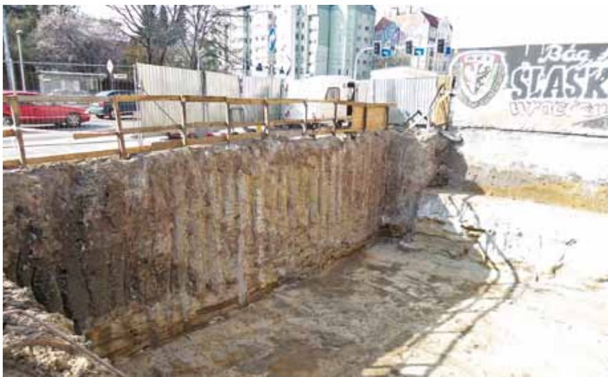
Fot. 5 Palisada z kolumn DSM stanowiąca zabezpieczenie głębokiego wykopu i jednostronny szalunek
