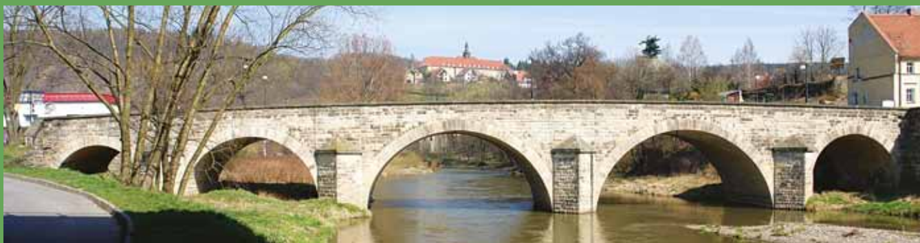
Rys. 11. Widok mostu od strony dolnej wody. Stan po odbudowie w 1950 roku.
