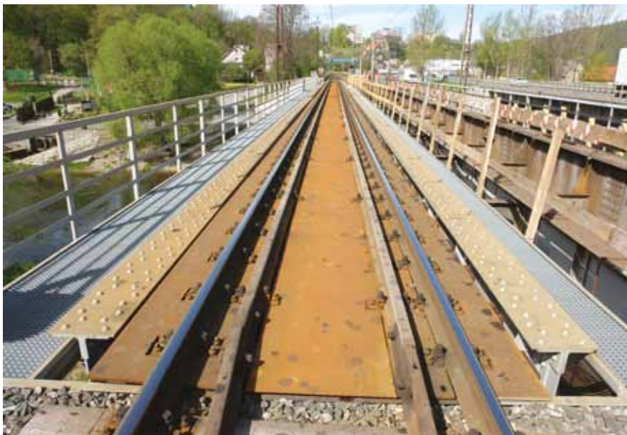
Rys 11. Nawierzchnia na przęsłach w torze nr 2 po remoncie.
