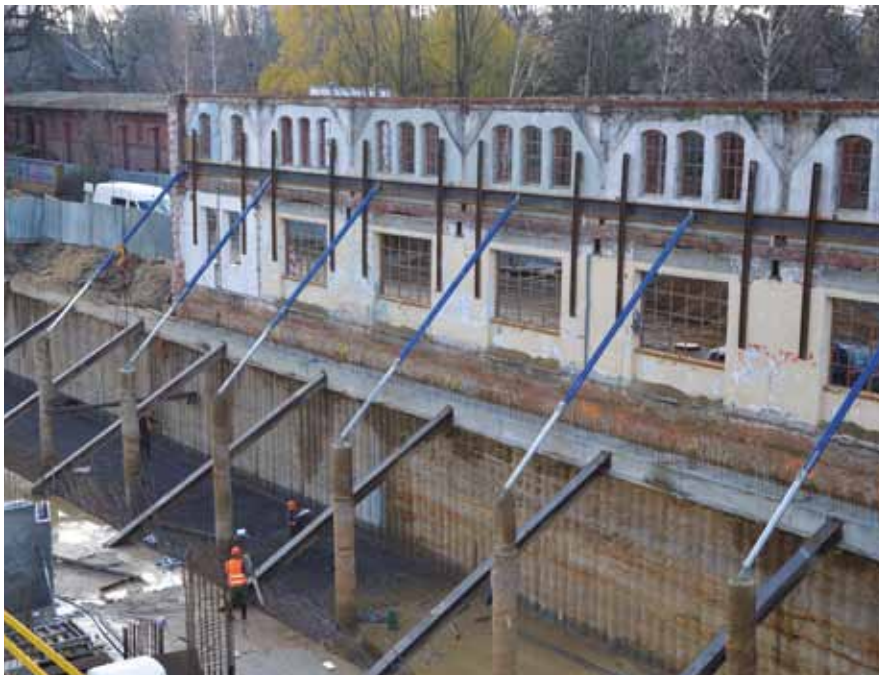
Fot. 6 Zabezpieczenie zabytkowej ściany oraz głębokiego wykopu za pomocą palisady z pali VDW
