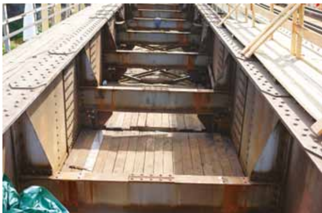
Rys 8. Widok na przęsła w torze nr 1 podczas remontu – zdemontowana konstrukcja jezdni.
