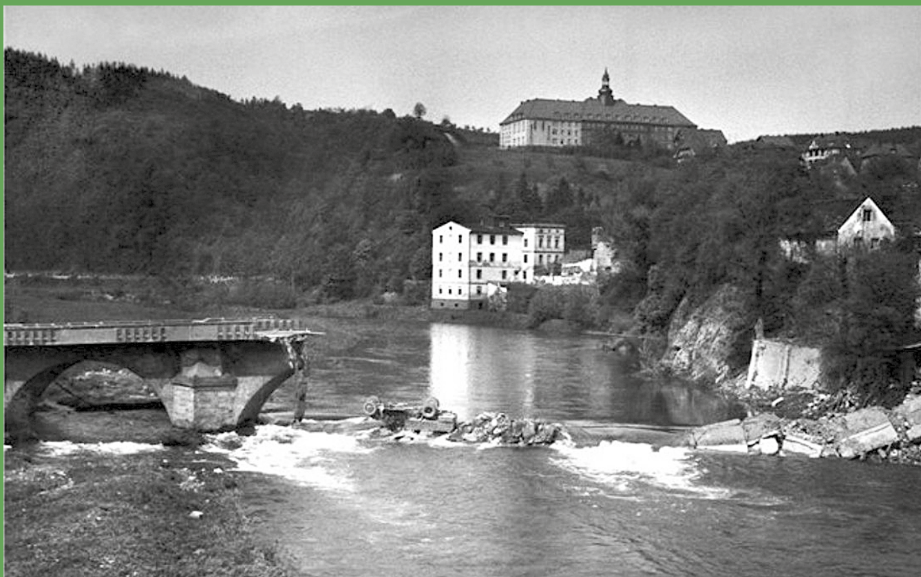
Rys. 9. Zniszczony przez saperów niemieckich most kamienny w Bardzie.
