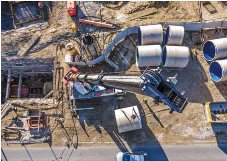
17.04.2019 r. - Przeciskanie ostatniego odcinka rur Hobas PU (rur ze specjalną wewnętrzną wykładziną na bazie żywicy poliuretanowej).
