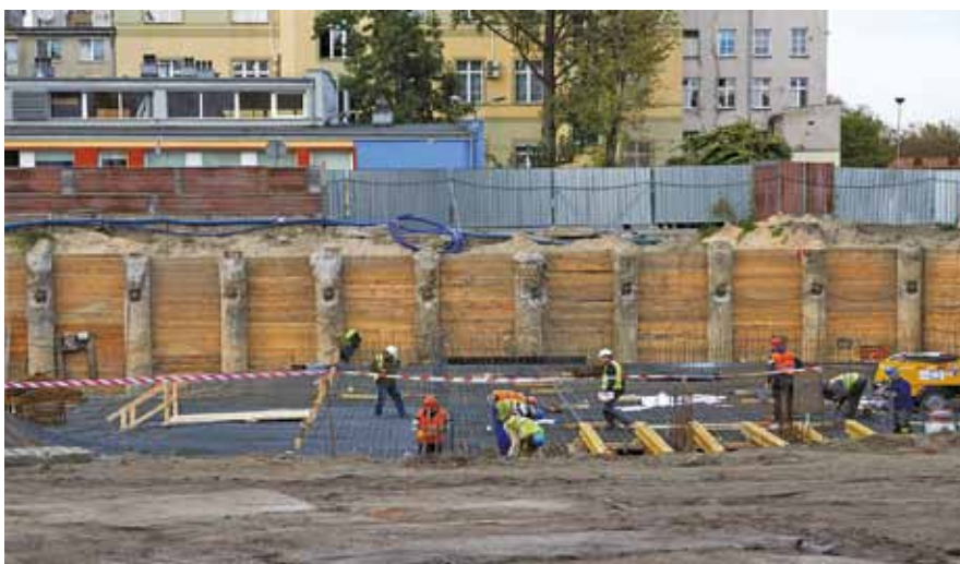
Fot. 4 Zabezpieczenie głębokiego wykopu za pomocą kotwionej obudowy berlińskiej na palach CFA
