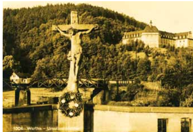
Rys 2. Widok mostu kolejowego z mostu kamiennego w latach 20-tych XX wieku.
