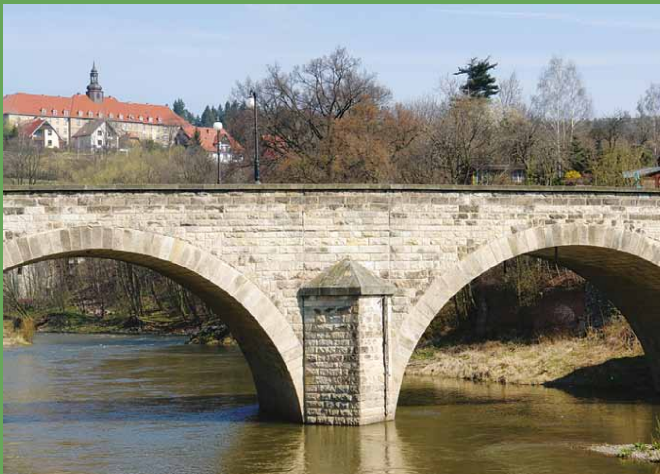
Rys. 12. Filar i przęśła środkowe mostu od strony dolnej wody. Stan po odbudowie w 1950 roku.
