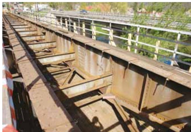
Rys 9. Prace remontowe na przęsle od strony Międzyzlesia w torze nr 1.
