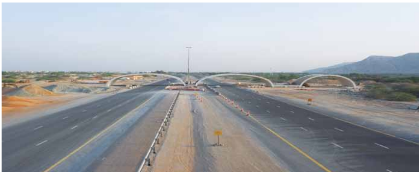
Rysunek 8. Montaż powłok stalowych
