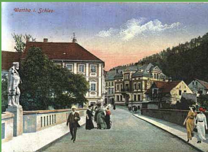
Rys. 8. Widok figur ukrzyżowanego Chrystusa i św. Jana Nepomucena na moście po przebudowie w 1908 roku.
