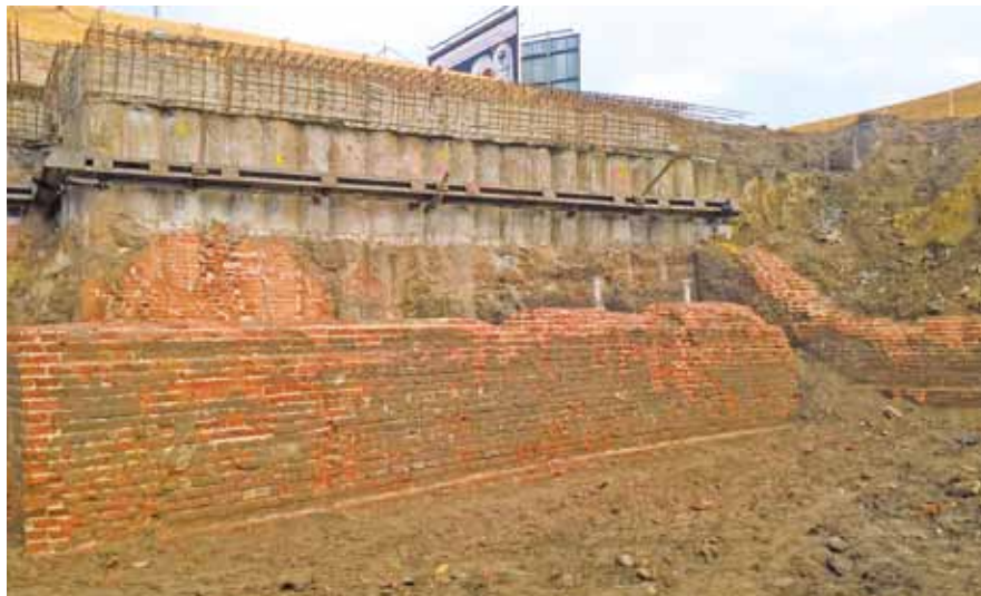
Fot. 1 Realizacja palisady VDW w fundamentach przedwojennego młyna – technologia dobrana odpowiednio do warunków terenowych
