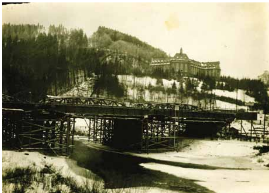
Rys 3. Wymiana przęseł mostu kolejowego prowadzona przez firmę Beuchelt S.A w połowie lat 30-tych XX wieku.
