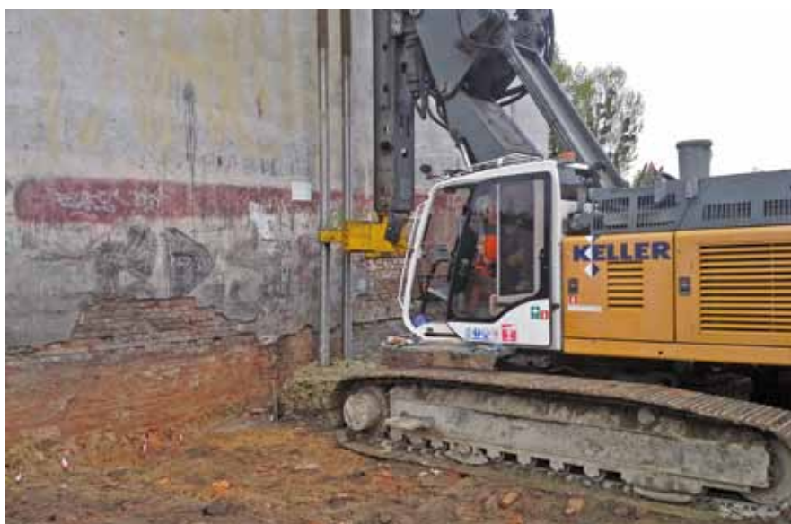
Fot. 2 Realizacja zabezpieczenia wykopu w bliskim sąsiedztwie istniejącego obiektu
