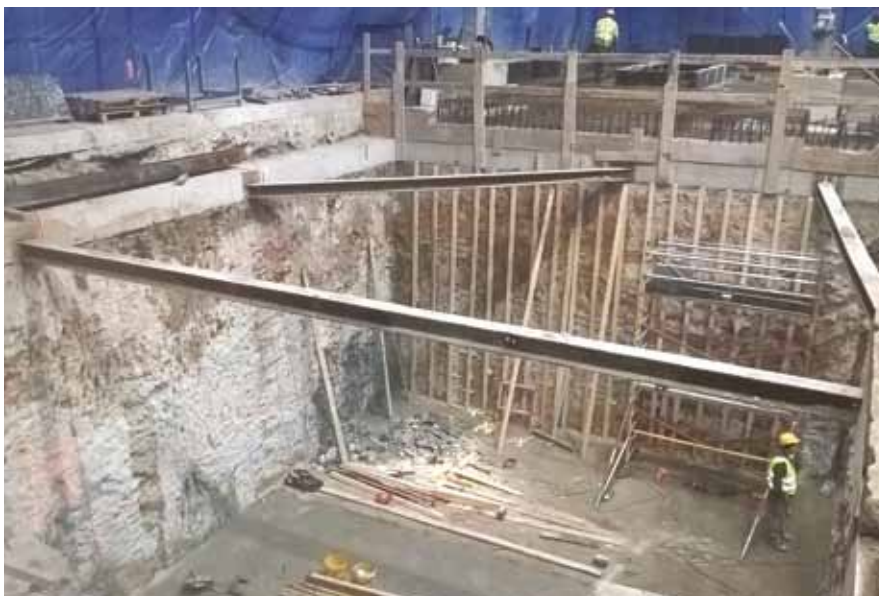
Fot. 7 Głęboki wykop pod komorę technologiczną zrealizowany w technologii iniekcji wysokociśnieniowej (Soilcrete)
