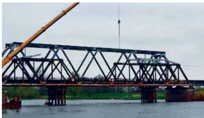
Ryc. 8. Rozbórka przęsła nurtowego. Fot. Damian Drwięga, Nowak-Mosty Sp. z o.o.
