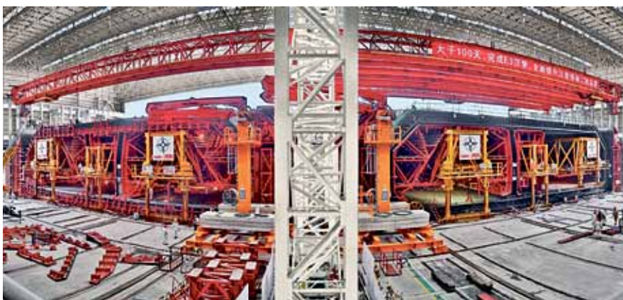
Fot. 11 Urządzenia przejazdne do budowy najdłuższego na świecie tunelu zatapianego
