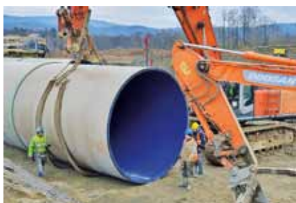
Ryc. 4. Urządzenia przelewowe stanowią dwa równoległe rurociągi CC-GRP DN3600 o całkowitej długości 2 x 270 m. Projekt: Hydroprojekt Wrocław Sp. z o.o.
