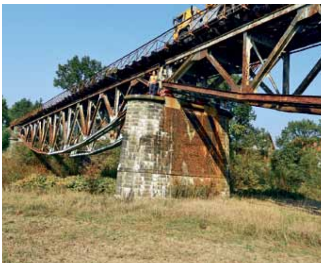
Rys. 6. Widok na filar obiektu podczas przeglądu mostu prowadzonego przez dra inż. Józefa Rabięę
