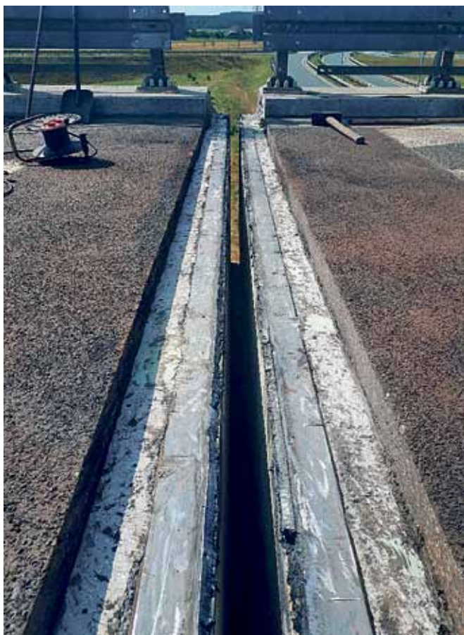
Wymiana dylatacji na wiadukcie drogowym - WA19 w ciągu autostrady A4
