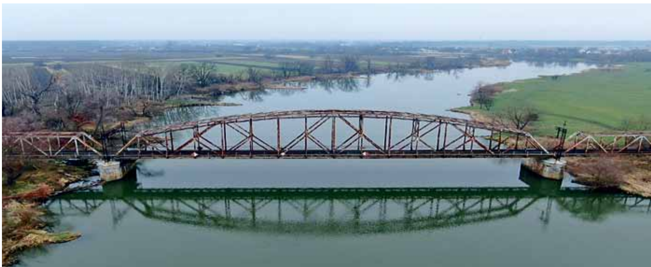
Ryc. 8. Odbudowane przesła nurtowe nr 5 (widok od strony górnej wody).
