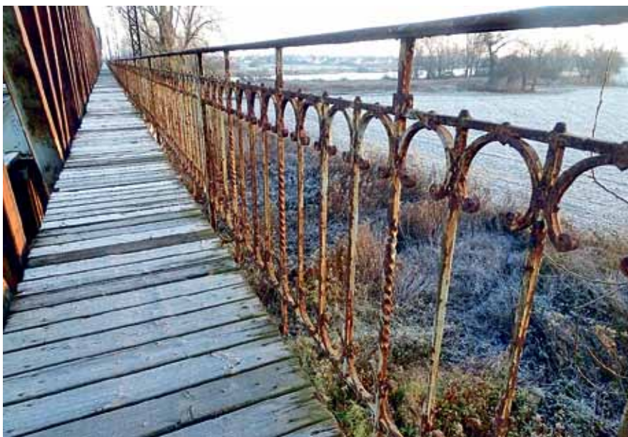
Ryc. 10. Przęsło nr 9. Chodnik służbowy z oryginalną historyczną balustradą.
