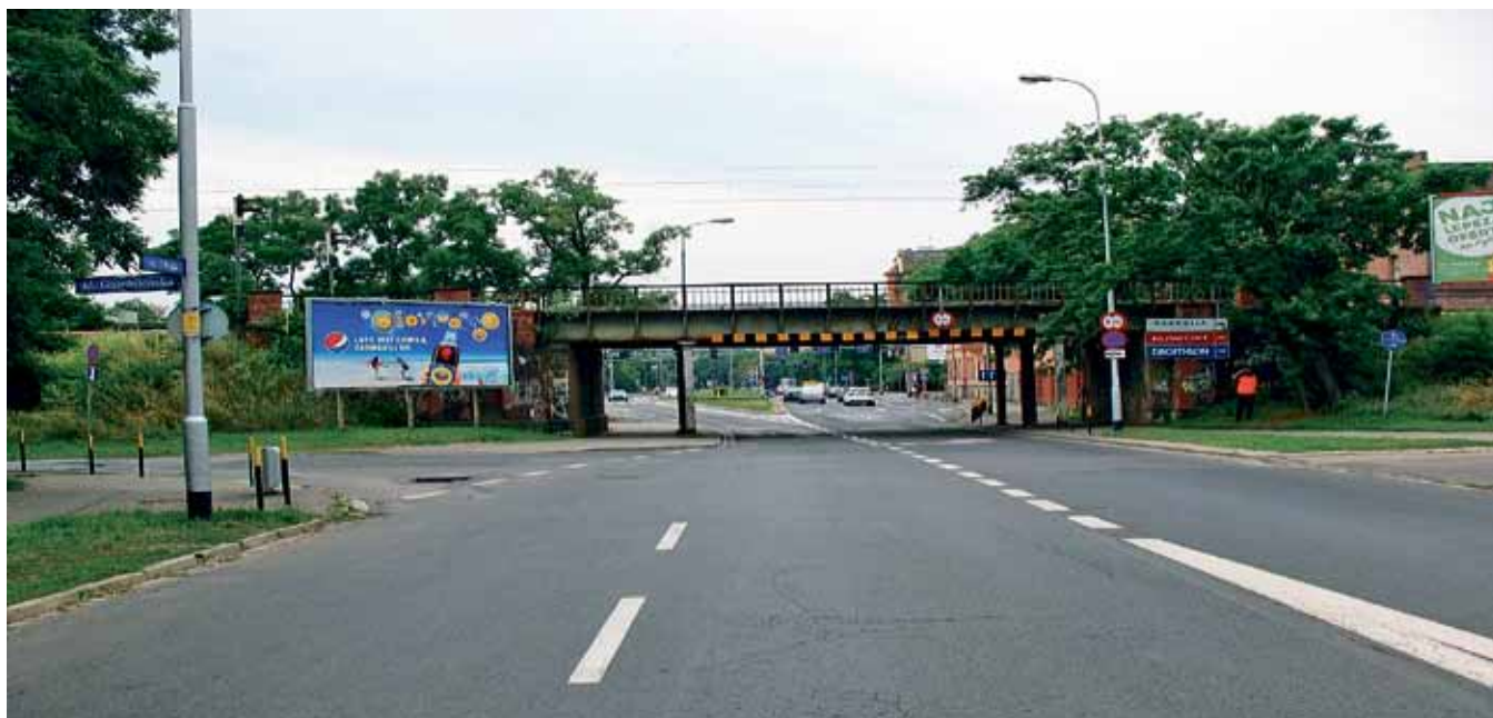
Fot. 2. Wiadukt nad ul. Długą przed przebudową – widok od strony Starogrobłowej (autor BPK Mosty s.c.)
