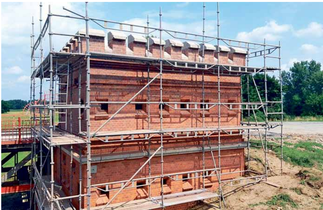
Ryc. 17. Strażnica przy wjeździe na most przygotowana do remontu elewacji. Fot: Berger Bau Polska Sp. z o.o.
