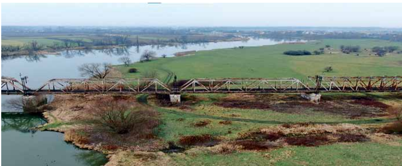
Ryc. 7. Odbudowane przesła zalewowe nr 3 i 4 (widok od strony górnej wody). Identyčną konstrukcję ma przesła nr 6.
