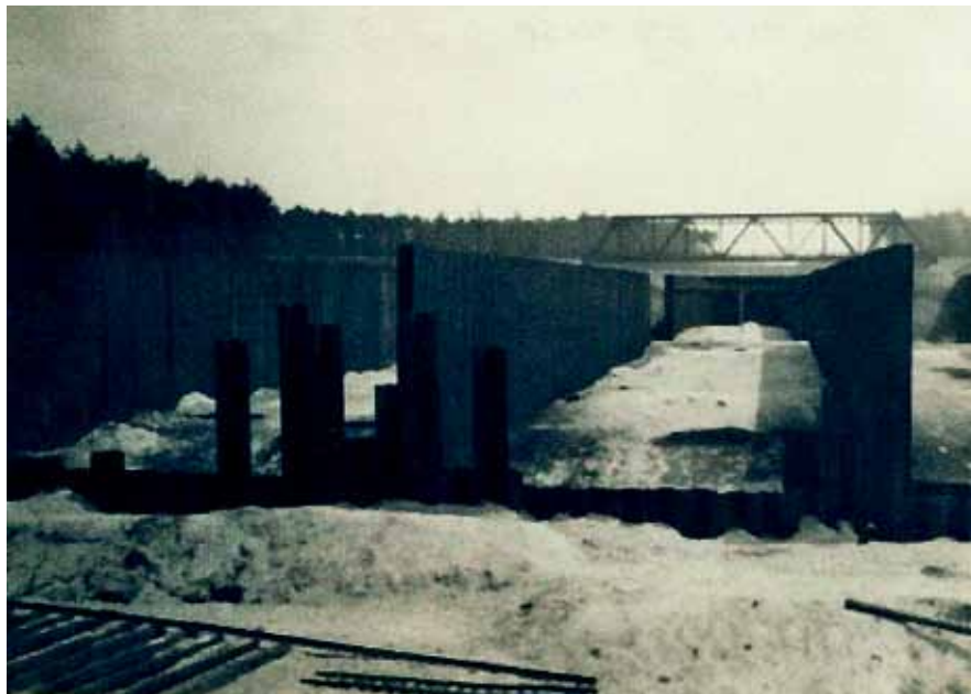
Fot. 1. Zdjęcie mostu w km 3,81 kanału Gliwickiego, zdjęcie z 1936 r. (źródło: https://www.facebook.com/kanalgliwicki/posts/1062857900446063 )
