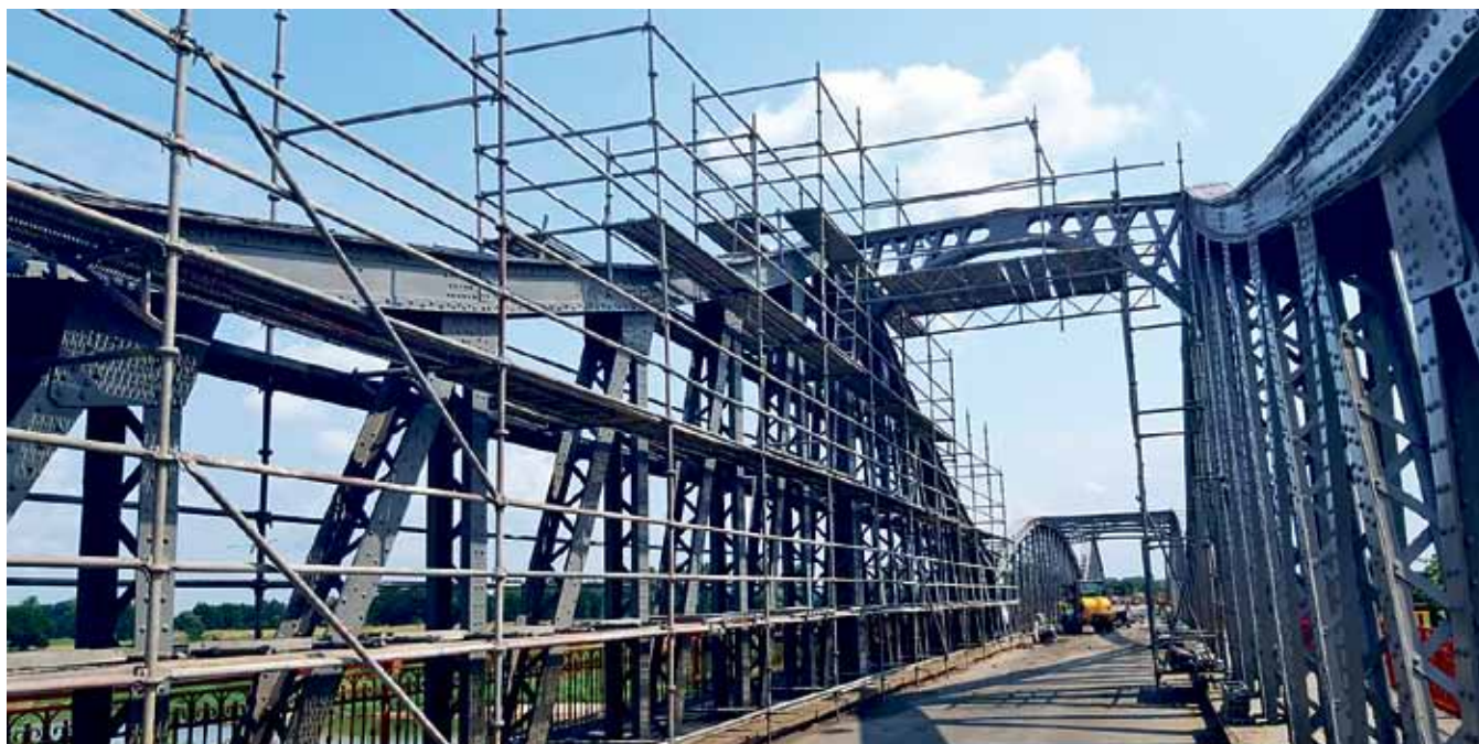
Ryc. 13. Przygotowanie konstrukcji mostu do prac antykorozyjnych. Fot: Berger Bau Polska Sp. z o.o.
