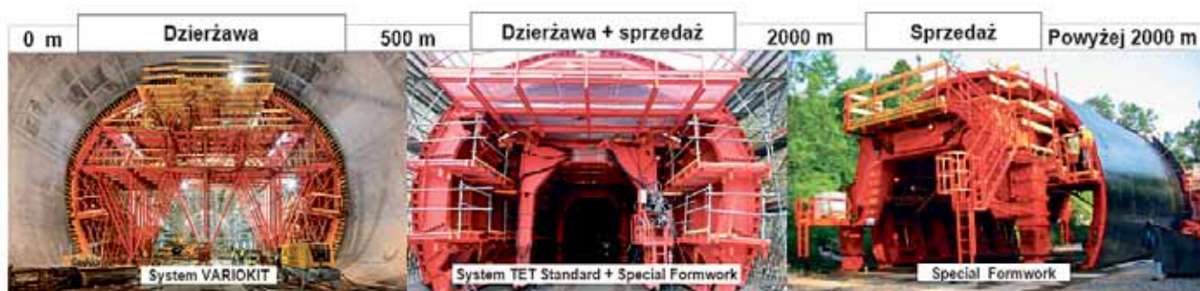
Fot.19 Schemat optymalnego wyboru dla metody górniczej w zależności od długości tunelu.
