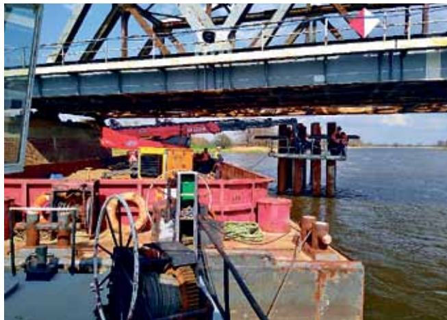
Ryc. 7. Montaż odczepu podpór tymczasowych. Fot. Damian Drwięga, Nowak-Mosty Sp. z o.o.
