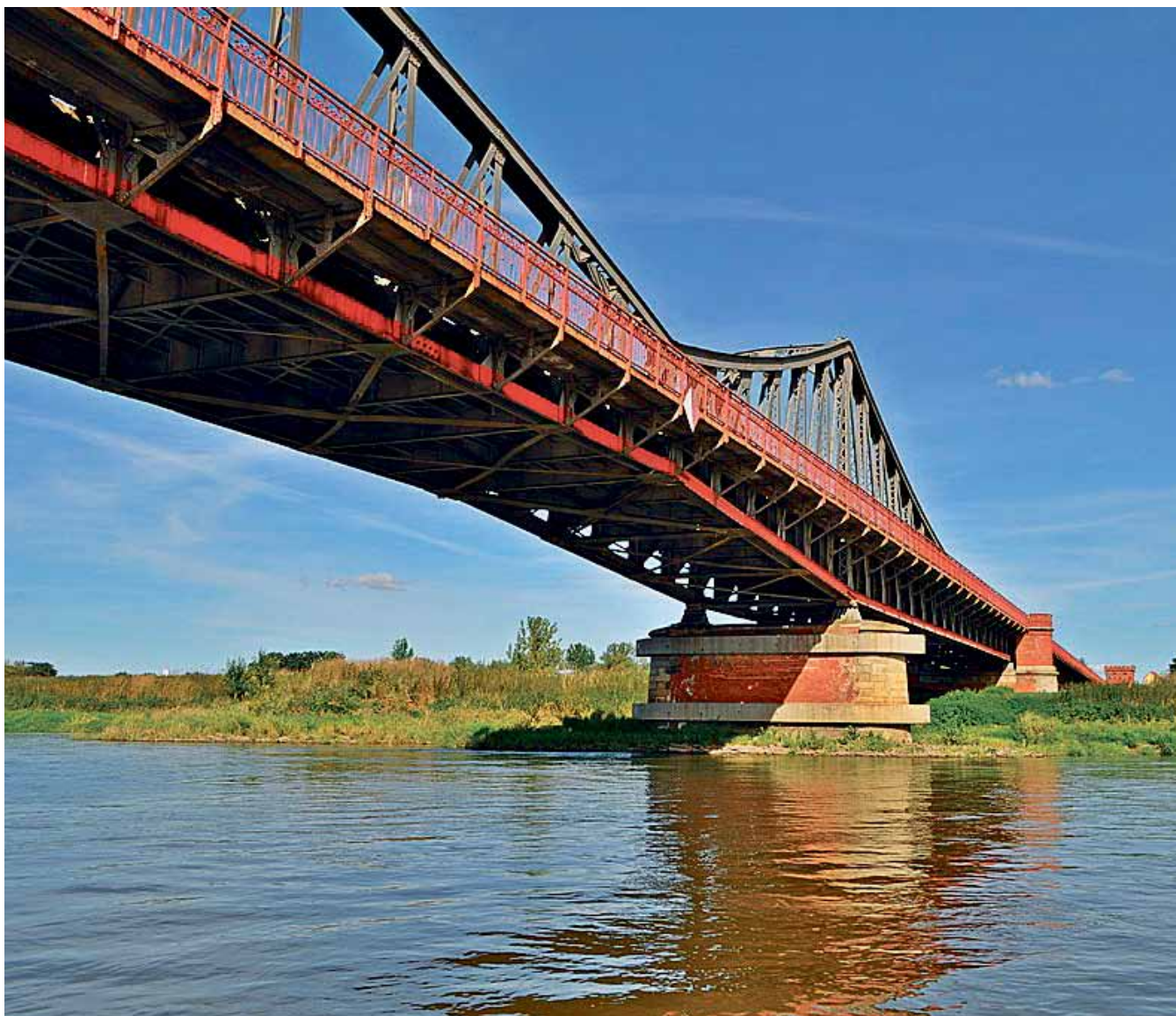
Ryc. 11. Widok części nurtowej mostu od strony górnej wody z lewego brzegu. Fot: Berger Bau Polska Sp. z o.o.
