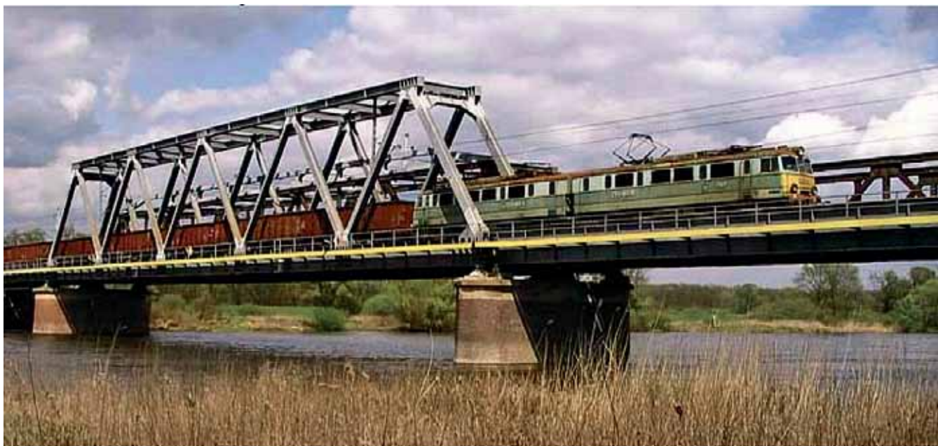
Ryc. 4. Most kolejowy w Nietkowicach tor nr 2. Całkowitą wymianę przęsła przeprowadzono w latach 1989-1993. Stan w 2007 roku. Fot. Leszek Budych.
