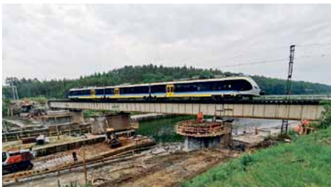
Fot. 11. Przebudowa podpór w torze nr 1, w tle przęsło w torze nr 2 (autor Ł. Winnicki ***)
