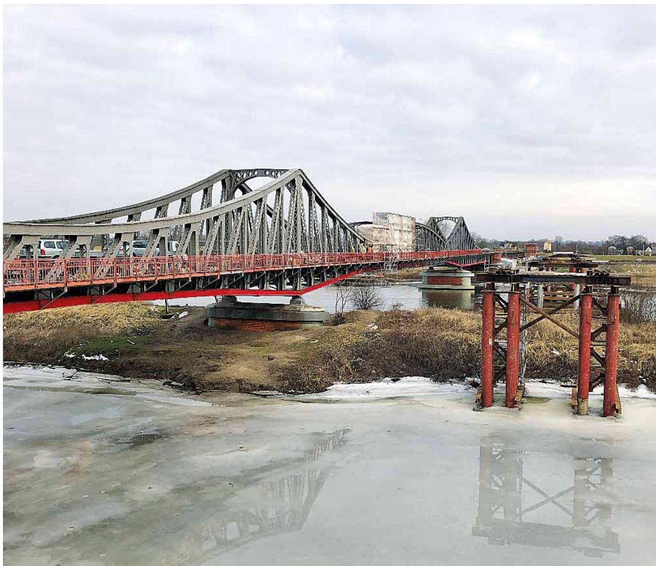
Fot. 1. Widok na podporę pośrednią
