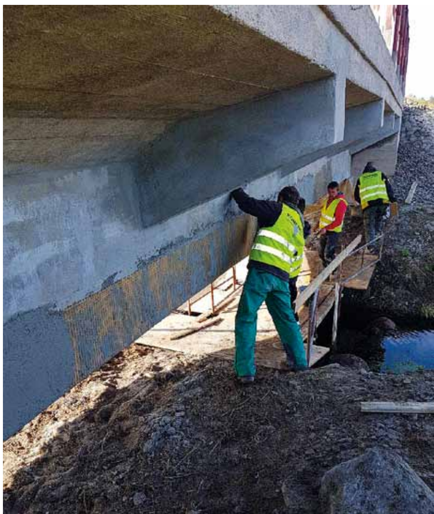
Prace remontowe wiaduktu na linii kolejowej Nr. 40 wykonywane były przez 4 osoby na czynnym szlaku kolejowym.
