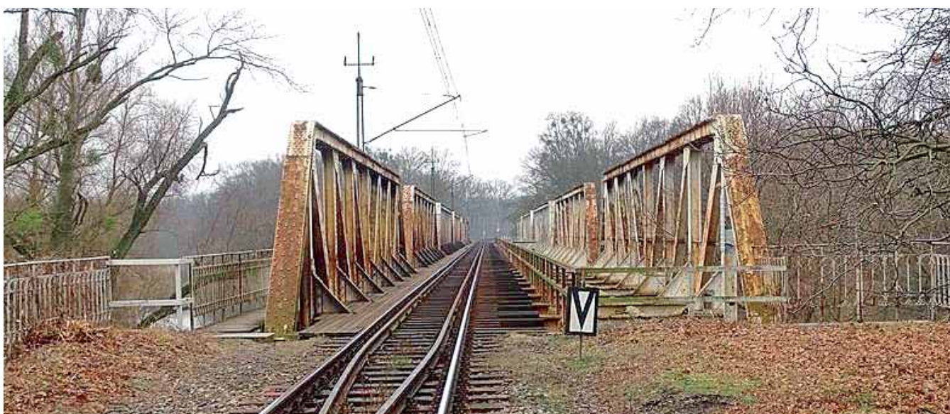
Ryc. 16. Wjazd na obiekt od strony stacji Opole Groszowice.
