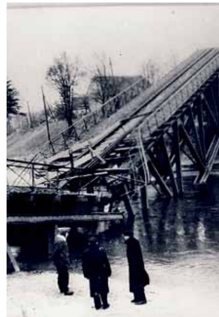
Rys. 5. Widok przęsła nurtowego po wysadzeniu wiosną 1945 r.
