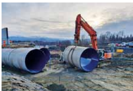
Ryc. 5. Odcinki rury GRP o podwyższonych parametrach fizycznych typu HOBAS DN3600 PN01 SN16000 ze specjalną poliuretanową wykładziną wewnętrzną w trakcie budowy urządzenia przelewowego. Fot. Amiblu Poland Sp. z o.o.
