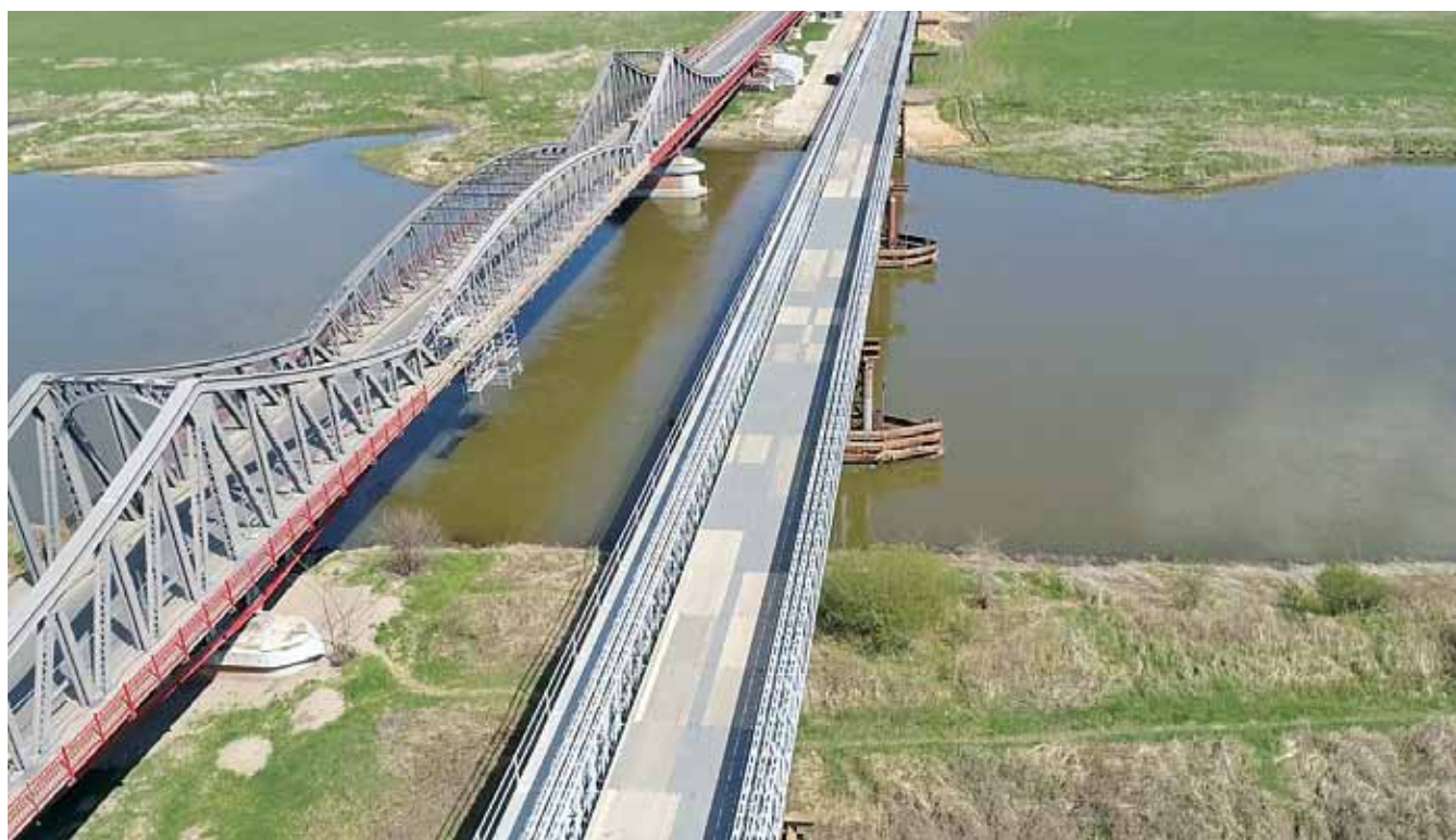
Fot.5. Widok z lotu ptaka na oba mosty.
