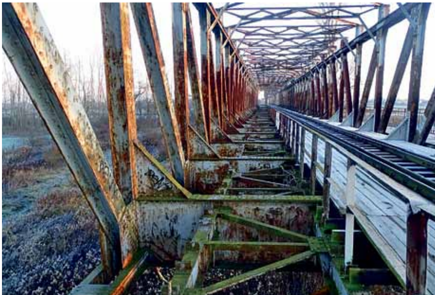
Ryc. 9. Pomost przęsłowy nr 7, 8 i 9 (widok w stronę Opola). Czynny tor nr 2, nawierzchnia toru nr 1 zdemonstrowana, krawędź pomostu na międzytorzu zabezpieczona balustradą, po prawej stronie zewnętrzny chodnik służbowy zabezpieczony oryginalną, kutą balustradą.
