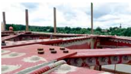
Rys. 8. Wymiana stężeń górnych oraz wzmocnienie poprzecznic wykonane podczas trwającego remontu
