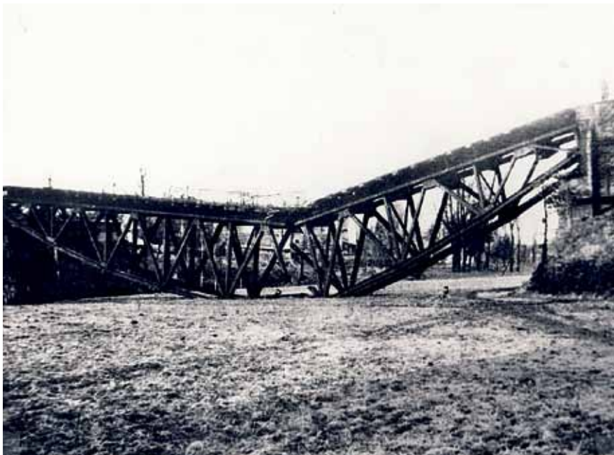
Rys. 4. Widok przęsła zalewowego po wysadzeniu wiosną 1945 r.
