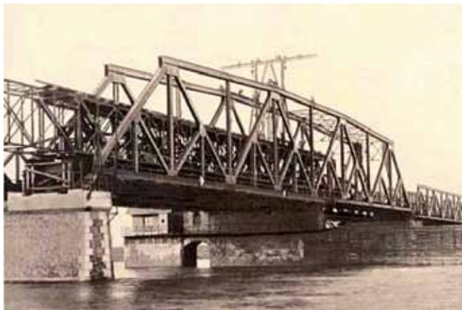
Rys 2. Wymiana przęsła mostu kolejowego w Nietkowicach w 1926 roku. Montaż przęsła nadrzecznego o rozpiętości 75,0 metra wykonany przez firmę Buchelt & Co z Zielonej Góry. Zbiory prywatne Leszek Budych.
