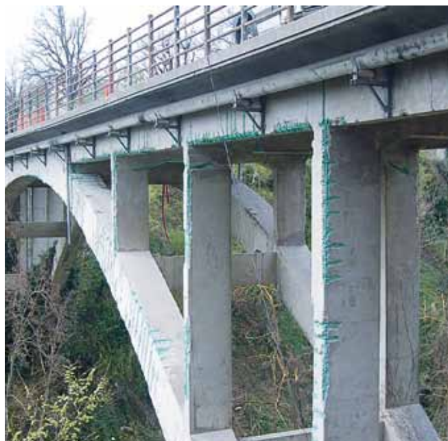
Fot. 1. Realizacja wzmocnienia mostu żelbetowego, łukowego z pomostem górnym.
