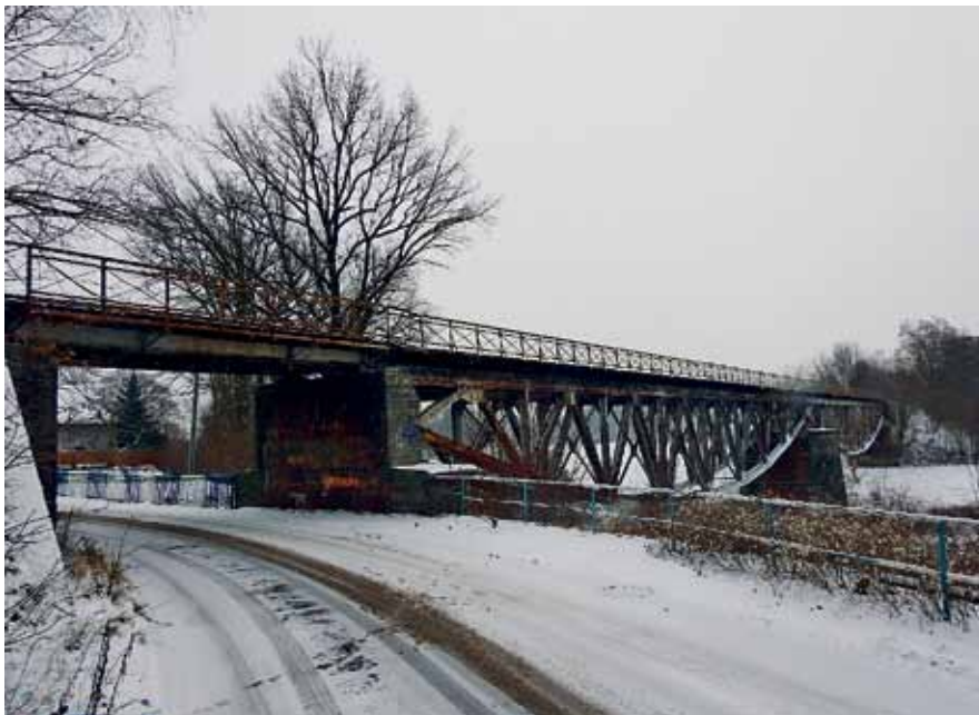
Rys. 2. Widok obiektu od strony wody górnej, z poziomu ul. Odrzychowskiej
