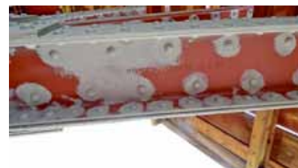
Rys. 10. Słupki przęsła kratownicowego z elementów Huty Kościuszkę pochodzący z powojennej naprawy
