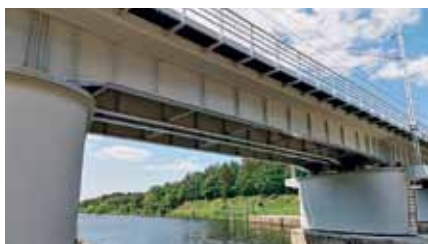
Fot. 17. Obiekt po zakończeniu zasadniczych prac, widok na przęsło nr 2 (autor Ł. Winnicki ***)
