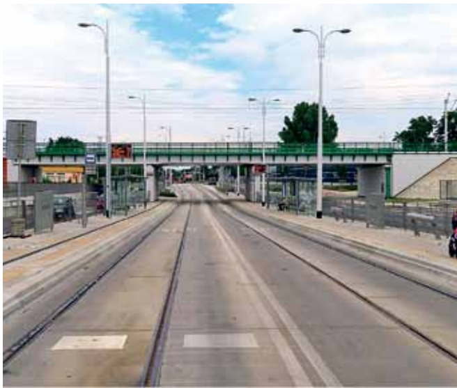
Fot. 6. Wiadukt nad ul. Długą po przebudowie – widok od strony ul. Poznańskiej źródło: http://www.polska-org.pl , autor Ryszard Janowski
