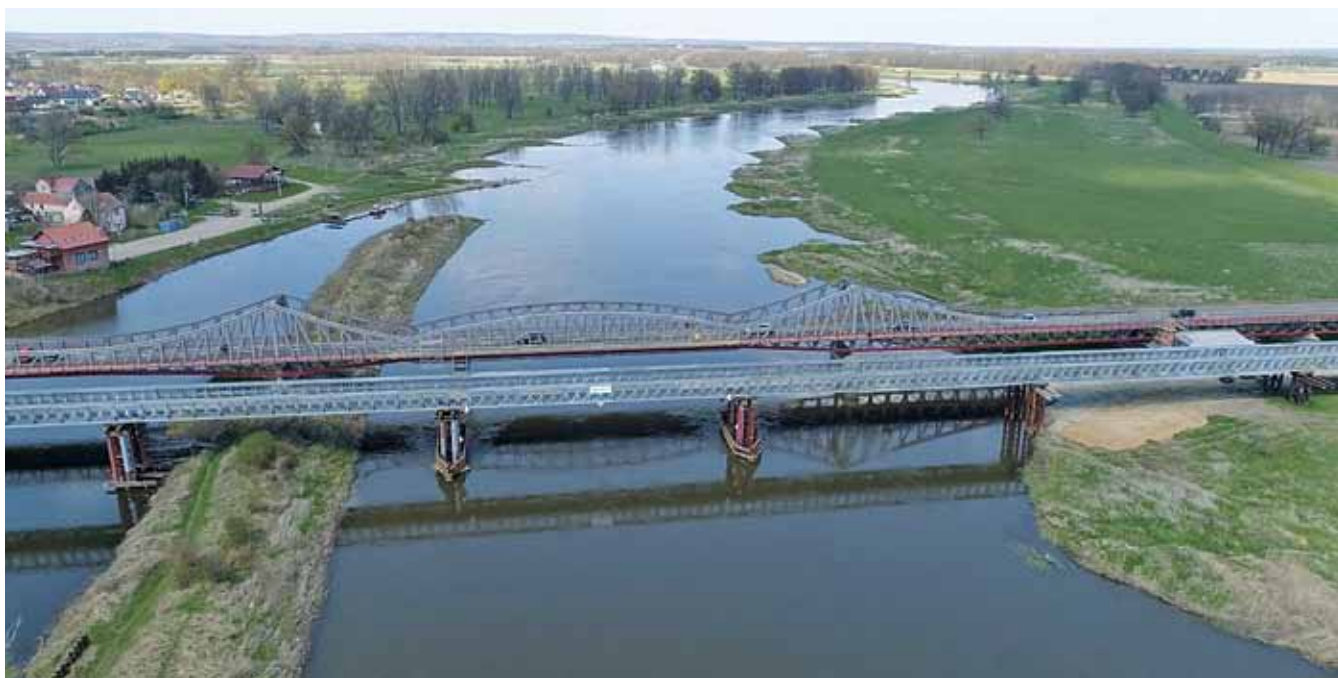
Fot. 4. Widok ogólny na most.
