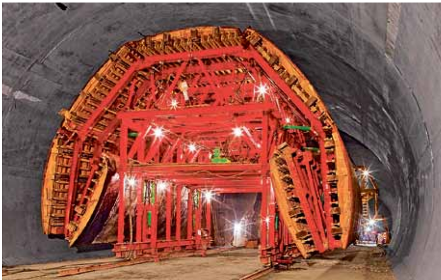
Fot. 20 Tunel Losenberg to długość 124m o zmiennej geometri realizowana w 13 sekcjach betonowanych co 2 dni.
