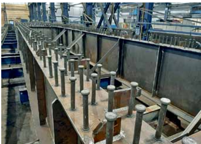
Fot. 12. Próbnny montaż konstrukcji stalowej w wytwórni (autor Adam Bukowski, EXBUD Konstrukcje)
