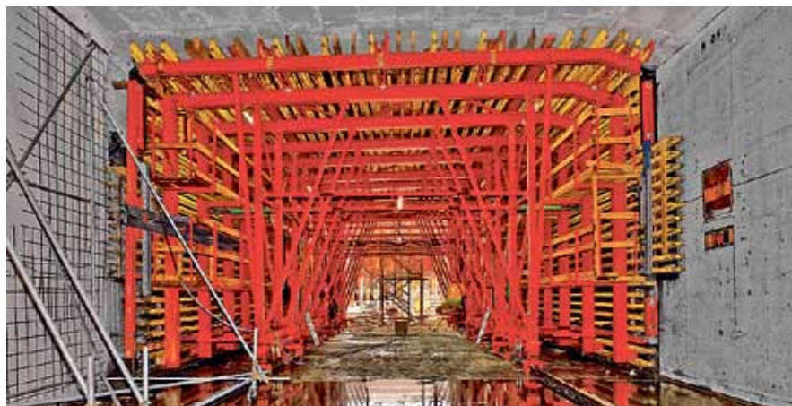
Fot. 4 Wózek przejezdny na budowie tunelu U-Bahn w Hamburgu.
