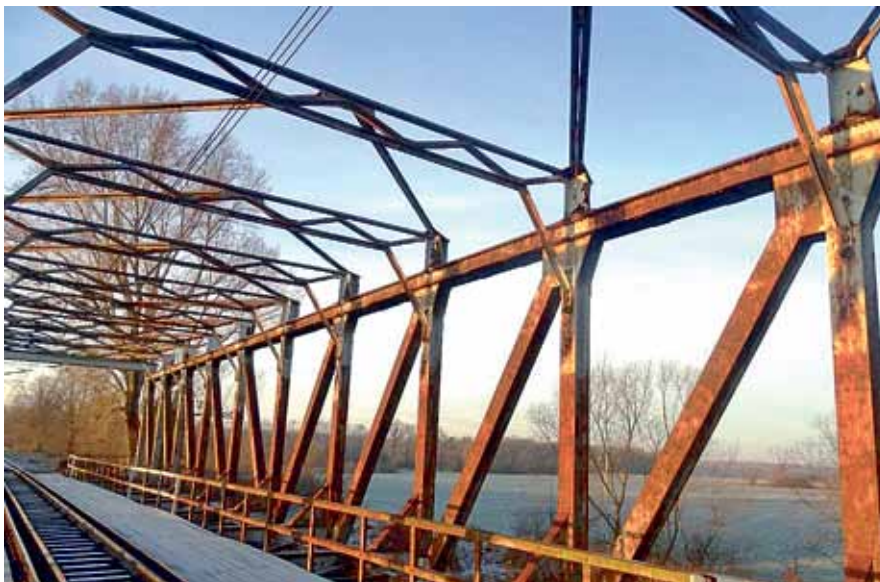
Ryc. 11. Przęsło nr 9. Widoczne podwyższenia stężeń górnych, wykonane w związku z elektryfikacją linii.
