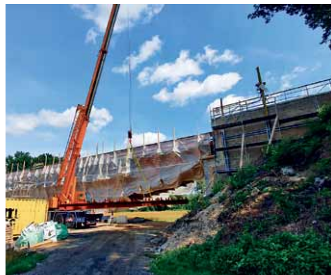
Rys. 7. Montaż nowego rusztu jezdni podczas trwającego remontu
