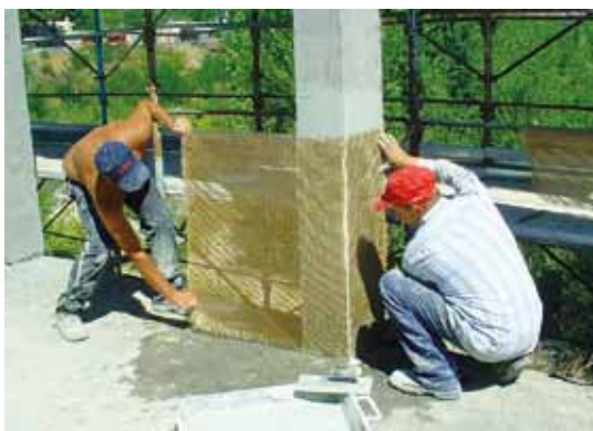
Fot. 2. Realizacja wzmacnienia mostu żelbetonowego, łukowego z pomostem dolnym.
