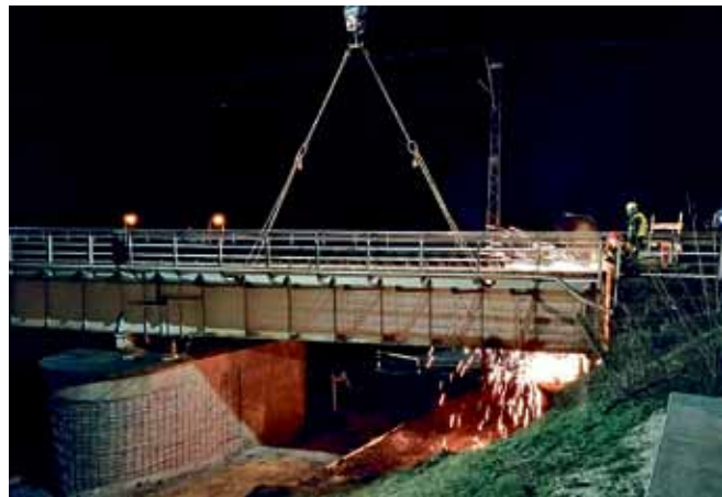
Fot. 8. Demontaż przęsła w torze nr 1, przęsło nr 4 (autor Ł. Winnicki ***)
