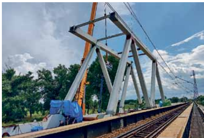
Ryc. 9. Montaż przęsła nurtowego przed nasunięciem. Fot. Damian Drwięga, Nowak-Mosty Sp. z o.o.
