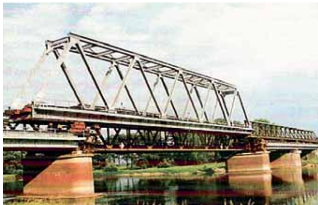
Rys 3. Wymiana przęsła mostu kolejowego w Nietkowicach w 1993 roku. Montaż przęsła nadrzecznego o rozpiętości 75,0 metra wykonany przez Zakład Budowy Mostów nr 3 (ZBM-3) Sp. z o.o. z Wrocławia. Zbiory prywatne Leszek Budych.
