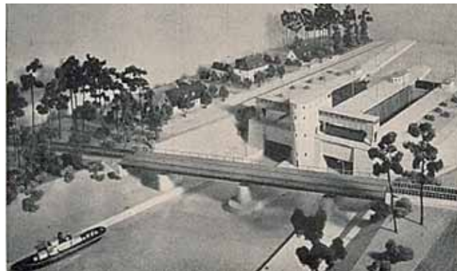
Fot. 4. Zdjęcie modelu śluzy Kłodnica wraz z widocznym motem kolejowym, usytuowanym na awanporcie dolnym (Die Bautechnik, 17. Jahrgang, Heft 49, Berlin, 17 luty 1939 r.)
