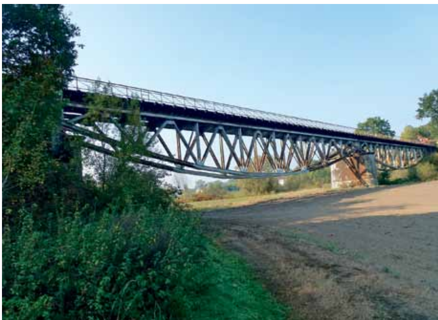
Rys. 3. Widok obiektu od strony wody dolnej, z poziomu terenu przy przyczółku od strony Nowogrodzka
