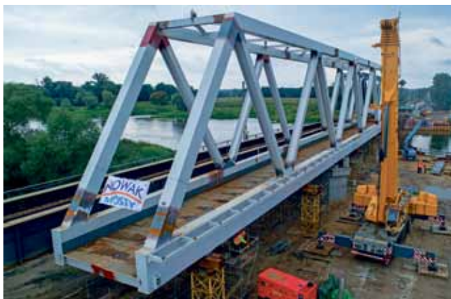
Ryc. 10. Montaż przęsła nurtowego przed nasunięciem. Fot. Michał Matysek, Nowak-Mosty Sp. z o.o.
