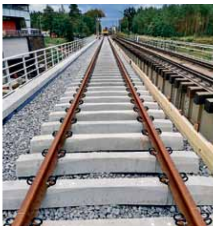
Fot. 14. Układanie nowej nawierzchni w torze nr 1, widok w kierunku Kędzierzyna Koźła (autor Ł. Winnicki ***)
