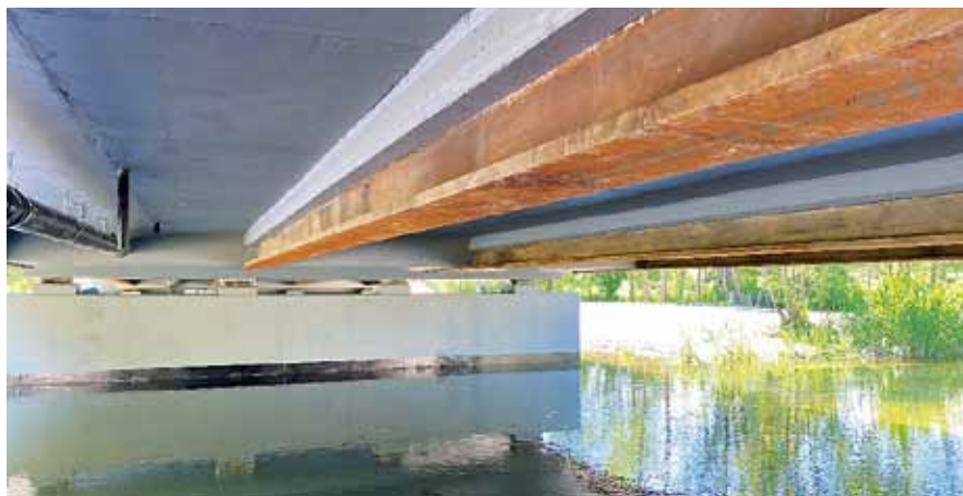
Rys. 6. Część stalowa mostu wykonana ze stali S460J2W
