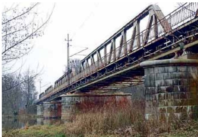
Ryc. 18. Ogólny widok obiektu od strony toru nr 2. Kształt filarów z izbicami o zwrocie przeciwnym do kierunku nurtu Odry sugeruje, że w czasie budowy obiektu Jezioro Panieńskie mogło mieć z nią połączenie i być w rzeczywistości, przynajmniej okresowo, jej odnogą.
