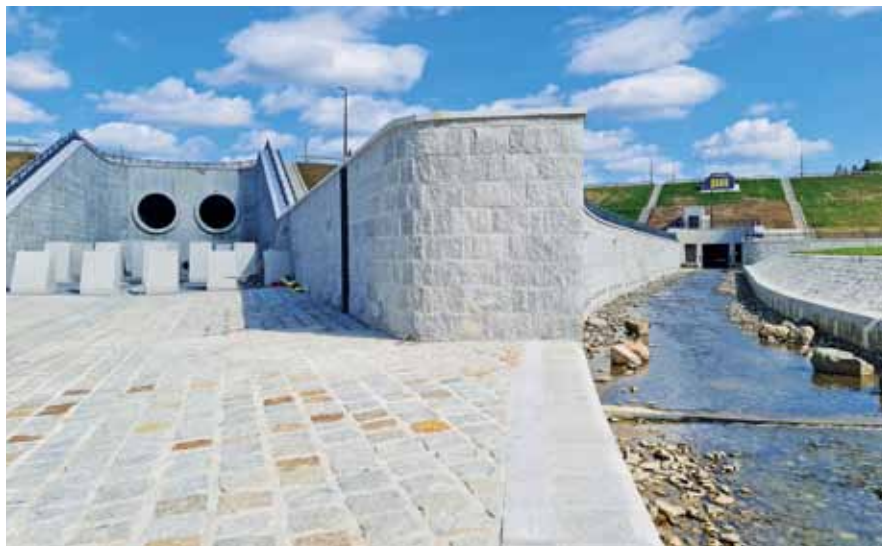
Ryc. 6. Dolne stanowisko z wylotem rurociągów i szykanami do rozpraszania energii kinetycznej wody – zdjęcie budowli wykonane w trakcie prowadzonych jeszcze prac budowlanych. Fot. Hydroprojekt Wrocław Sp. z o.o.
