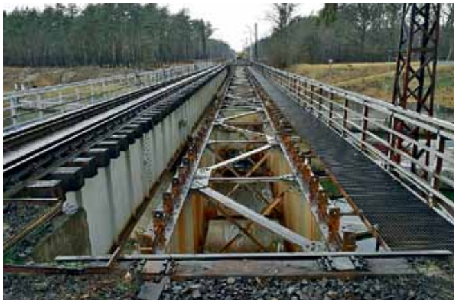
Fot. 7. Rozebrana konstrukcja nawierzchni w torze nr 1, widok z kierunku Opola (autor Ł. Winnicki ***)
