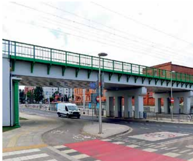
Fot. 7. Wiadukt nad ul. Długą po przebudowie – widok od strony ul. Starogrodzkiej źródło: http://www.polska-org.pl , autor Ryszard Janowski
