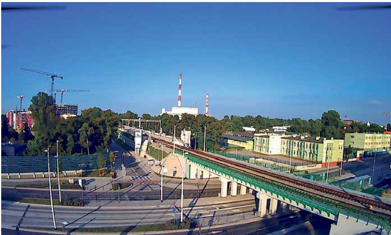
Fot. 8. Wiadukt nad ul. Długą po przebudowie – widok z drona (autor Systra S.A.)
