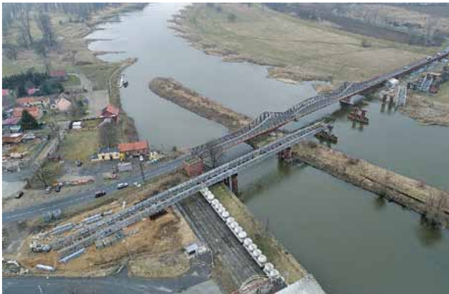
Fot. 2. Nasuwanie części nurtowej mostu.
