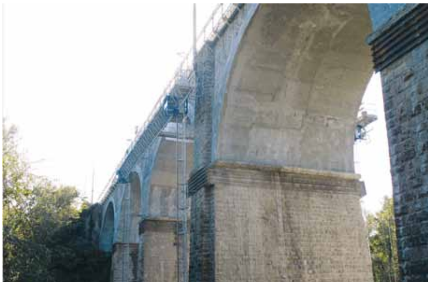
Fot. 2. Realizacja wzmacnienia mostu żelbetonowego, łukowego z pomostem dolnym.
