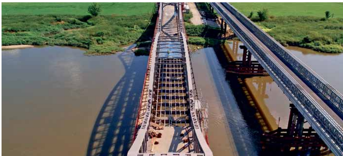
Ryc. 14. Wykonanie płyty żelbetowej pomostu realizowane etapami. Fot: Berger Bau Polska Sp. z o.o.
