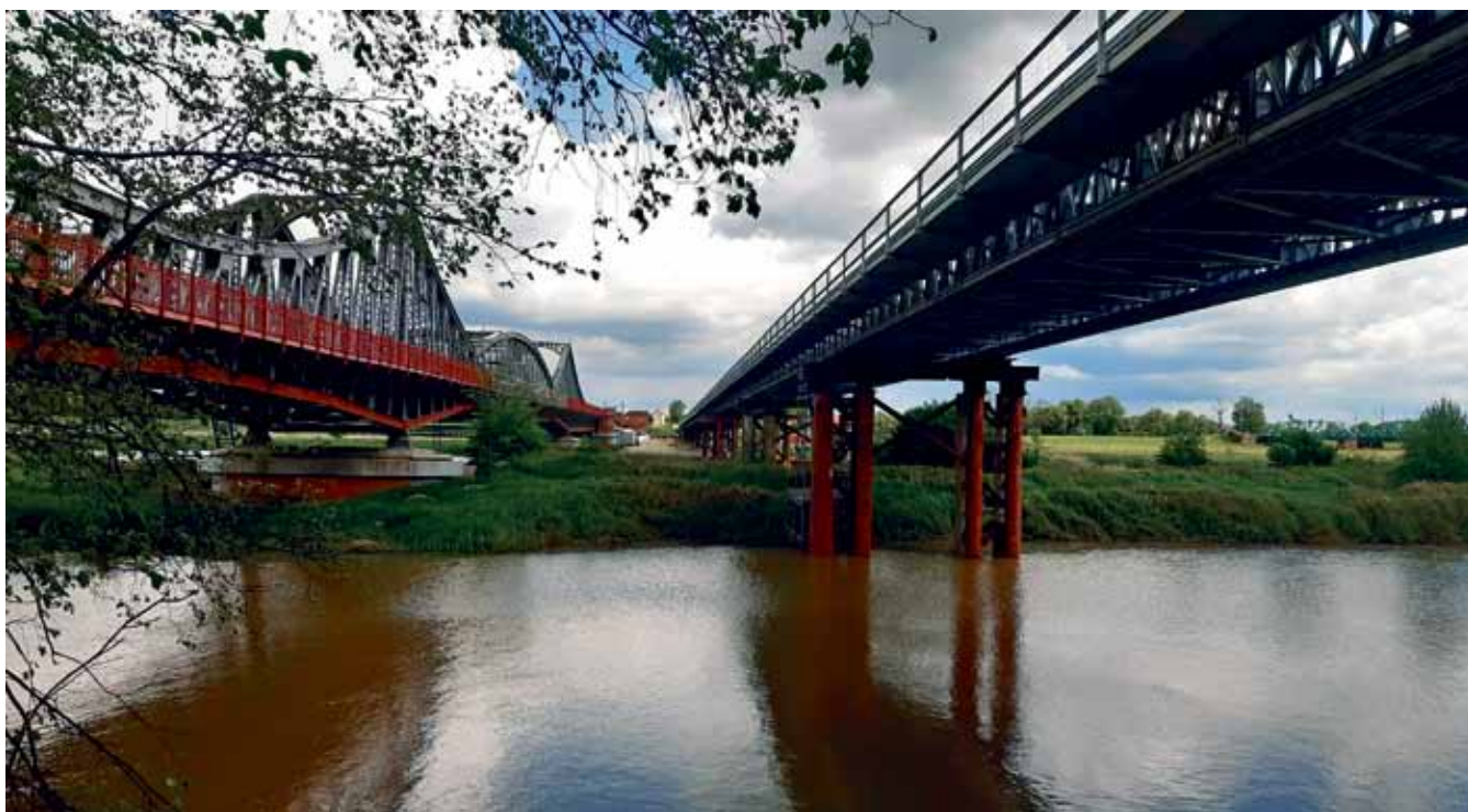
Ryc. 12. Widok części nurtowej remontowanego mostu i równolegle zbudowanego tymczasowego mostu objazdowego. Fot: Berger Bau Polska Sp. z o.o.
