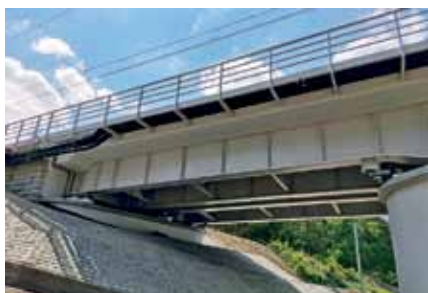
Fot. 16. Obiekt po zakończeniu zasadniczych prac, na podporach widoczne tłumiki STU, widok na przęsło nr 1 (autor Ł. Winnicki ***)
