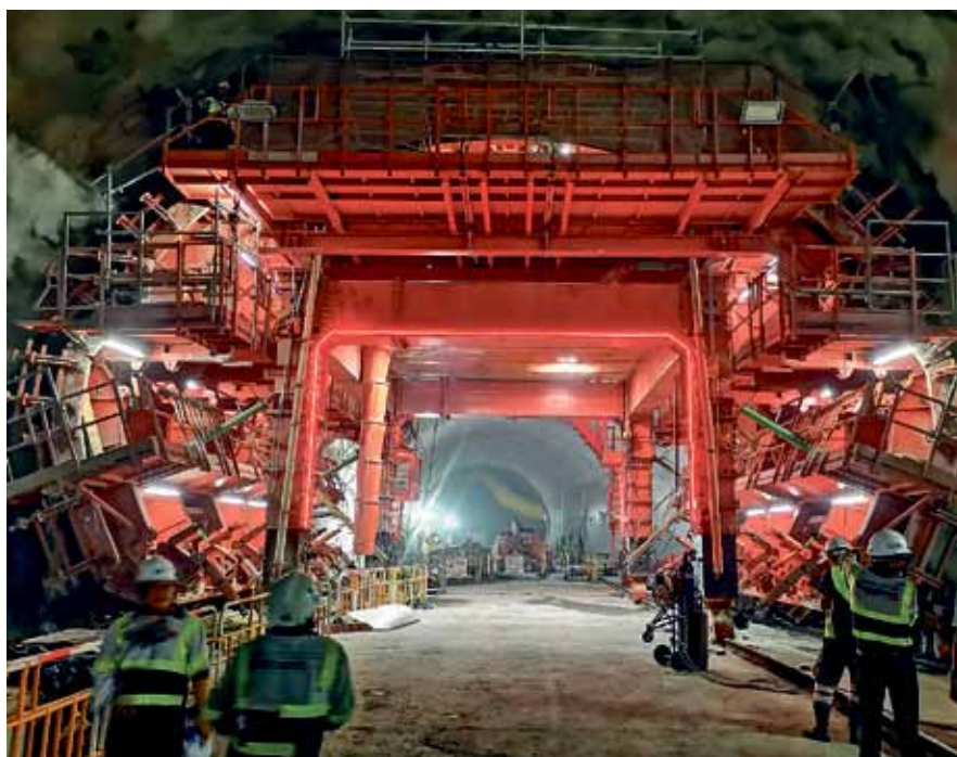
Fot.18 Maszyna formująca PERI z poszyciem z blachy stalowej. Tunel o długości ponad 2 km (LAM TIN, Hong Kong)
