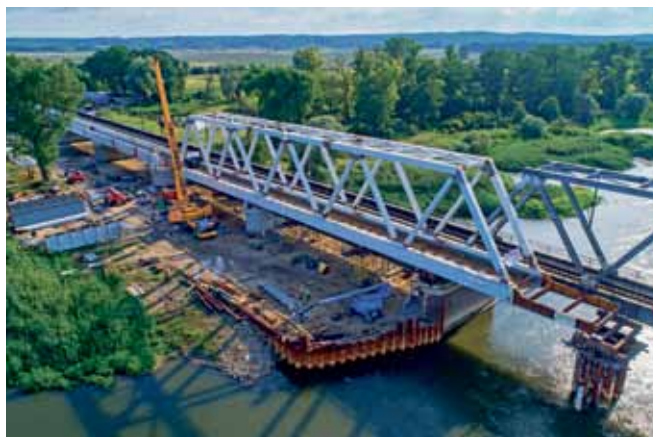
Ryc. 11. Montaż przęsła nurtowego przed nasunięciem. Fot. Michał Matysek, Nowak-Mosty Sp. z o.o.
