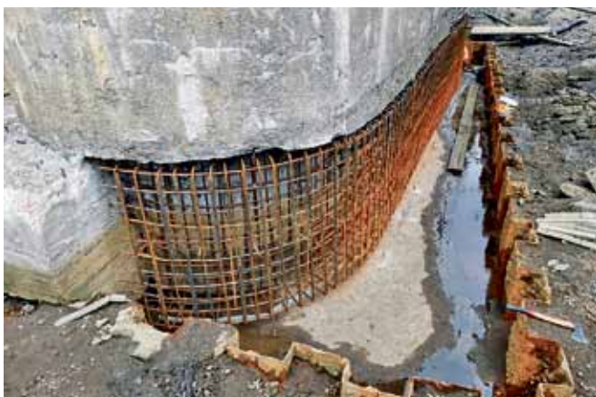
Fot. 9. Zbrojenie uciąglenia płaszcza żelbetowego podpory nr 2 (filar) (autor Ł. Winnicki ***)
