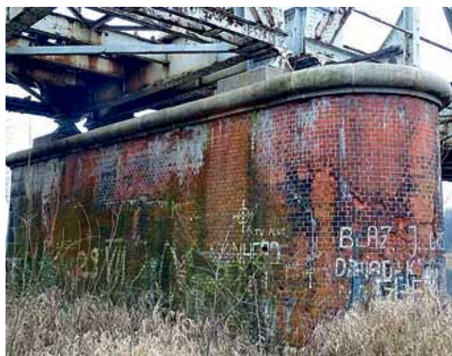
Ryc. 19. Podpora nr 6 (filar).
