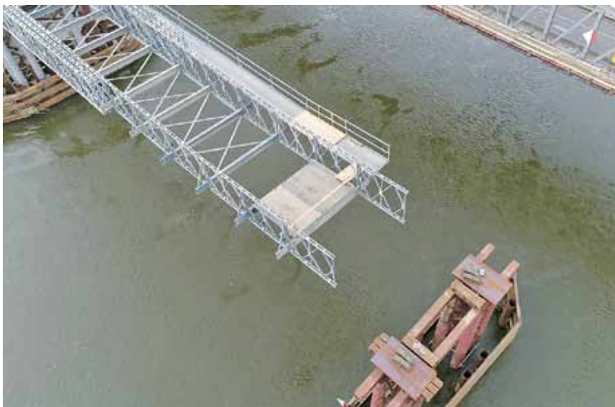
Fot. 3. Nasuwanie części nurtowej mostu. Widoczny dziób montażowy.
