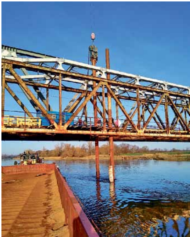
Ryc. 6. Montaż podpory tymczasowej w rzece Odrze. Fot. Damian Drwięga, Nowak-Mosty Sp. z o.o.
