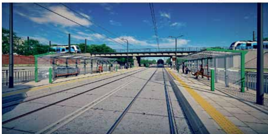
Budowa trasy tramwajowej wzdłuż ulic Popowickiej – Starogrobłowej – Długiej we Wrocławiu
