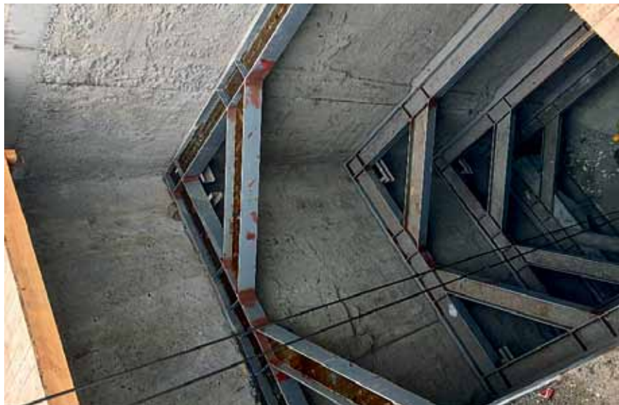
Rys. 2. Komora startowa – wykop docelowy w obudowie ścian szczelinowych. Fot. Keller Polska
