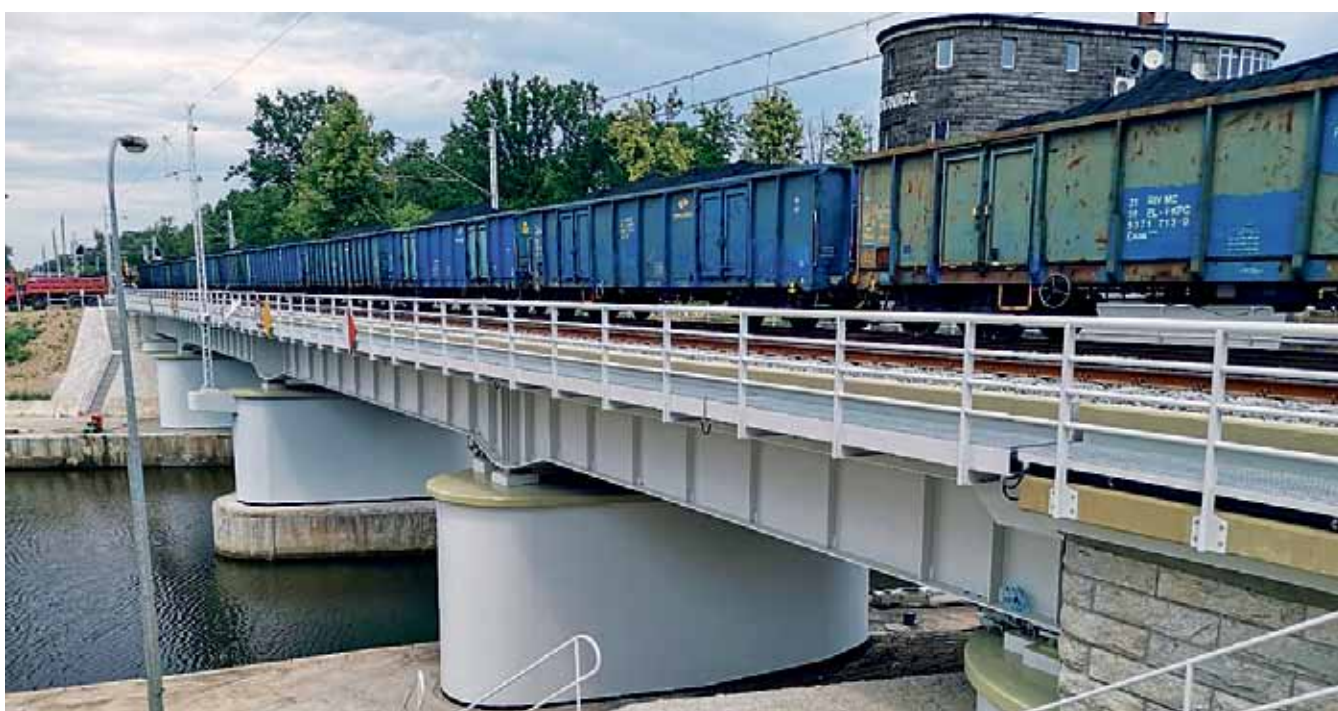
Fot. 18. Obiekt po zakończeniu prac, widok od strony toru nr 2 w kierunku Opola (autor Ł. Winnicki ***)
