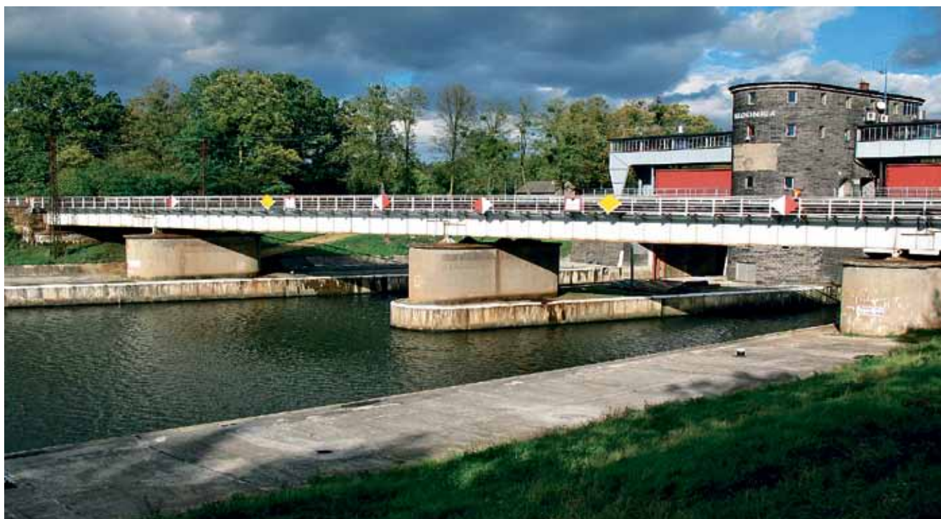
Fot. 6. Widok na obiekt przed przebudową, widok od strony toru nr 2 w kierunku Opola (autor BPK Mosty S.C.)
