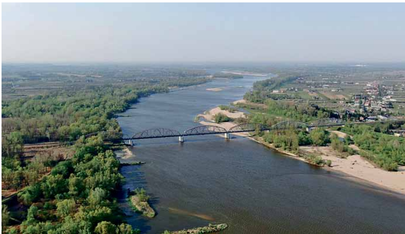
Fot. 3. Widok na istniejący most od strony górnej wody
