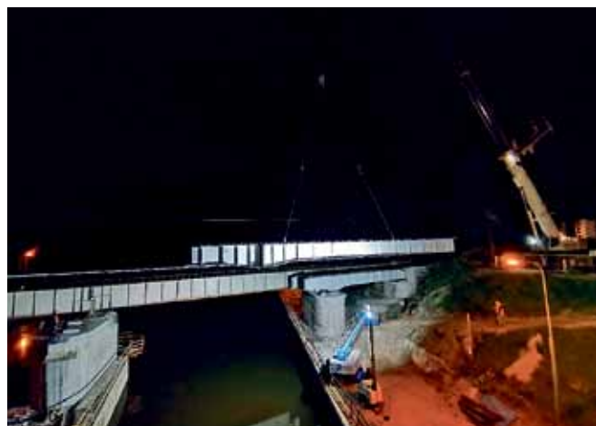
Fot. 13. Montaż konstrukcji stalowej w torze nr 1, widok ze śluzy Kłodnica (autor Ł. Winnicki ***)
