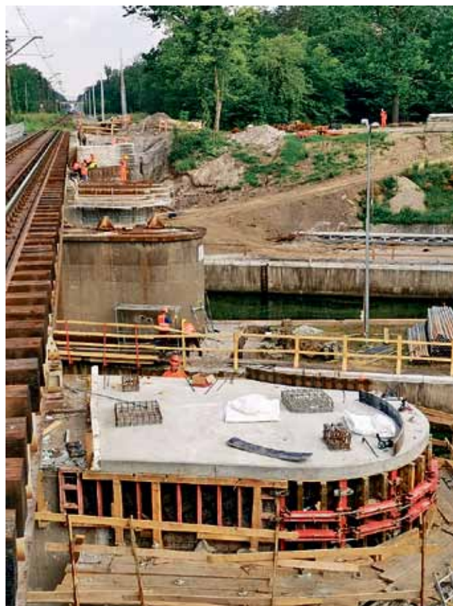
Fot. 10. Przebudowa podpór w torze nr 1, widok w kierunku Opola (autor Ł. Winnicki ***)
