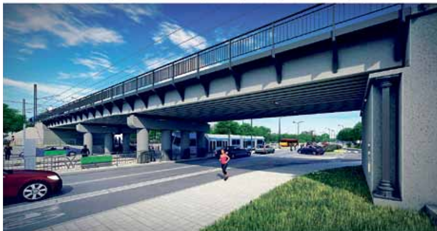
Budowa trasy tramwajowej wzdłuż ulic Popowickiej – Starogrobłowej – Długiej we Wrocławiu
