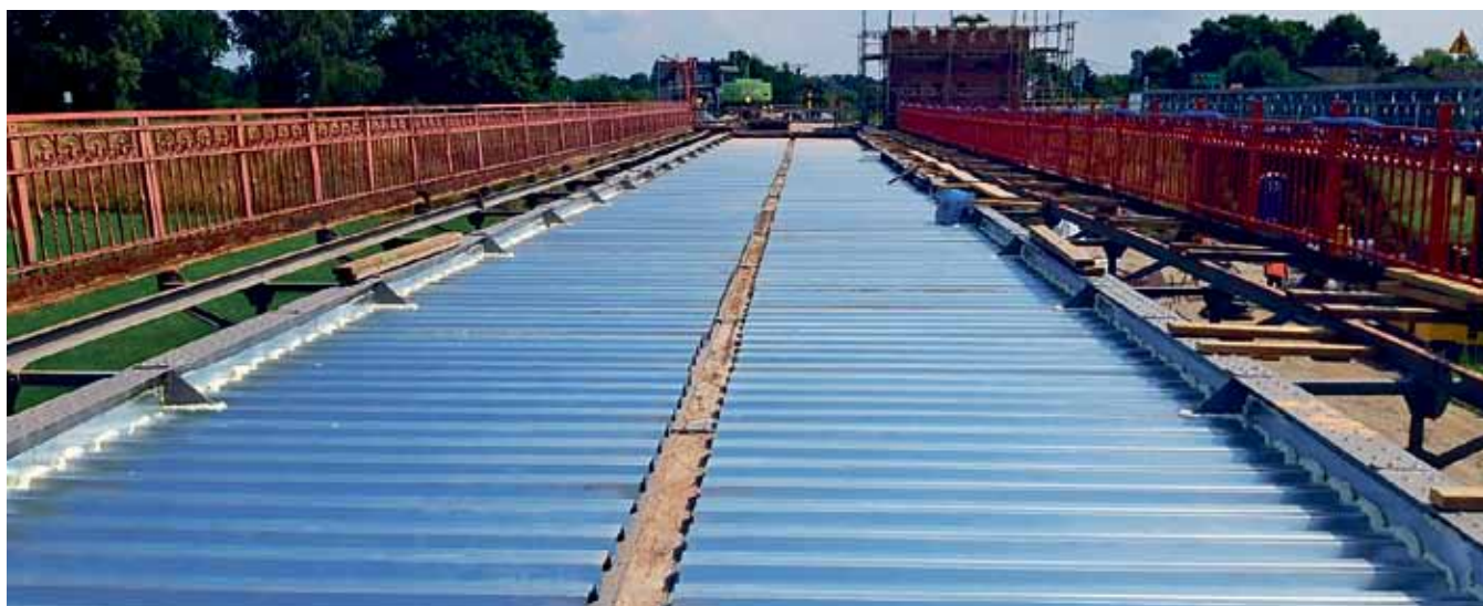
Ryc. 15. Przygotowanie do wykonania zbrojenia i wylania żelbetowej płyty pomostu w części mostu nad terenem zalewowym. Fot: Berger Bau Polska Sp. z o.o.
