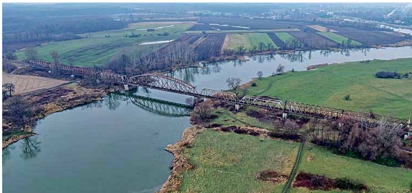
Ryc. 3. Ogólny widok istniejącej przeprawy od strony górnej wody. Kierunki linii przeciwne niż na powyższym schemacie, tj. Opole po prawej, Wrocław po lewej stronie.
