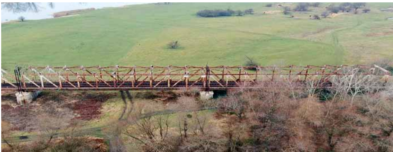
Ryc. 6. Przesła zalewowe nr 1 i 2 zachowane w pierwotnym kształcie (widok od strony górnej wody). Identyčną konstrukcję mają przesła nr 7, 8 i 9.
