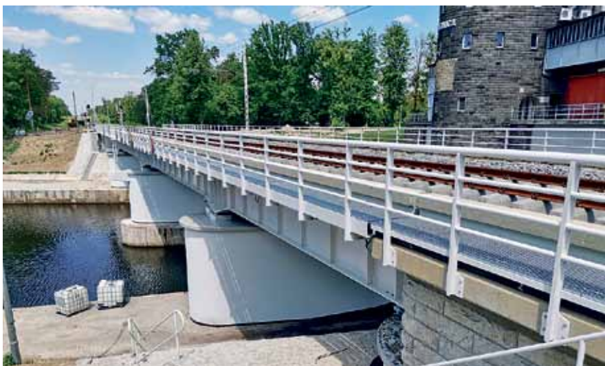
Fot. 15. Obiekt po zakończeniu zasadniczych prac, widok od strony toru nr 2 w kierunku Opola (autor Ł. Winnicki ***)
