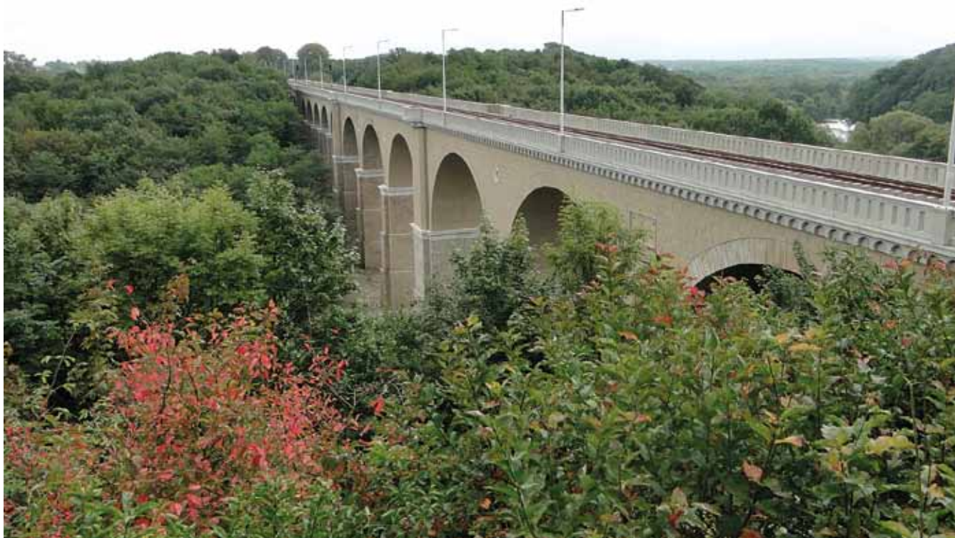
Fot. 3. Odrestaurowany kolejowy most graniczny przez Nysę Łużycką w Zgorzelcu.
