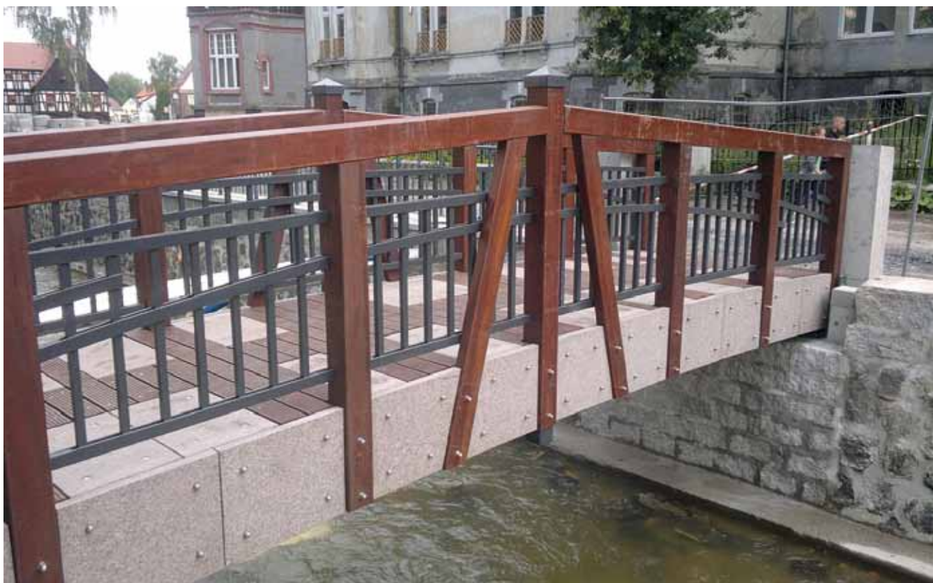
Fot. 7. Kładka z drewna bongossi i płyt kamiennych przez rzekę Miedziankę w Bogatyni.
