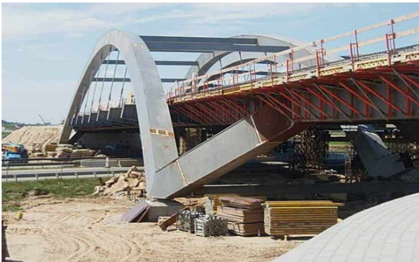
Fot. 2. Wiadukt łukowy stalowy WS-26 w ciągu zachodniej obwodnicy Poznania nad autostradą A2 w trakcie realizacji.
