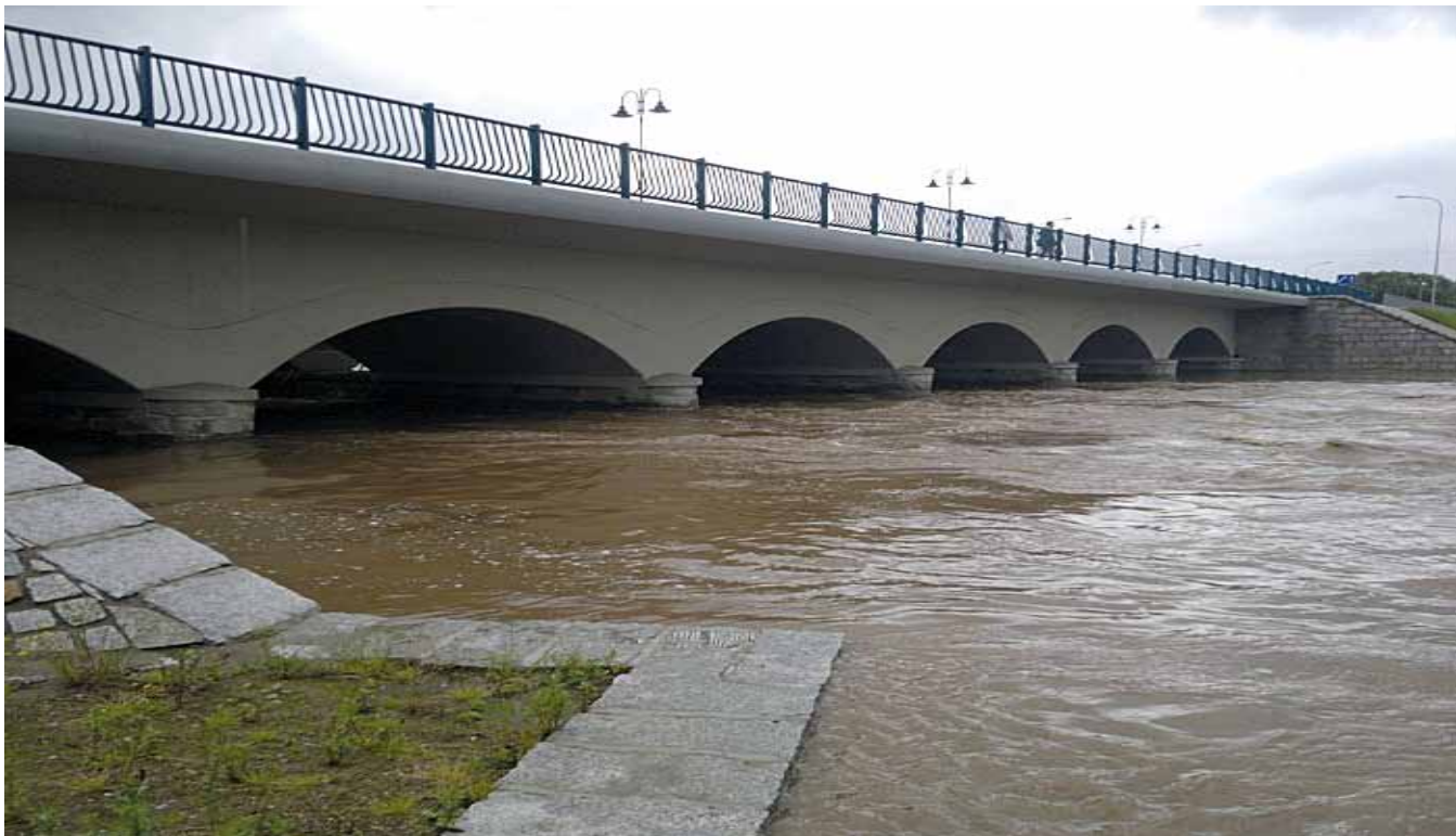
Fot. 4. Most przez Bóbr w ciągu południowej obwodnicy Jeleniej Góry w czasie powodzi.
