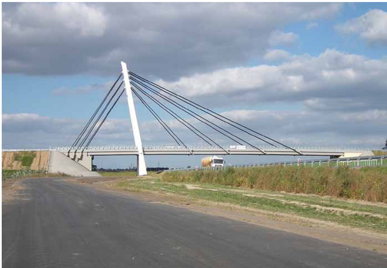
Fot. 1. Wiadukt podwieszony WN-24 nad drogą ekspresową S5 Gniezno – Poznań w końcowej fazie budowy.
