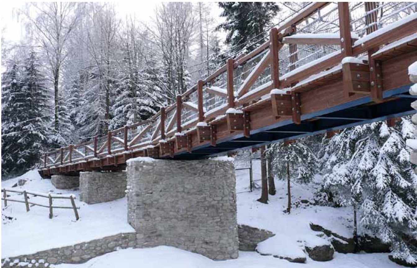
Fot. 5. Kładka z drewna egzotycznego bongossi nad rzeką Kamienną w Szklarskiej Porębie.
