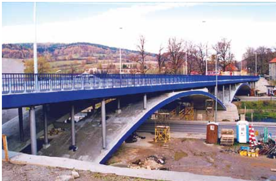
Most Drogowy nad rzeką Biała Łądecka w Łądku Zdroju.
