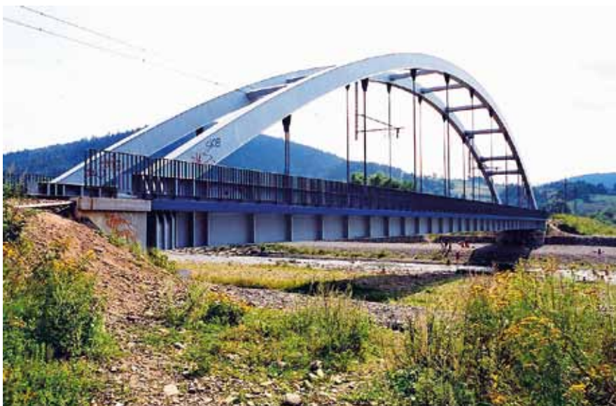
Most kolejowy nad rzeką Sołą w Milówce w ciągu linii PKP Katowice - Zwardoń na odcinku Bielsko-Biała - Zwardoń w km 93,283.
