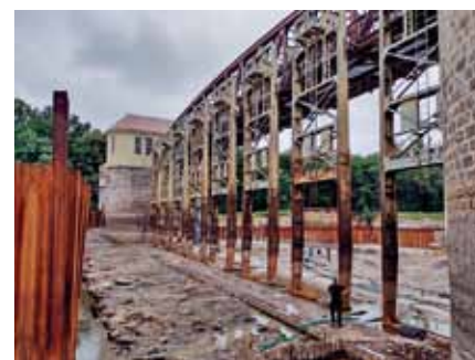
Fot. 3. Prowadnice zasuw przed remontem.
