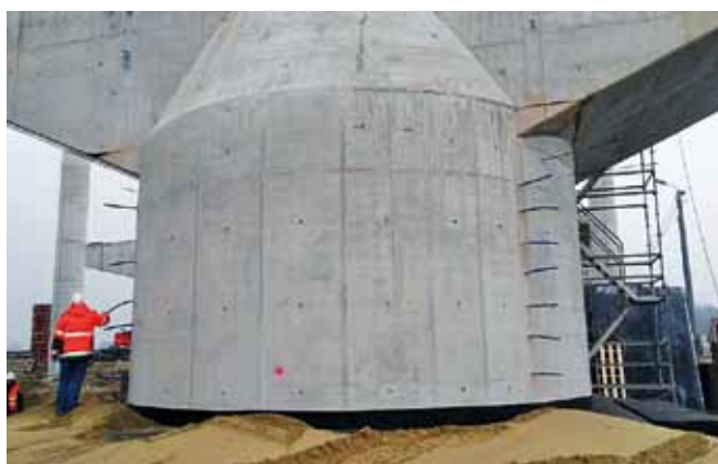
Fot. 1 i 2. Ubocznym efektem przyjętej technologii była wysoka jakość powierzchni betonu z cementem hutniczym
