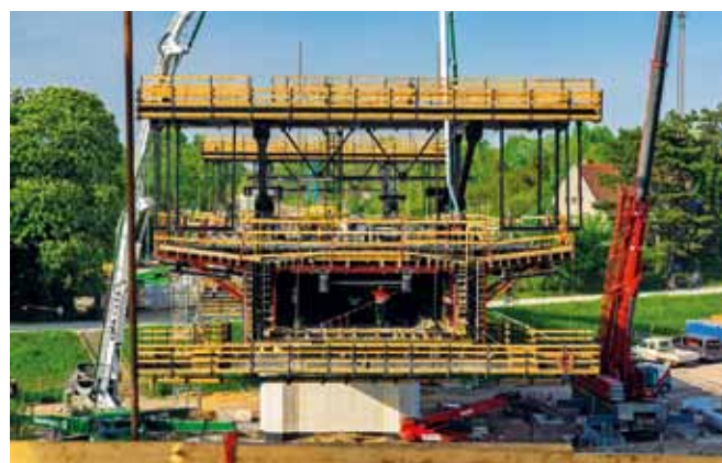
Widok wózka nawisowego od strony podpory 9 - obiekt MD-2
