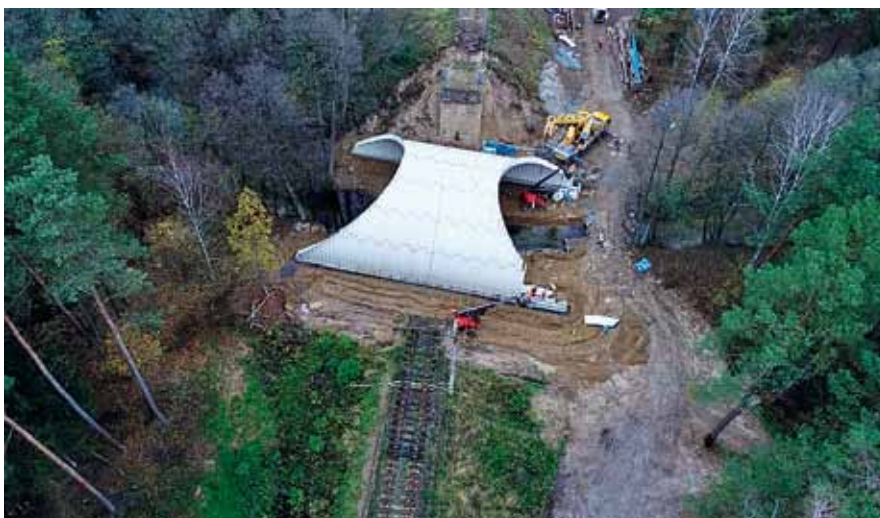
Fotografia 4. Zmontowana powłoka stalowa.
