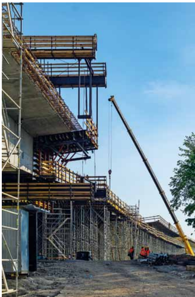
Widok estakady dojazdowej obiektu MD-2 od str. ul. Międzyrzeckiej
