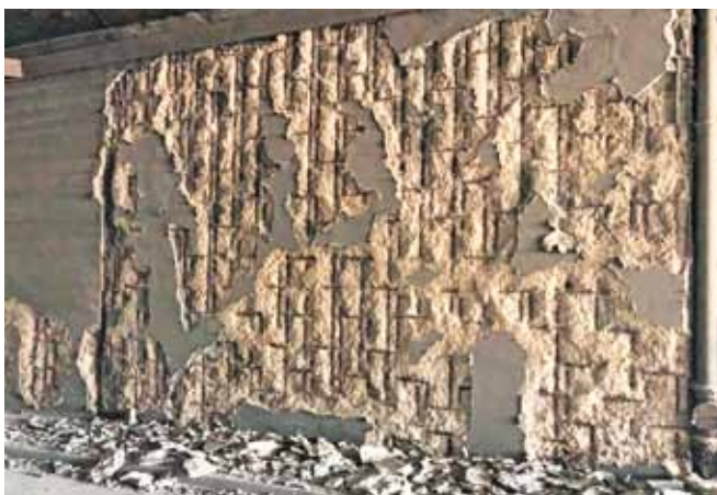
Fot. 5. Pręty zbrojeniowe przygotowane do montażu protektorów cynkowych
