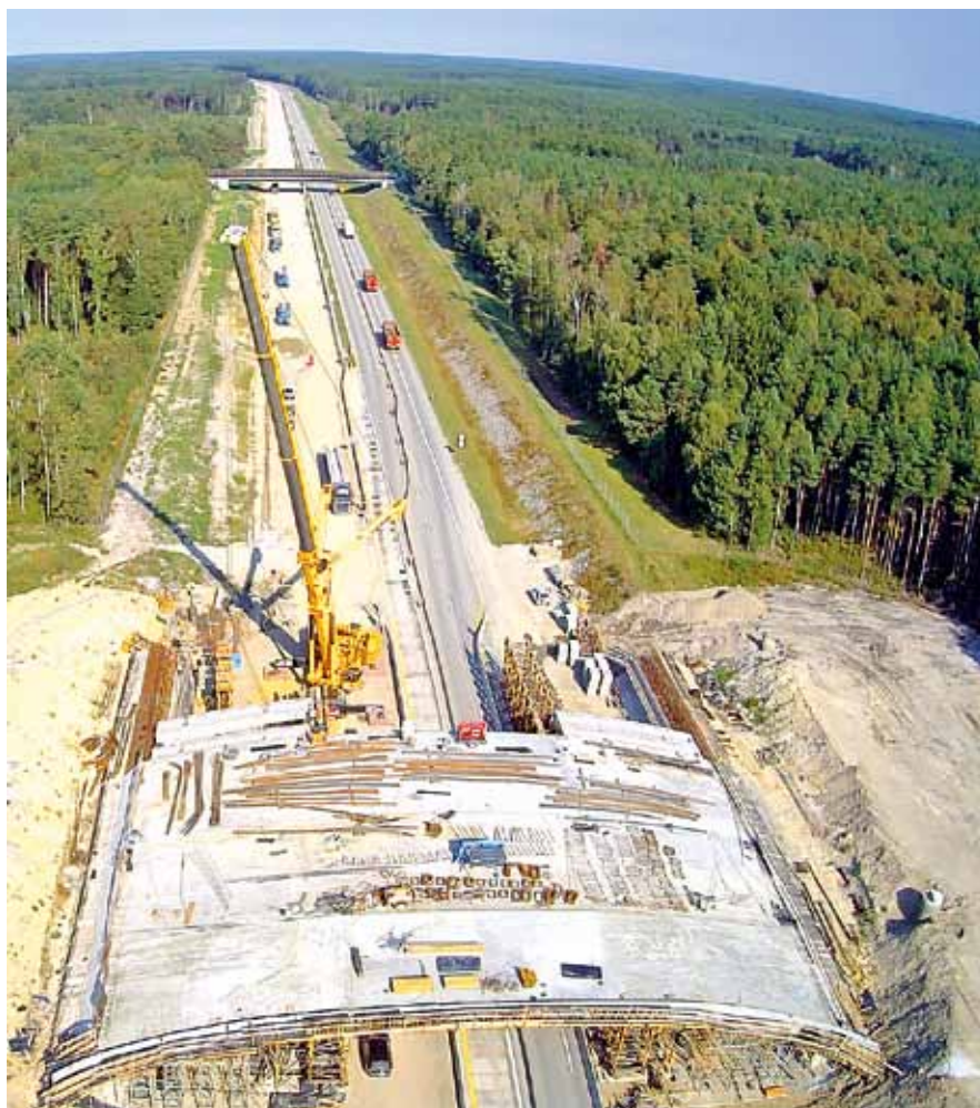
Montaż belek na PZ-19a
