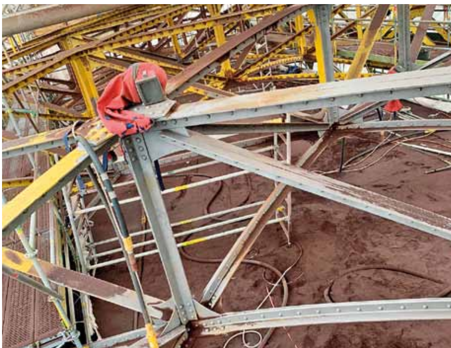
Most Zwirzyński – czyszczenie konstrukcji stalowej
