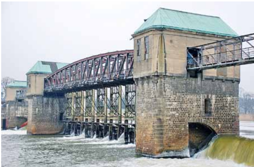
Fot 4. Przęsło środkowe jazu, zasuwowe – stan przed remontem.
