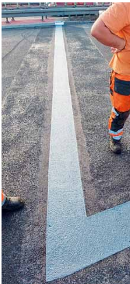
Wymiana dylatacji na wiadukcie DK 11 w Kurniku
