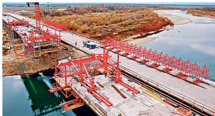
Fot. 9. Pierwsze w Polsce użycie kompletnego systemu PERI VBC w technologii betonowania wspornikowego – MA 78 autostrada A4.
