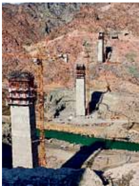
Fot.19. Most zaporowy w Turcji – realizacja filarów o wysokości ponad 140 m oraz ustrój nośny przy użyciu wózka PERI VBC.
