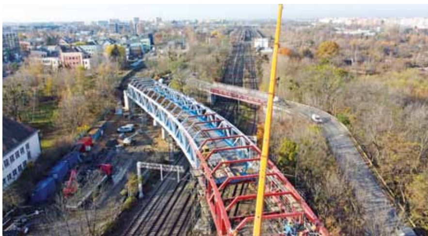
Wrocław – Trasa Autobusowo-Tramwajowa nad torami kolejowymi ul. Strzegomska.
