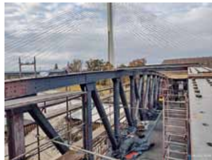
Fot. 22. Demontaż zwiatrowań górnych kratownicy.
