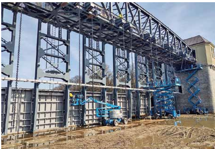
Fot. 26. Montaż łańcuchów prowadnic.
