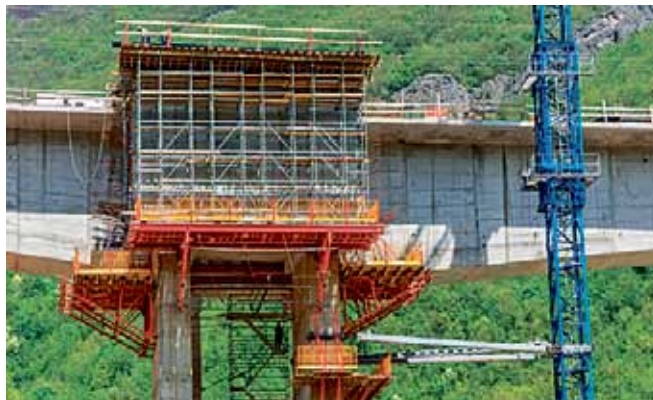
Fot. 15. Realizacja segmentu startowego dla drugiej nitki przy użyciu poziomo zamontowanych kozłów SB.
