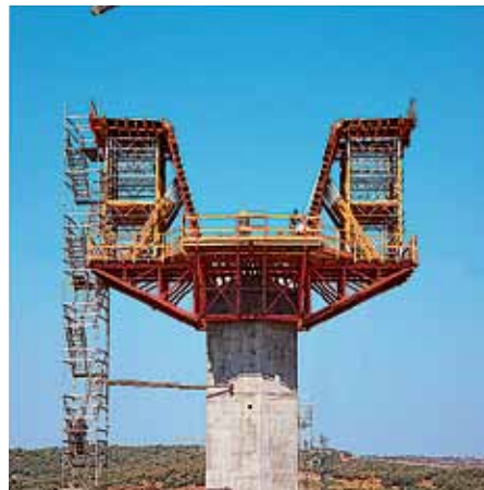
Fot. 5. Poziomo zakotwione koźły oporowe PERI SB przenoszą obciążenia na zabetonowany filar.
