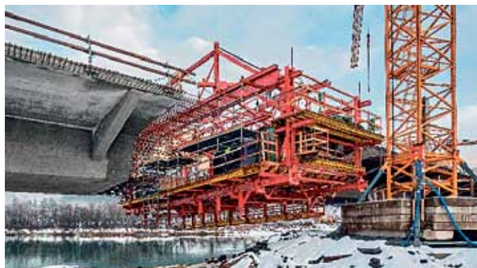
Fot. 12. Podczas przemieszczania wózka VBC cały czas zagwarantowane jest pełne bezpieczeństwo w jego otoczeniu.
