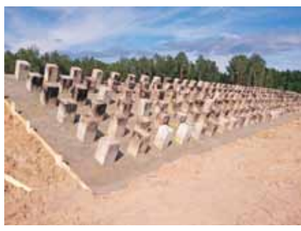
PZ-14a posadowienie pośrednie pale pogrążone w gruncie
