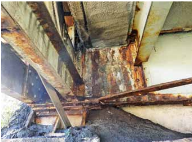
Rys. 8. Uszkodzenia poprzecznic w strefach przywęzłowych
