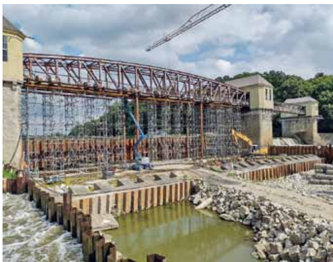
Fot 6 i 7. Etapy remontu mostu jazowego, zamknięć zasuwowych i wzmocnienia ponuru poniżej jazu. Źródło: Naviga-Stal.
