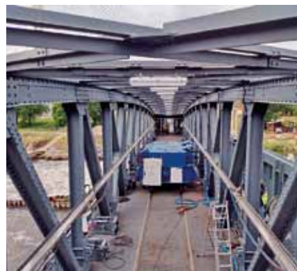
Fot. 25. Montaż prowadnic.
