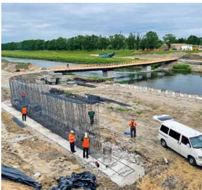
Fot. 3. Prace zbrojarskie przyczółka w osi „A” mostu południowego.
