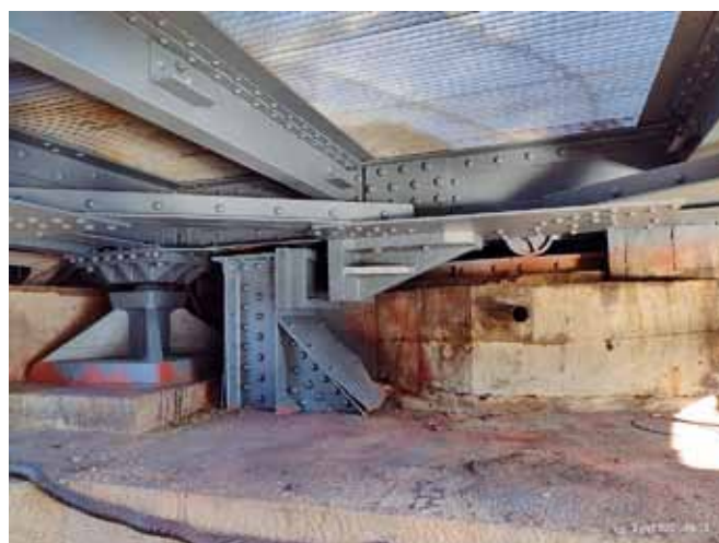
Fot. 19. Łożysko po remoncie.
