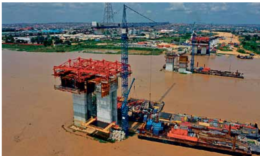
Fot. 2. Przykładowy teren wymagający zastosowania technologii betonowania wspornikowego ustroju nośnego.
