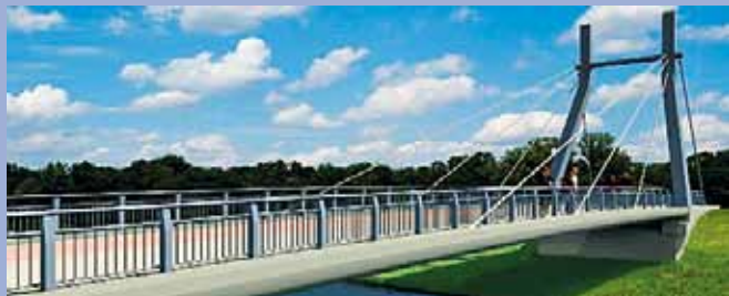
Przebudowa drogi krajowej nr 94, ul. Lotnicza we Wrocławiu
