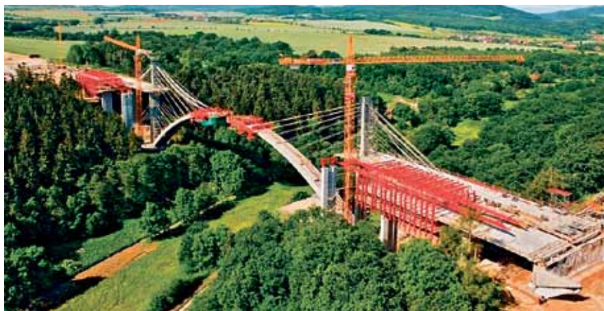
Fot. 7. Urządzenia formujące przy wykonywaniu łuków metodą wspornikową nad doliną Oparno (2008r).
