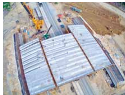
PZ-14a montaż belek korytkowych widok z góry
