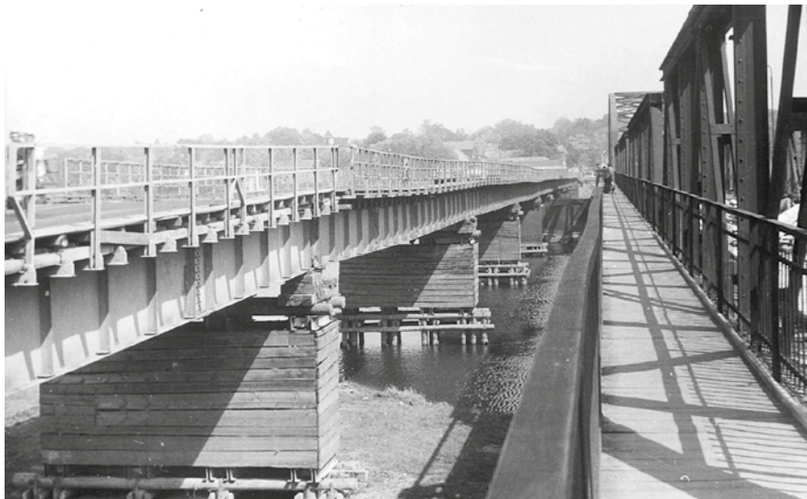
Rys. 5. Widok na przebiegający równolegle most tymczasowy, rozebrany w 1987 r.
