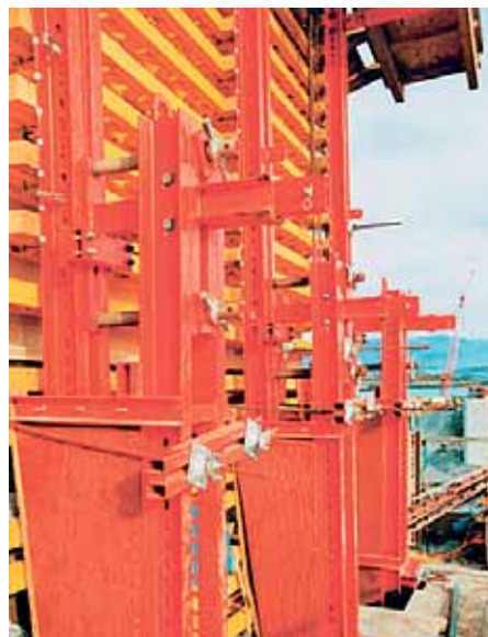
Fot. 6. Zmieniający się przekrój poprzeczny. Podwieszona konstrukcja deskowania z regulacją wysokości ukosu.
