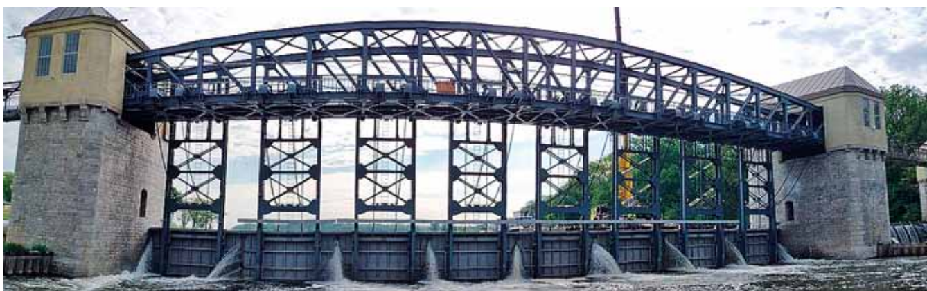
Fot. 27. Most z jazem po remoncie – oddany do eksploatacji.
