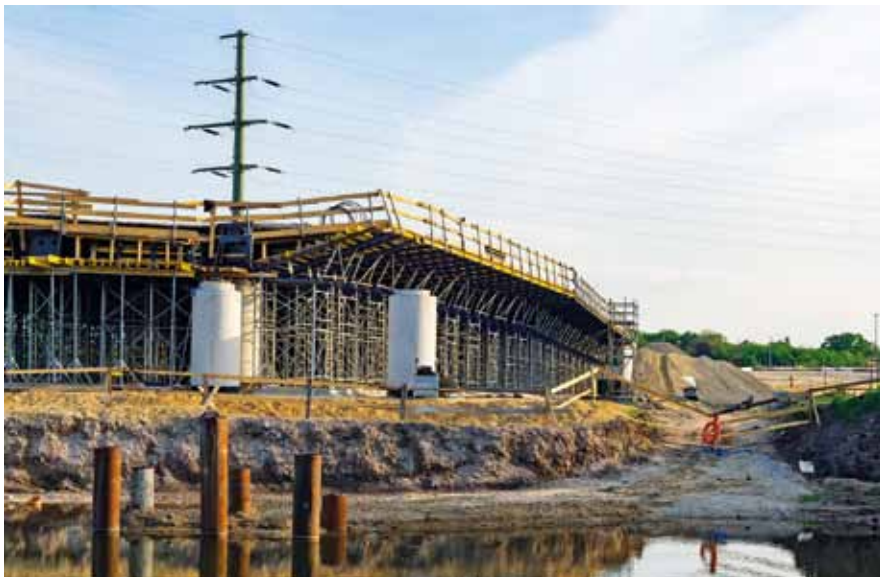
Obiekt MD-1 nad rzeką Oławą prześła od str. ul. Wilczej
