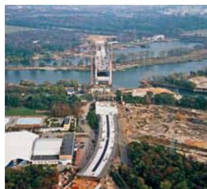
Wrocław – ul. Milenijna – budowa estakad i mostów nad rz. Odrą część nurtowa metodą wantung i nawisową.
