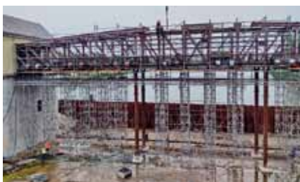
Fot. 12. Widok na remontowany most z żurawia.
