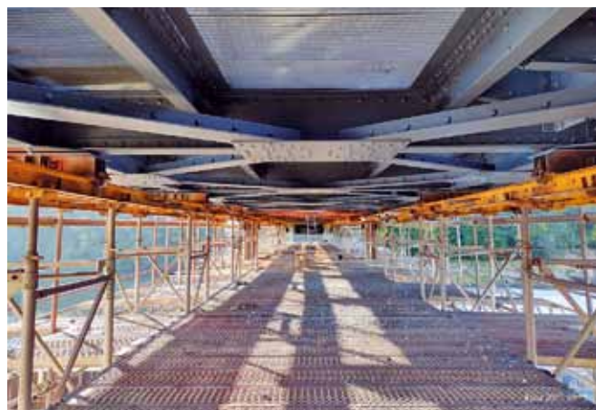
Fot. 18. Pasy dolne kratownicy po remoncie
