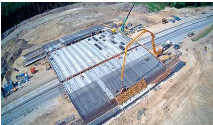
PZ-14a betonowanie węzłowi segment środkowy strona PN
