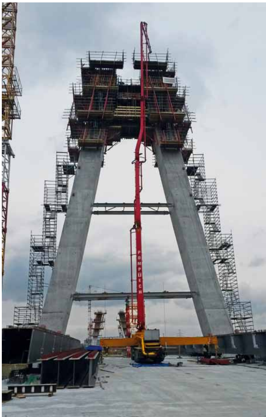
Fot. 6. Formowanie ostatniego segmentu 50-metrowego pylonu
