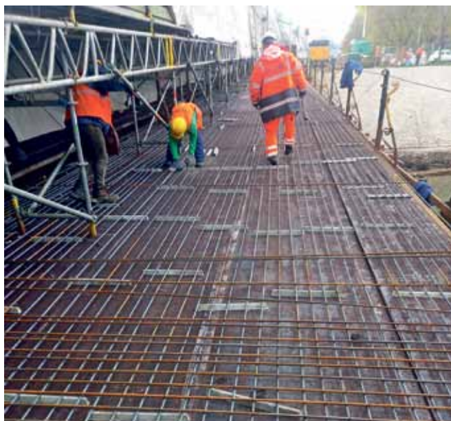
Zbrojenie płyty
