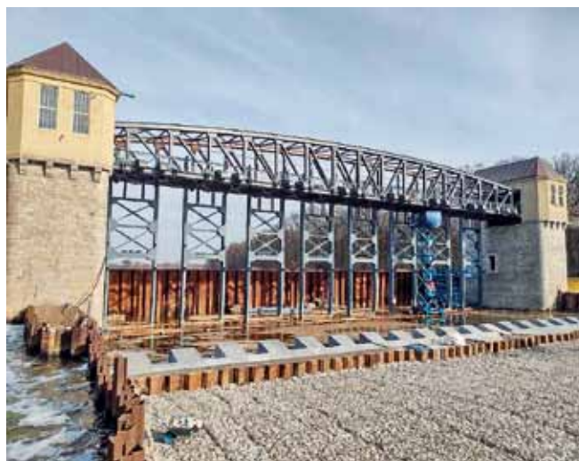
Fot 6 i 7. Etapy remontu mostu jazowego, zamknięć zasuwowych i wzmocnienia ponuru poniżej jazu. Źródło: Naviga-Stal.
