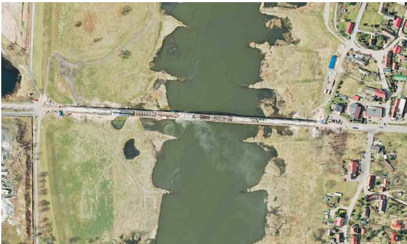
Rys. 9. Zdjęcie lotnicze mostu w czasie prac remontowych (źródło: mapy.geoportal.gov.pl)
