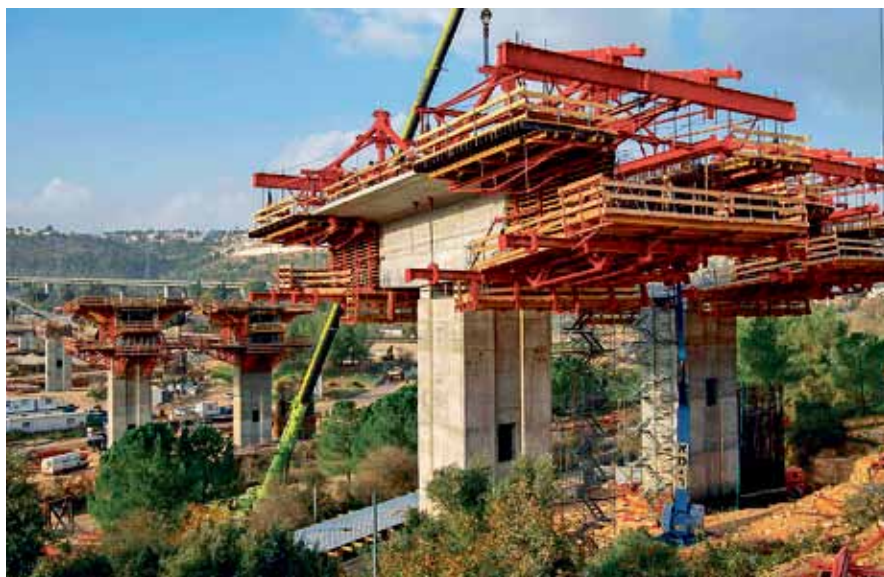
Fot.18. Road 16 w Izraelu – pochylenie obiektu rozwiązane przy pomocy hamulca do przetaczania wózków VBC.
