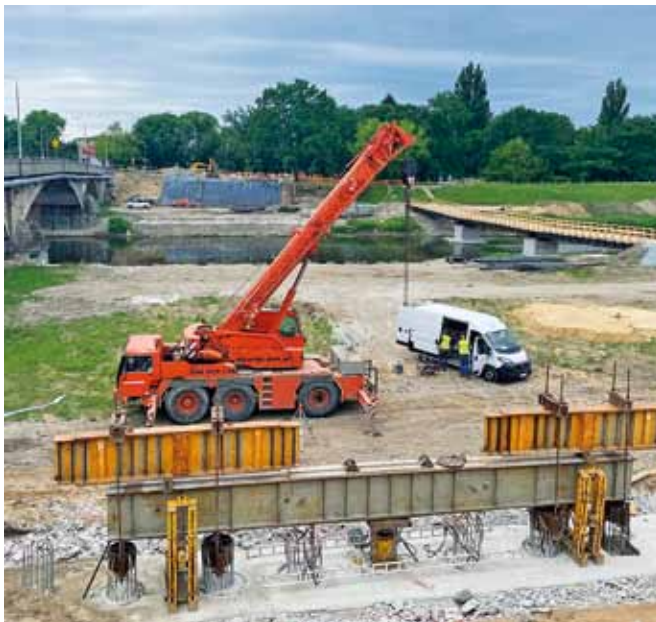
Fot. 1. Widok na prace w obrębie mostu południowego (na pierwszym planie próbné obciążenie przyczółka w osi „D” mostu południowego).
