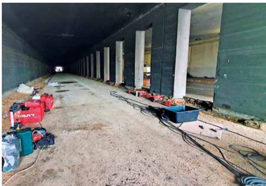
Fot. 3 Widok na nawę środkową wiaduktu
