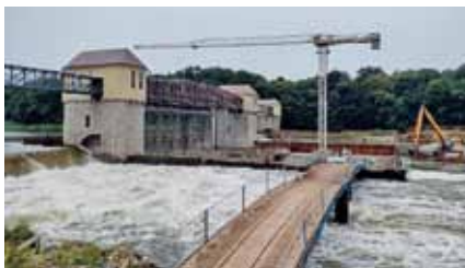
Fot. 11. Widok na remontowany most od strony wody dolnej.
