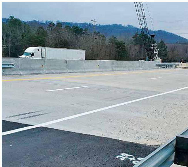
6. Zjazd 112 z drogi I-40 w Mineral Springs.
