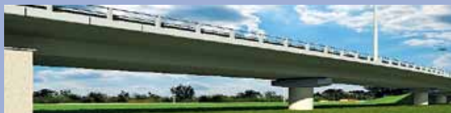
Budowa drogi łączącej autostradę A-4 z Portem Lotniczym (Oś Inkubacji) we Wrocławiu
