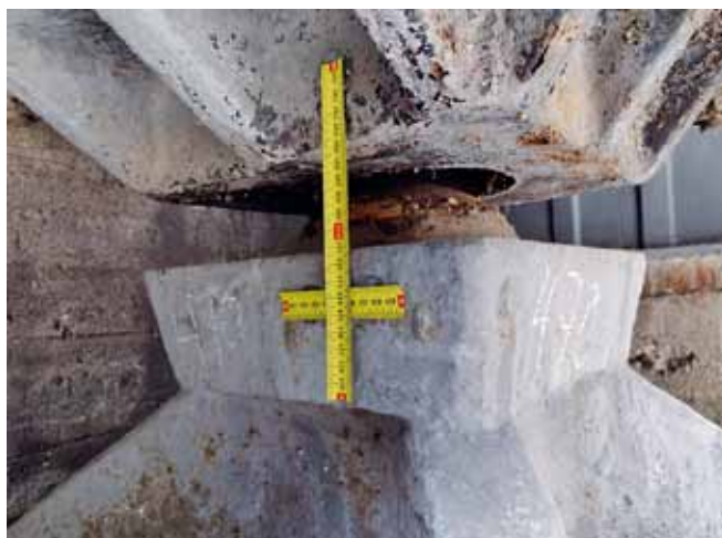
Fot. 8. Oderwanie mostu od łożysk podporowych.
