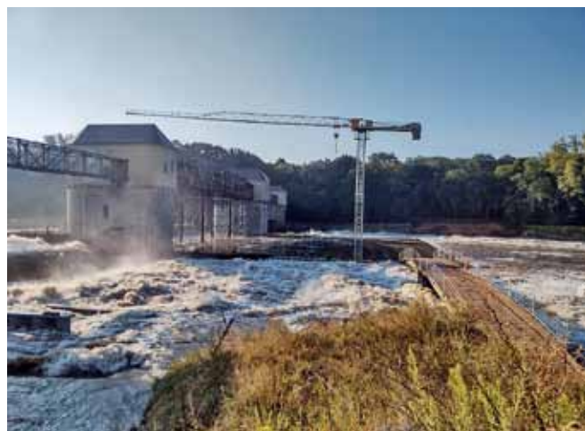
Fot. 17. Zalane grodzysze przy przejściu wysokiej wody.
