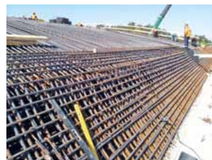
PZ-14a montaż zbrojenia węzłowi
