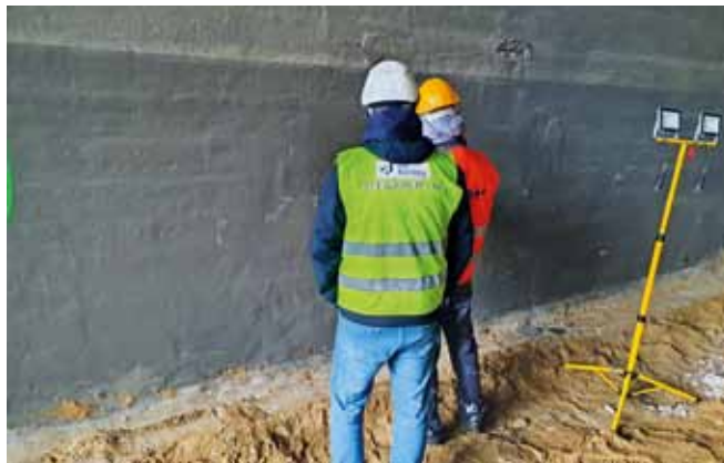
Fot. 2 Skanowanie konstrukcji
