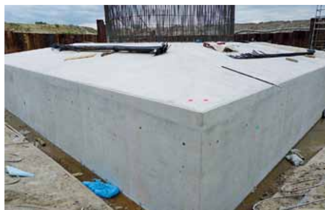
Fot. 1 i 2. Ubocznym efektem przyjętej technologii była wysoka jakość powierzchni betonu z cementem hutniczym
