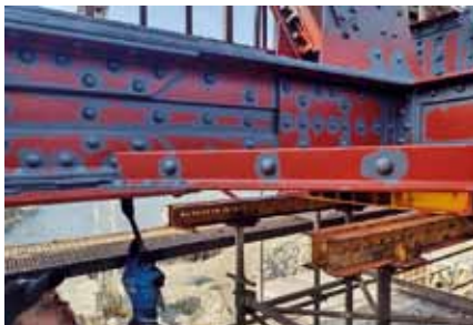
Fot. 21. Roboty antykorozyjne na moście.
