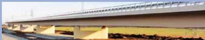
Wschodnia Obwodnica Wrocławia. Budowa drogi wojewódzkiej Bielany - Łany - Długoleka, etap IV - odc. od DK nr 94 do DW nr 455.
