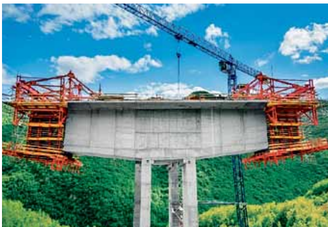
Fot. 1. Wózki PERI VBC zamocowane do segmentów wcześniej wykonanych.
