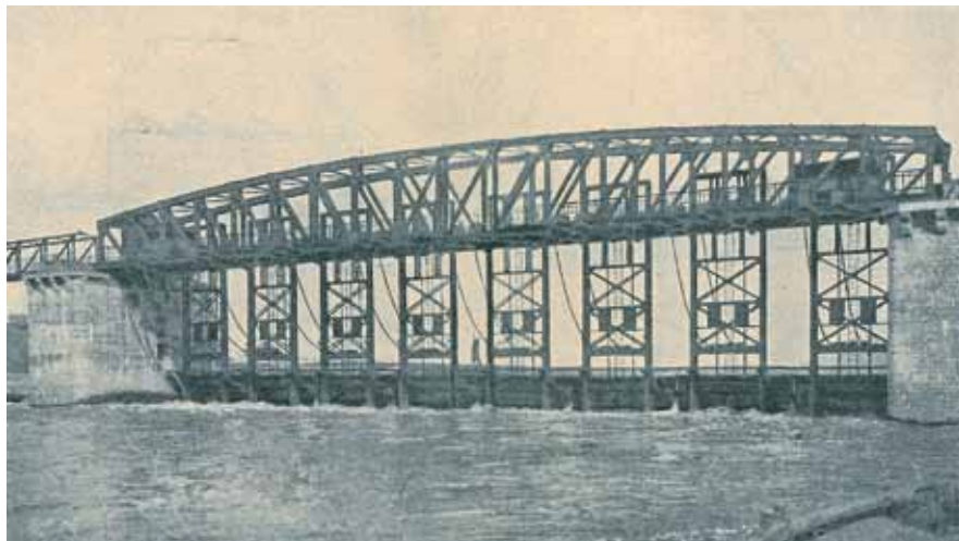
Fot 3. Przęsło środkowe jazu, zasuwowe po budowie w 1924 roku. Źródło: Schulte E.H. Zeischrift fur Bauwesen, 74, s. 21-29.
