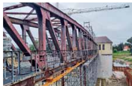
Fot. 13. Montaż rusztowań bocznych od strony wody górnej.
