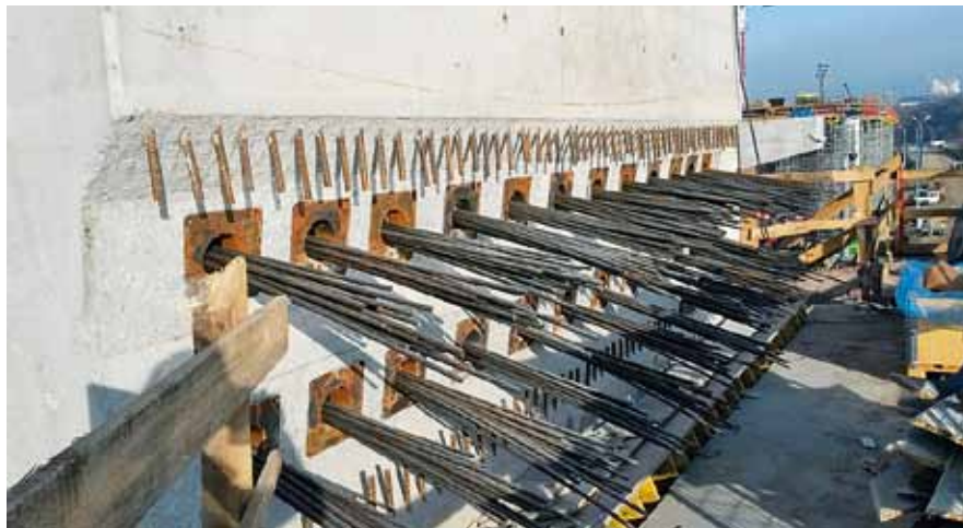
Fot. 5. Widok strefy zakotwień kabli sprężających rygla podpory H, strona prawa
