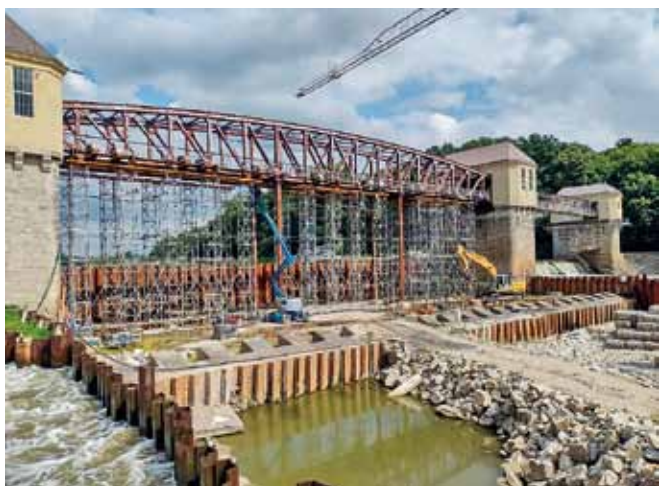
Fot. 7. Montaż wieży podporowych T-60.
