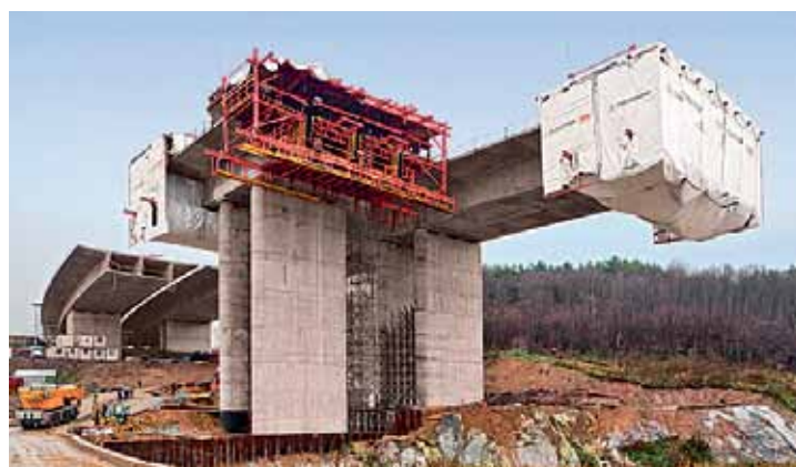
Fot. 9. Pierwsze w Polsce użycie kompletnego systemu PERI VBC w technologii betonowania wspornikowego – MA 78 autostrada A4.
