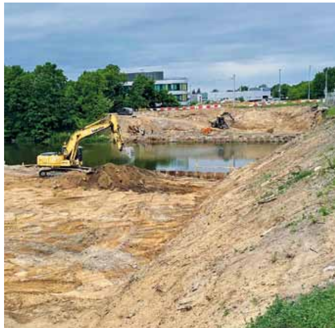
Fot. 2. Prace zimne w obrębie mostu północnego.
