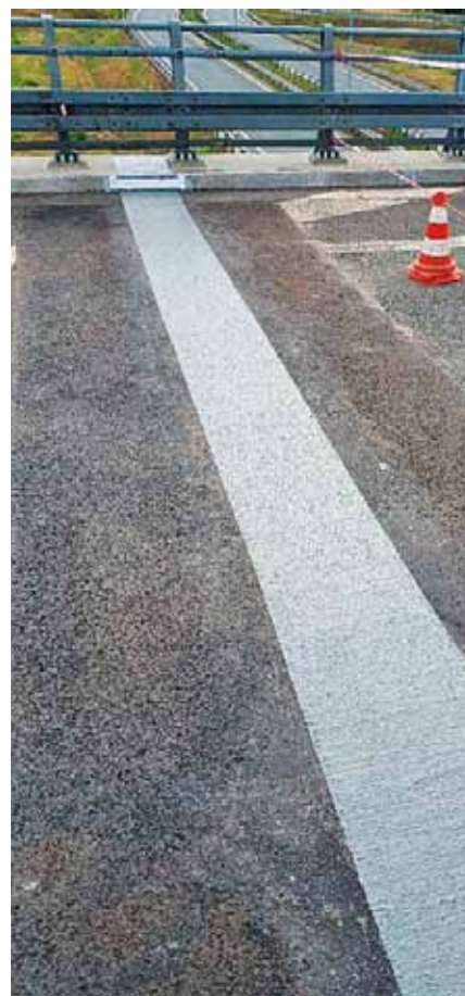
Wymiana dylatacji na wiadukcie WA19 w ciągu autostrady A4.
