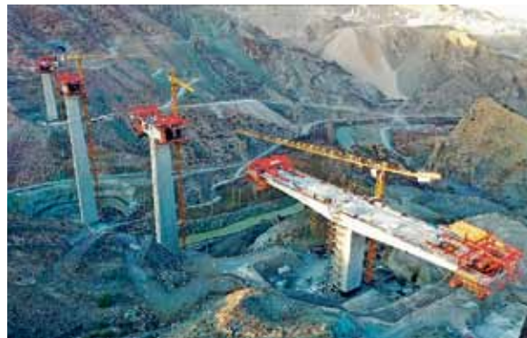
Fot.19. Most zaporowy w Turcji – realizacja filarów o wysokości ponad 140 m oraz ustrój nośny przy użyciu wózka PERI VBC.
