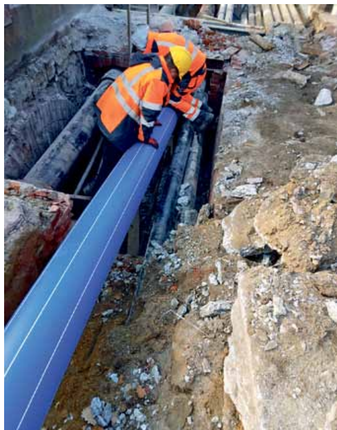
Renowacja magistrali wodociągowej-metoda
