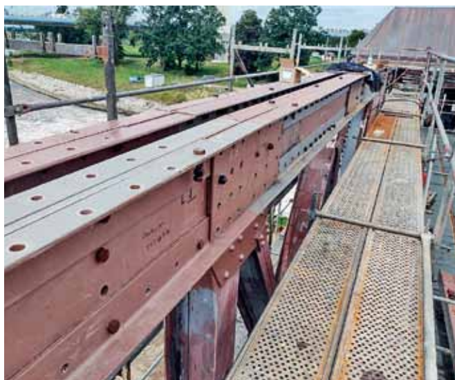
Fot. 14. Wymiana elementów pasa górnego kratownicy.
