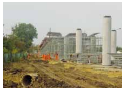
Wrocław – ul. Klecińska – estakady i wiadukty drogowe nad torami kolejowymi.
