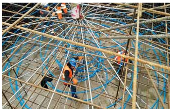
Fot. 3 i 4. Instalacja chłodzenia wewnętrznego słupów
