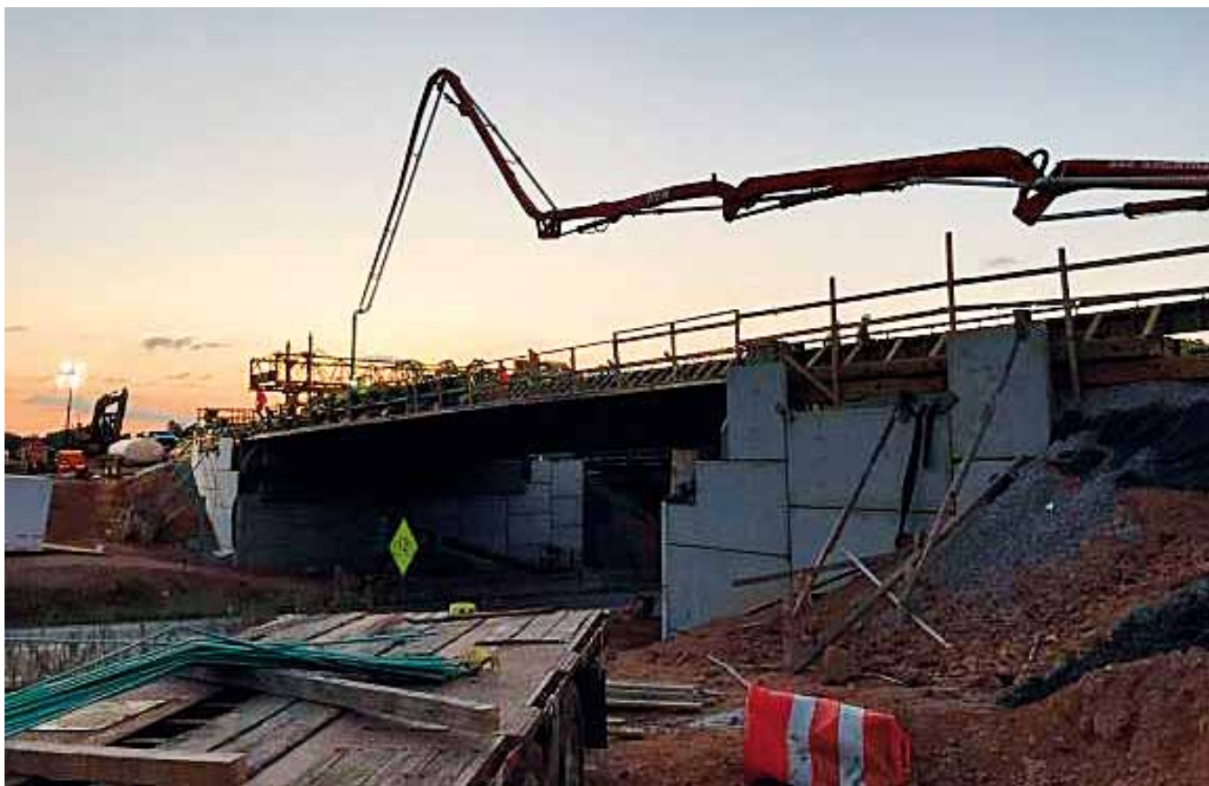
7. Zjazd 112 z drogi I-40 w Mineral Springs.
