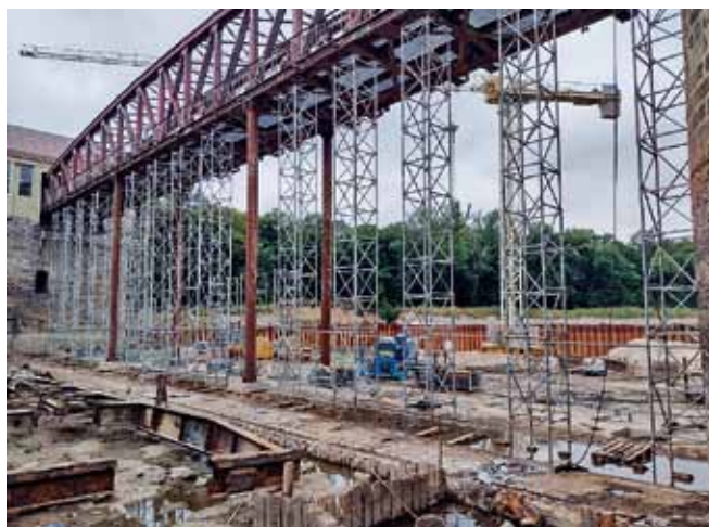
Fot. 6. Montaż wieży podporowych T-60.
