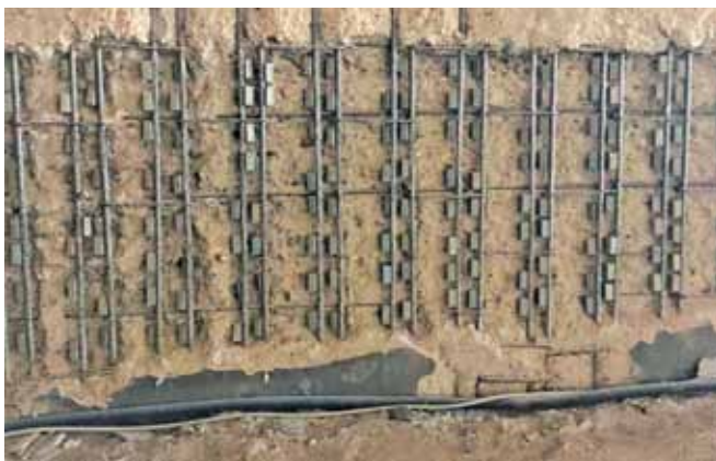
Fot. 6. Rozmieszczenie protektorów na zbrojeniu na nawie środkowej wiaduktu
