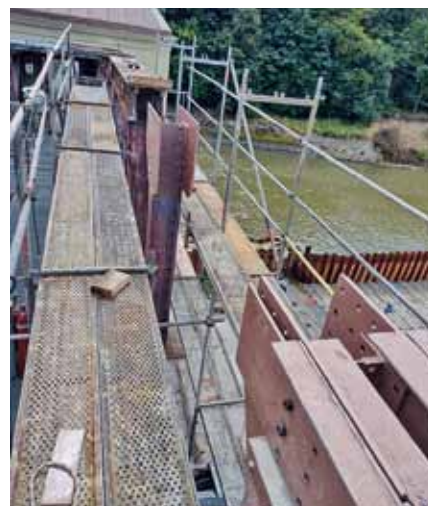
Fot. 10. Rozbiórka elementów pasa górnego kratownicy.
