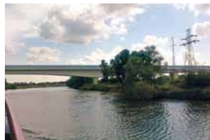
Łany – część nurtowa mostu nad rz. Odrą budowana metodą nawisową w ciągu drogi Bielany-Łany-Długołęka.
