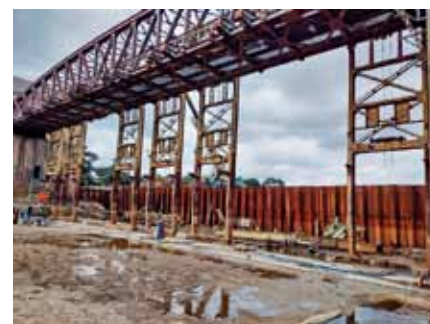
Fot. 4. Demontaż prowadnic zasuw jazu.
