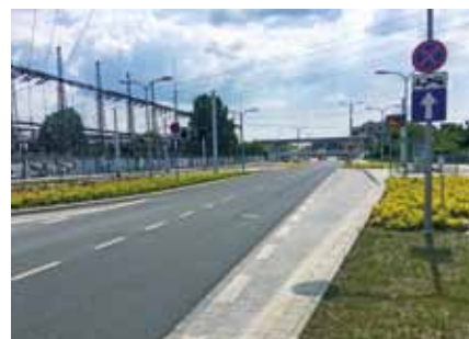
Wrocław – ul. Długa-Starogrobłowa – drogi, torowisko tramwajowe, wiadukt kolejowy.
