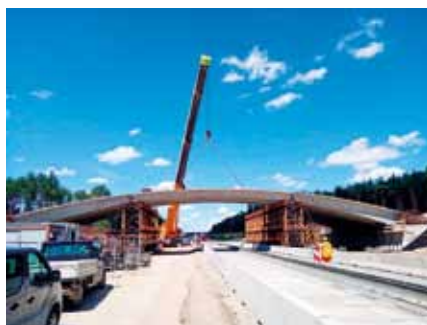
PZ19a - montaż belek prefabrykowanych
