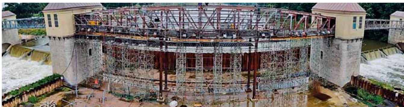
Fot. 16. Widok na remontowany jaz z żurawia – panorama.
