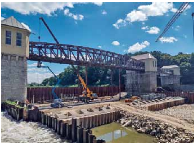
Fot. 5. Montaż wież podporowych T-60.
