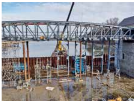
Fot. 24. Demontaż wież podporowych T-60.
