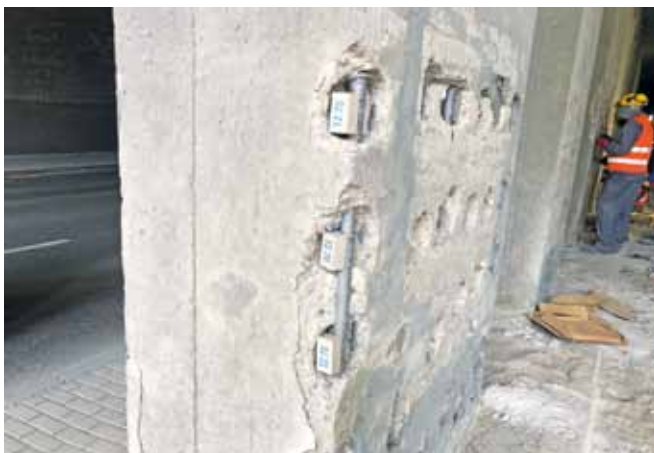
Fot. 7. Protektory cynkowe TopZinc R 70
