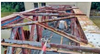
Fot. 9. Pas górny kratownicy przed demontażem.
