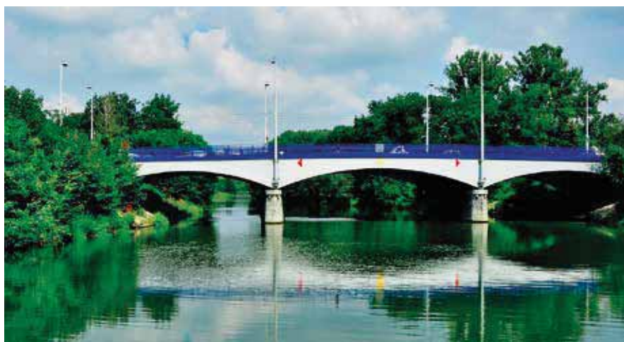
Rys. 10. Most Szczytnicki po przebudowie w 2006 r. Fot. Autor.
