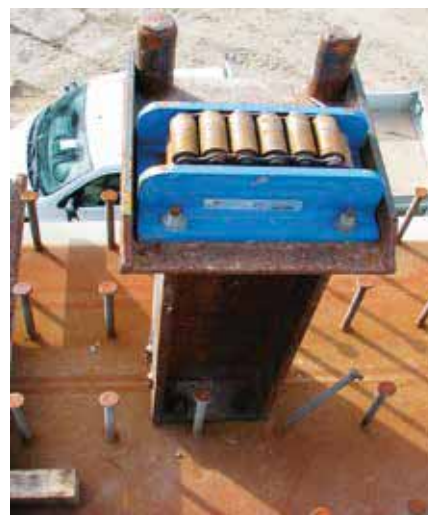
Fot.2. System VCB. Zdjęcie z realizacji (po lewej) oraz podpora t.zw. „krzesło” dla urządzenia jezdnego (po prawej). Zdjęcia: PERI SE.
