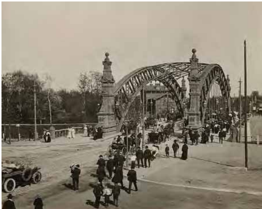
Rys. 13. Most Zwierzyniecki (1895-1897) – (Passbrücke - Przepustkowy) na fotografii z pocz. XX wieku. Widok od strony wschodniej, repr. z: Łagiewski Maciej, Mosty Wrocławia , Wydawnictwo Dolnośląskie, Wrocław 2004, s. 108.
