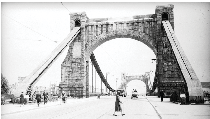
Rys. 12. Widok ogólny Mostu Grunwaldzkiego po odbudowie, 1948 r. (źródło: Narodowe Archiwum Cyfrowe)
