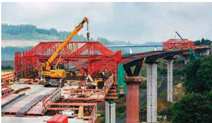
Fot.2. System VCB. Zdjęcie z realizacji (po lewej) oraz podpora t.zw. „krzesło” dla urządzenia jezdnego (po prawej). Zdjęcia: PERI SE.
