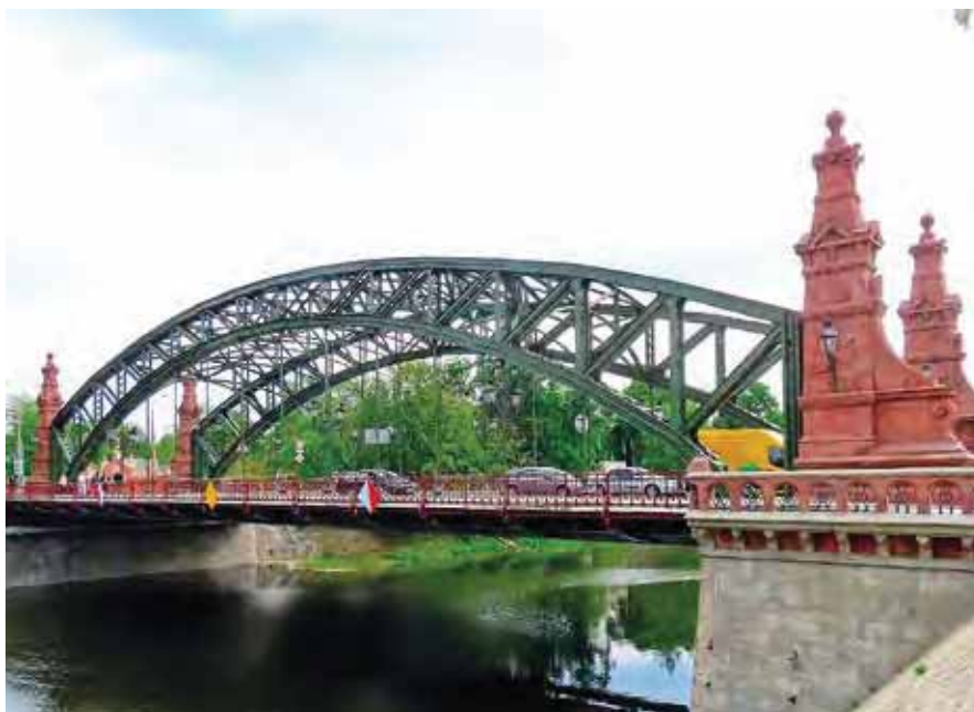
Rys. 14. Most Zwierzyniecki – stan po remoncie. Fot. Leszek Budych.
