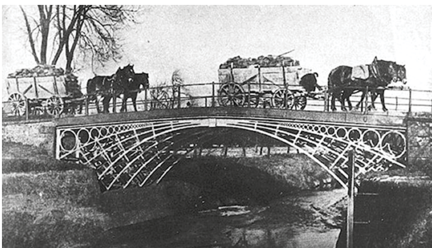
Rys. 5. Pierwszy na kontynencie europejskim most żelazny, zbudowany nad rzeką Strzegomką w Łazanach w 1796 r.
