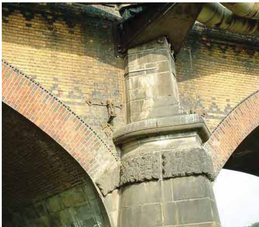
Rys. 10. Filar mostu Osobowickiego Północnego. Stam współczesny. Fot. Leszek Budych
