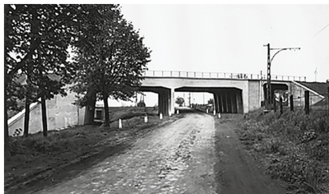
f) Brücke im Zuge der Zubringerstrasse – wiadukt nad ul. Kobierzycką
