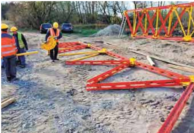
Fot.2. Ręczny montaż na budowie oraz połączenia przy użyciu sworzni. Archiwum: PERI Polska.
