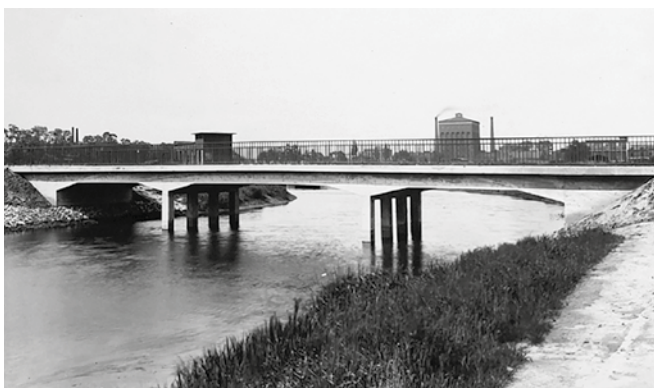
e) Margarethensteg – most na Żabiej Ścieżce
