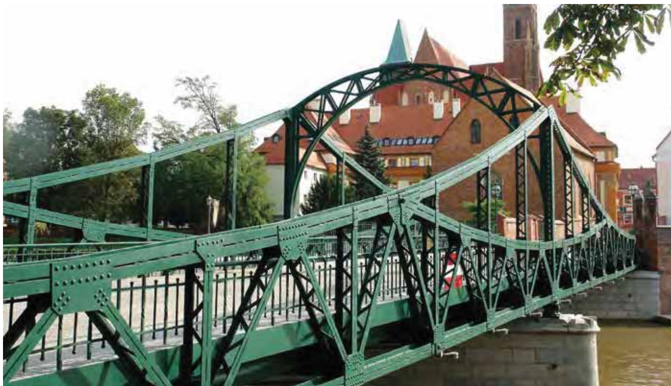
Fot. 19. Most Tumski (Dombrücke) widok stalowej konstrukcji kratownicy. Fot. Autora.
