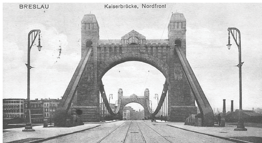
Rys. 14. Wygląd oryginalnych masztów latarni na dojazdach do mostu (źródło: polska-org.pl)
