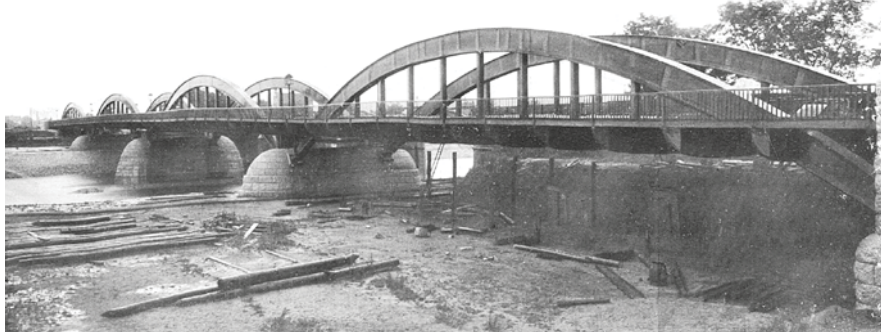
Rys. 9. Widok Mostu Trzebnickiego Północnego w końcowym etapie budowy, 1916 r. (źródło: Biblioteka Cyfrowa Uniwersytetu Wrocławskiego)
