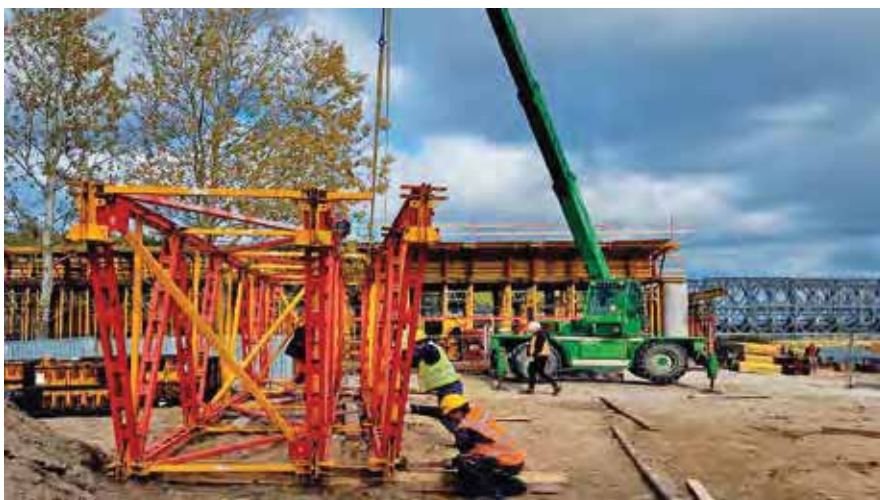
Fot.3. Scalanie pakietu kratownic przy pomocy ładowarki teleskopowej z wysięgnikiem. Archiwum: PERI Polska.
