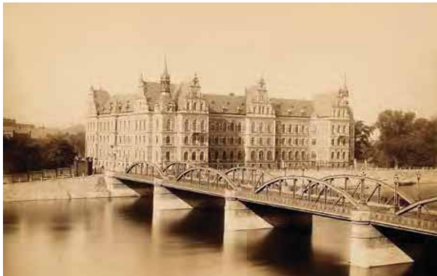
Rys. 2. Most Lessinga (Lessingbrücke) – zniszczony w 1945 r. Repr. Zdjęcie z publicznej domeny Wikimedia - przypuszczalnie z zasobów TU Berlin.
