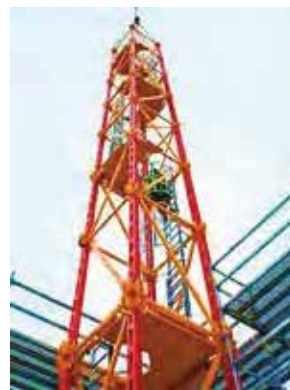
Fot.3. Scalanie pakietu kratownic przy pomocy ładowarki teleskopowej z wysięgnikiem. Archiwum: PERI Polska.
