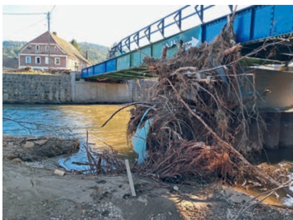
Fot. 9. Stalowy most belkowy w Trzebieszowicach (stan techniczny z 22 września 2024 r.)
