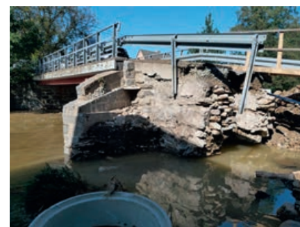
Fot. 3. Zniszczenie wałów przy zaporze wodnej przed Stroniem Śląskim
