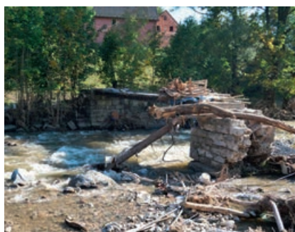
Fot. 3. Zniszczenie wałów przy zaporze wodnej przed Stroniem Śląskim
