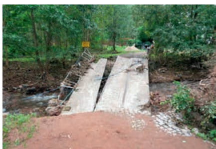
Fot. 12. Zniszczony obiekt mostowy na dojeździe do posesji w Ludwikowicach Kłodzkich (stan techniczny z 27 września 2024 r.)
