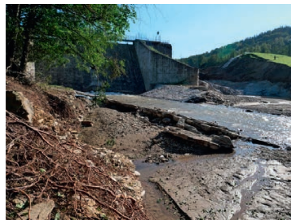
Fot. 3. Zniszczenie wałów przy zaporze wodnej przed Stroniem Śląskim
