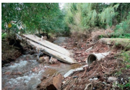
Fot. 12. Zniszczony obiekt mostowy na dojeździe do posesji w Ludwikowicach Kłodzkich (stan techniczny z 27 września 2024 r.)
